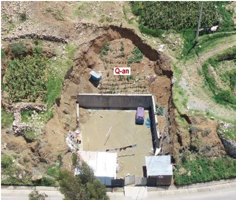
Figura 4. Depósito antropogénico asociado a cortes de talud para la construcción de una nueva vivienda.
