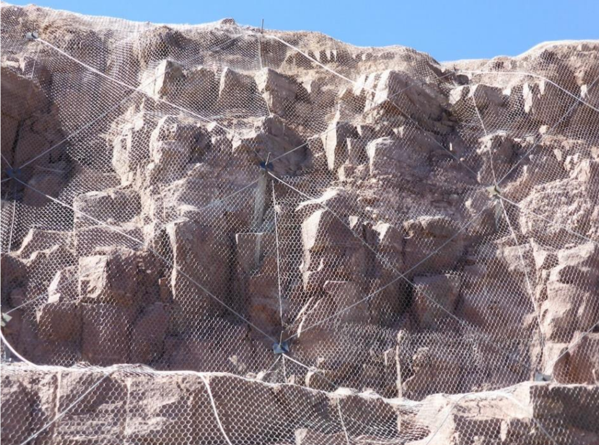
Figura 6. Control de caída de rocas utilizando mallas ancladas.
