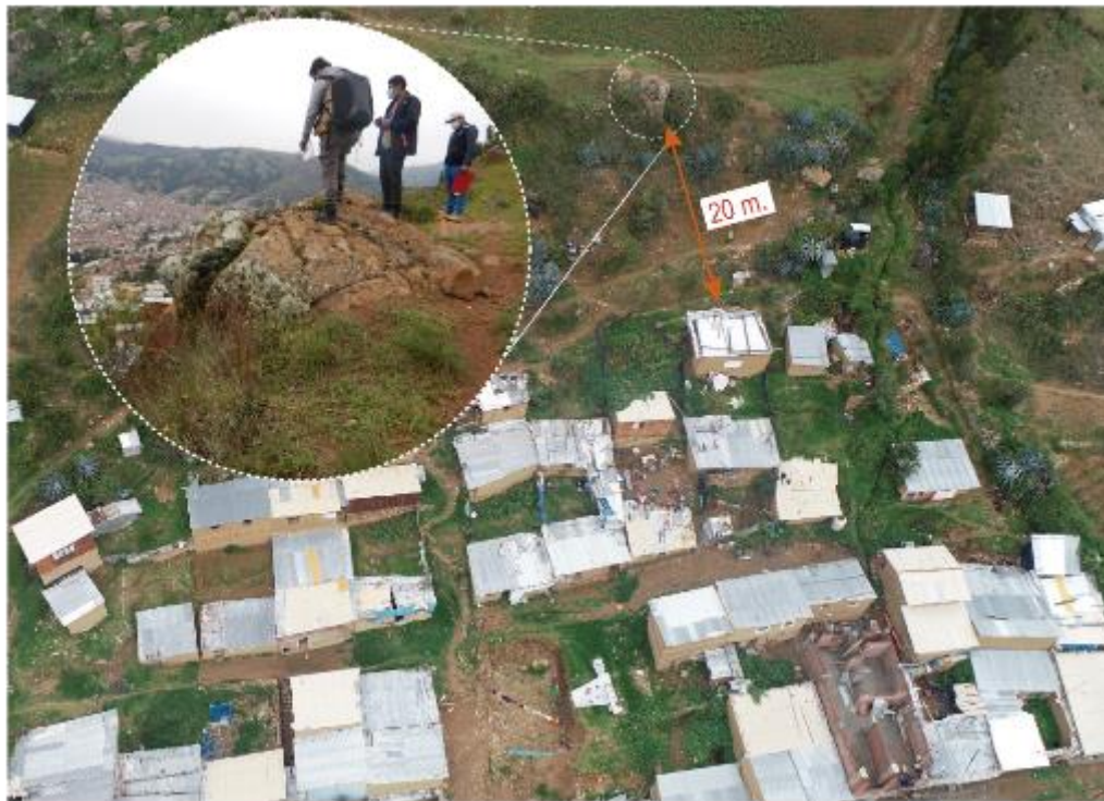
Figura 11. Bloques colgados de hasta 3 m de diámetro, que se encuentra a 20 m de las viviendas, así mismo se pudo evidenciar la presencia de un canal de riego sin revestimiento.
