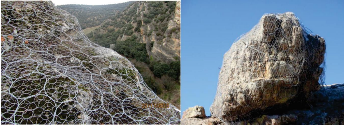
Figura 8. Ejemplos de estabilización con red de anillos
