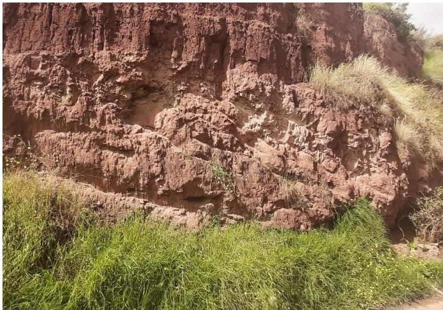
Fotografía 2 :Depósito limo arcilloso
