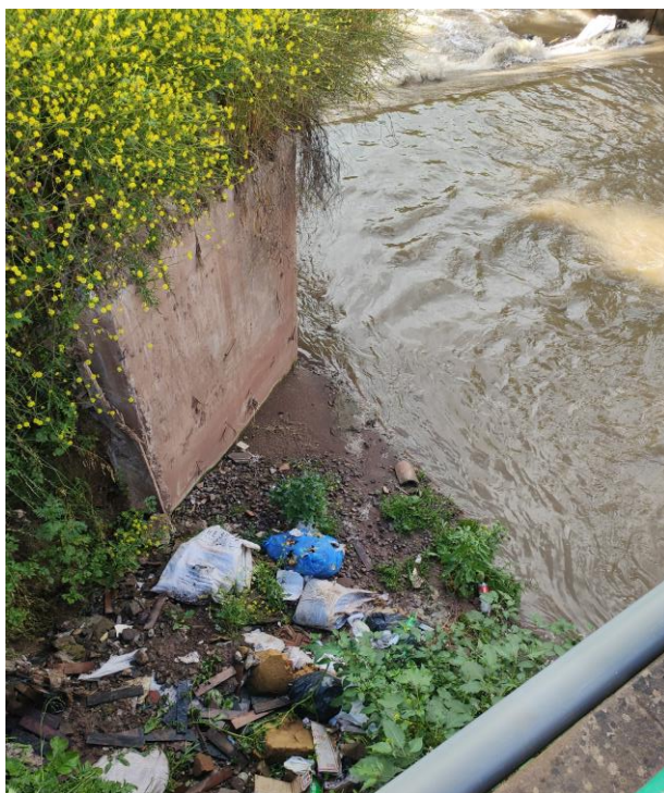
Fotografía 2: Se observa residuos sólidos en la calle V dentro del ámbito de influencia de la ZRESA05.
