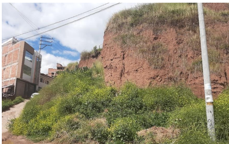
Fotografía 11: Pendiente escarpada, talud abrupto
