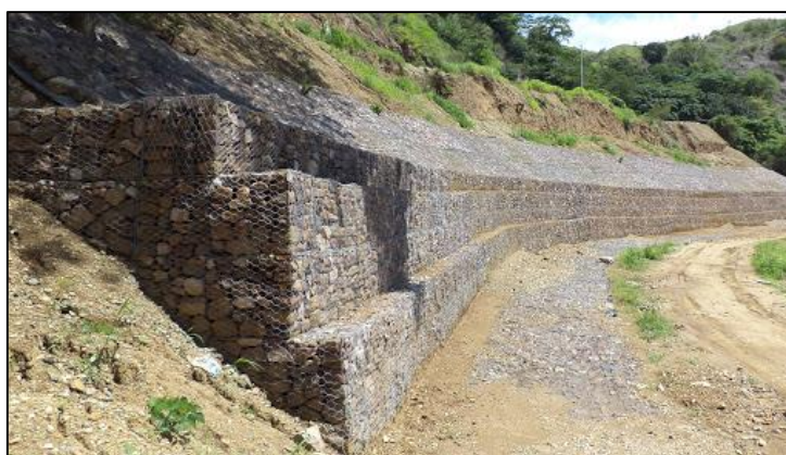
Imagen 15: Muro de contención con gaviones
