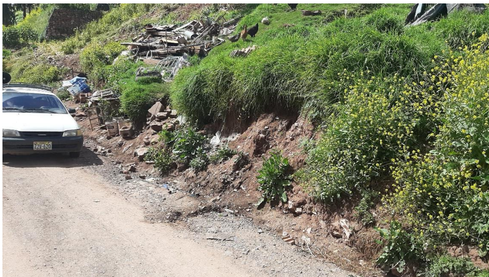
Fotografía 1: Zona de evacuación de aguas pluviales sin tratamiento y amontonado de residuos.
