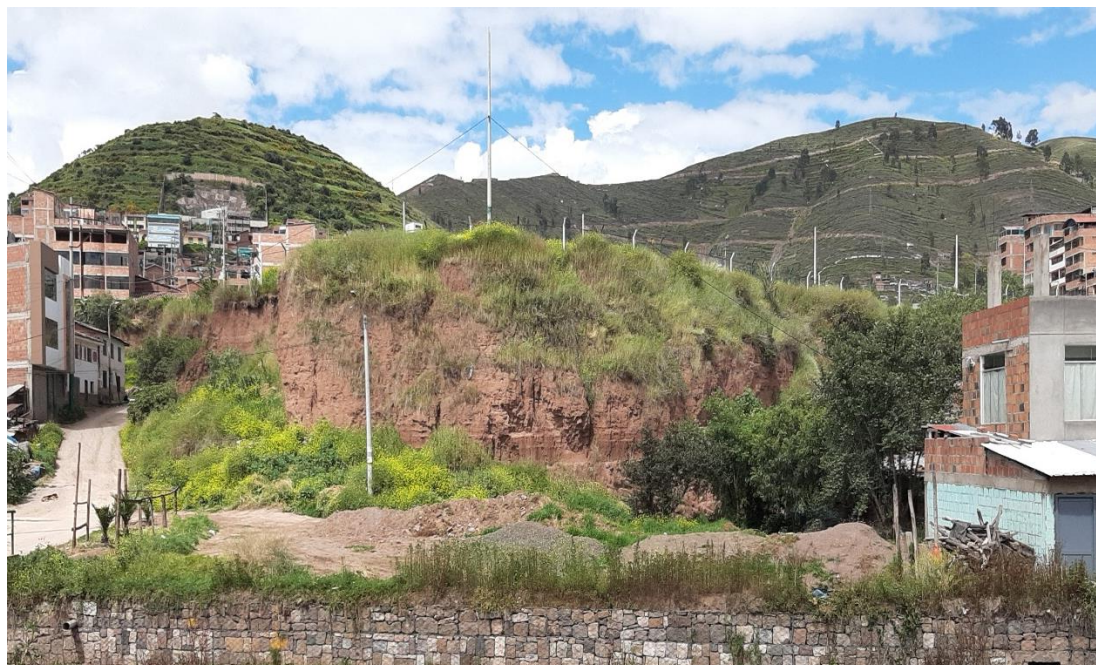
Fotografía 3.- Ladera escarpadas de la ZRESA05
