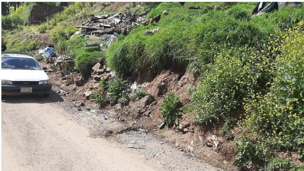
Fotografía 1: Zona de evacuación de aguas pluviales sin tratamiento y amontonado de residuos.
