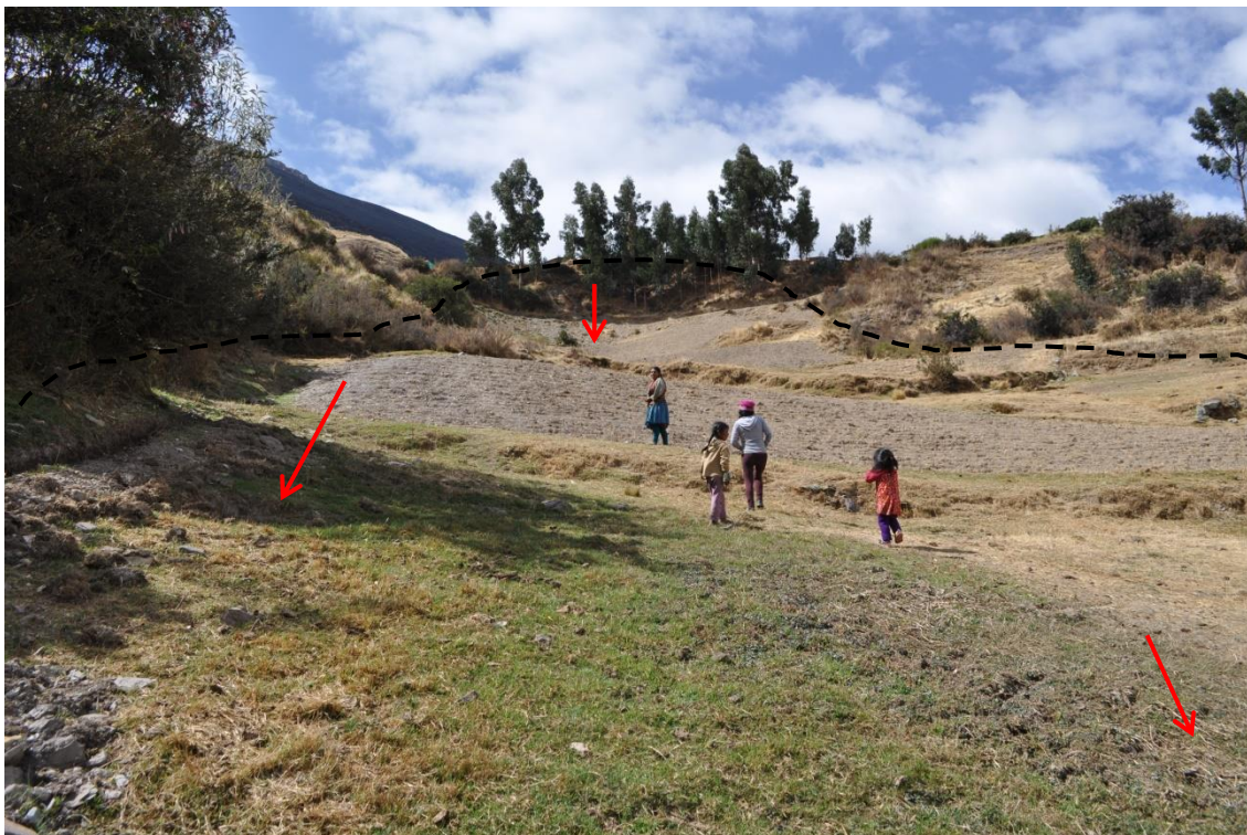
Vista de la parte media del deslizamiento activo (DAH-3). Sector Huancané.
