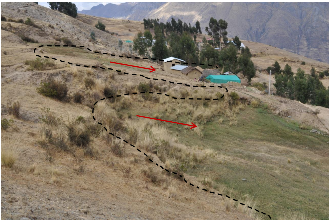
Viviendas ubicadas sobre el Deslizamiento activo (DAH-1) sector de Huancané (UTM: 230,355.62E; 8'464,899.2N). Las flechas rojas muestran la dirección del deslizamiento.
