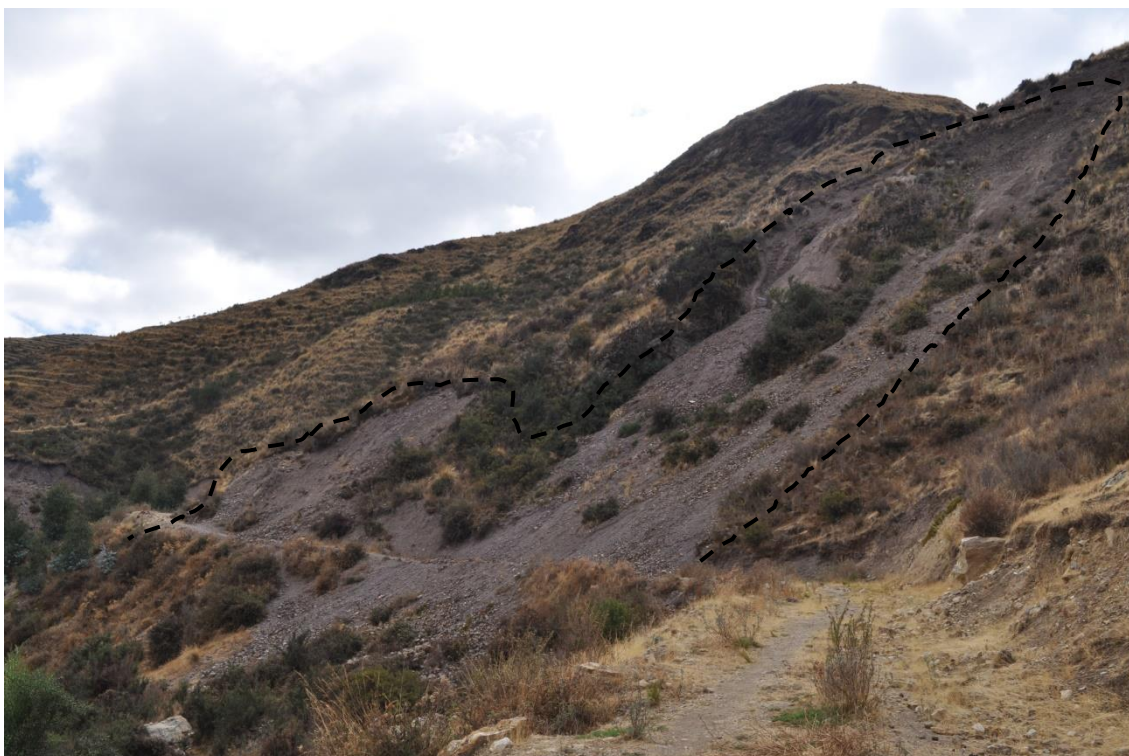
Deslizamiento activo (DAH-6) sector de Huancané (UTM: 230,780.8E; 8'465,417.42N), se puede observar material deslizado (roca) producto de la inestabilidad por la construcción de la vía de acceso.
