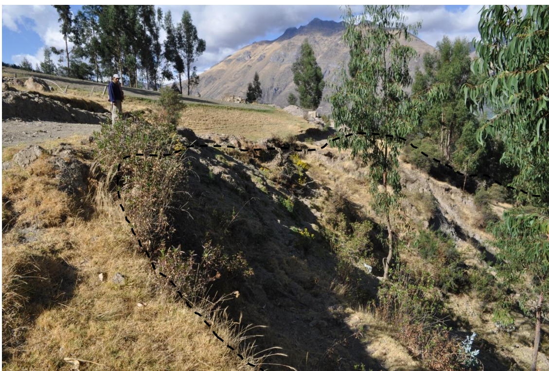
Deslizamiento activo (DAO-9), sector de Órcac.
