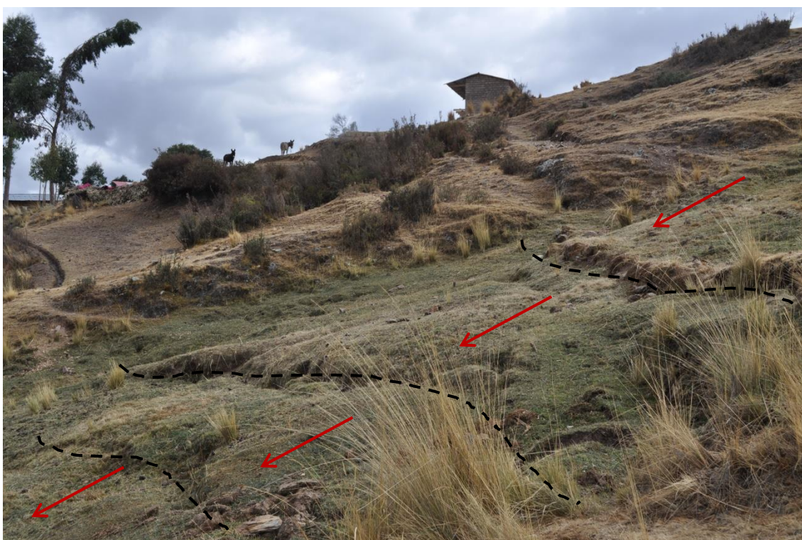
Deslizamiento activo (DAH-1) sector de Huancané (UTM: 230,355.62E; 8'464,899.2N), se puede observar agrietamiento en la superficie de terreno. Las flechas rojas muestran la dirección del deslizamiento.
