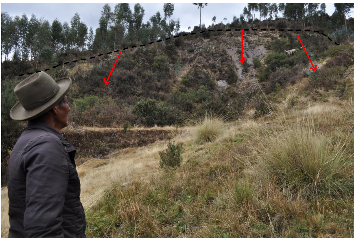
Deslizamiento (DAH-9) entre los sectores de Huayllapata y Huancané, (UTM: 230,405.29E; 8'465,634.09N), cubierto de arborizaciones de eucalipto utilizados para estabilizar el terreno.
