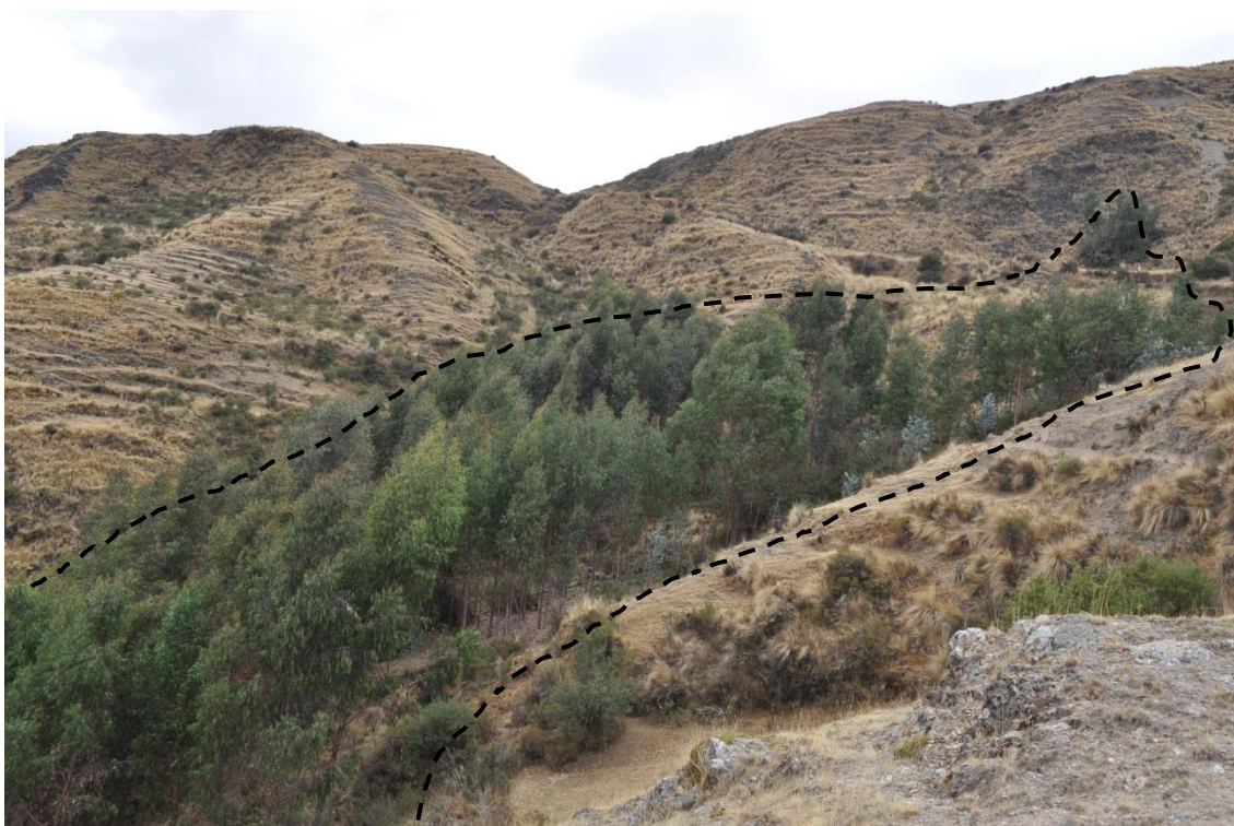
Deslizamiento activo (DAH-5) (UTM: 230,572.94E; 8'465,889.79N), cubierto de arborizaciones de eucalipto utilizados para estabilizar el terreno
