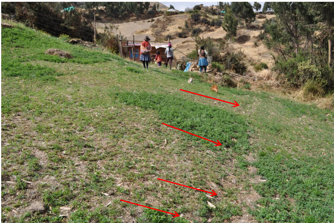
Fisuras en terreno de cultivo, sector de Huancané (UTM: 230,467E; 8'465,590N)
