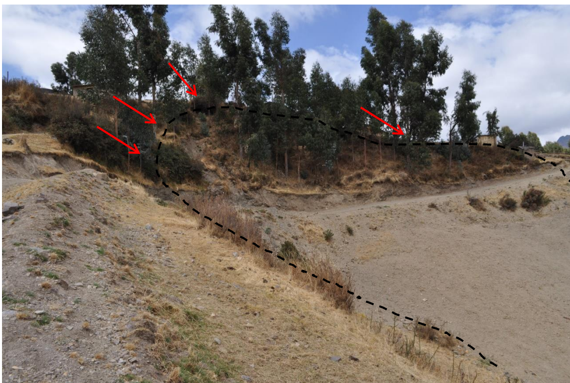
Sector Huancané, cabecera de deslizamiento activo (DAH-3), (UTM: 230,553E; 8'465,421N)
