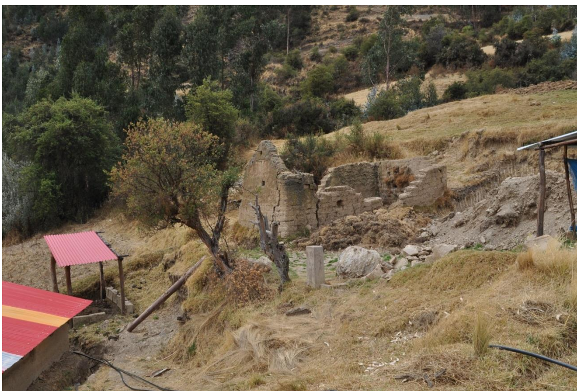
Vivienda inhabitable en el sector de Huayllapata.
