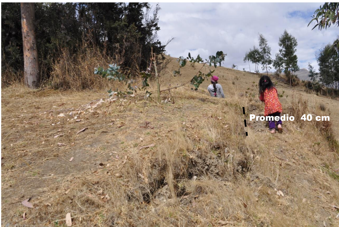
Fisuras en terreno de promedio 40 cm de asentamiento, sector de Huancané (UTM: 230,378E; 8'465,549N)
