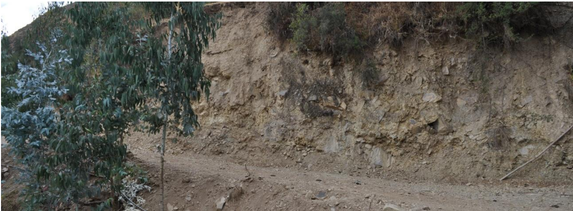
Fotografía 1 Secuencias de material cuaternario perteneciente a la unidad de depósitos coluviales (229,998E; 8'466,335N)
