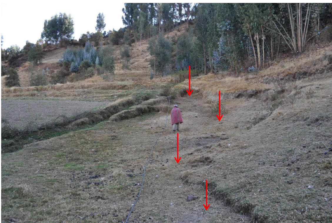
Deslizamiento (DAO-1) (UTM: 229,666.75E; 8'465,650.65N), se puede observar el suelo asentado con fisuras, sector de Órcac
