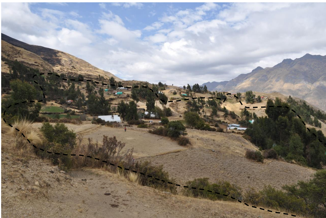
Sector Huancané, se observa terreno coluvial donde se presentan varios fenómenos de deslizamientos activos
