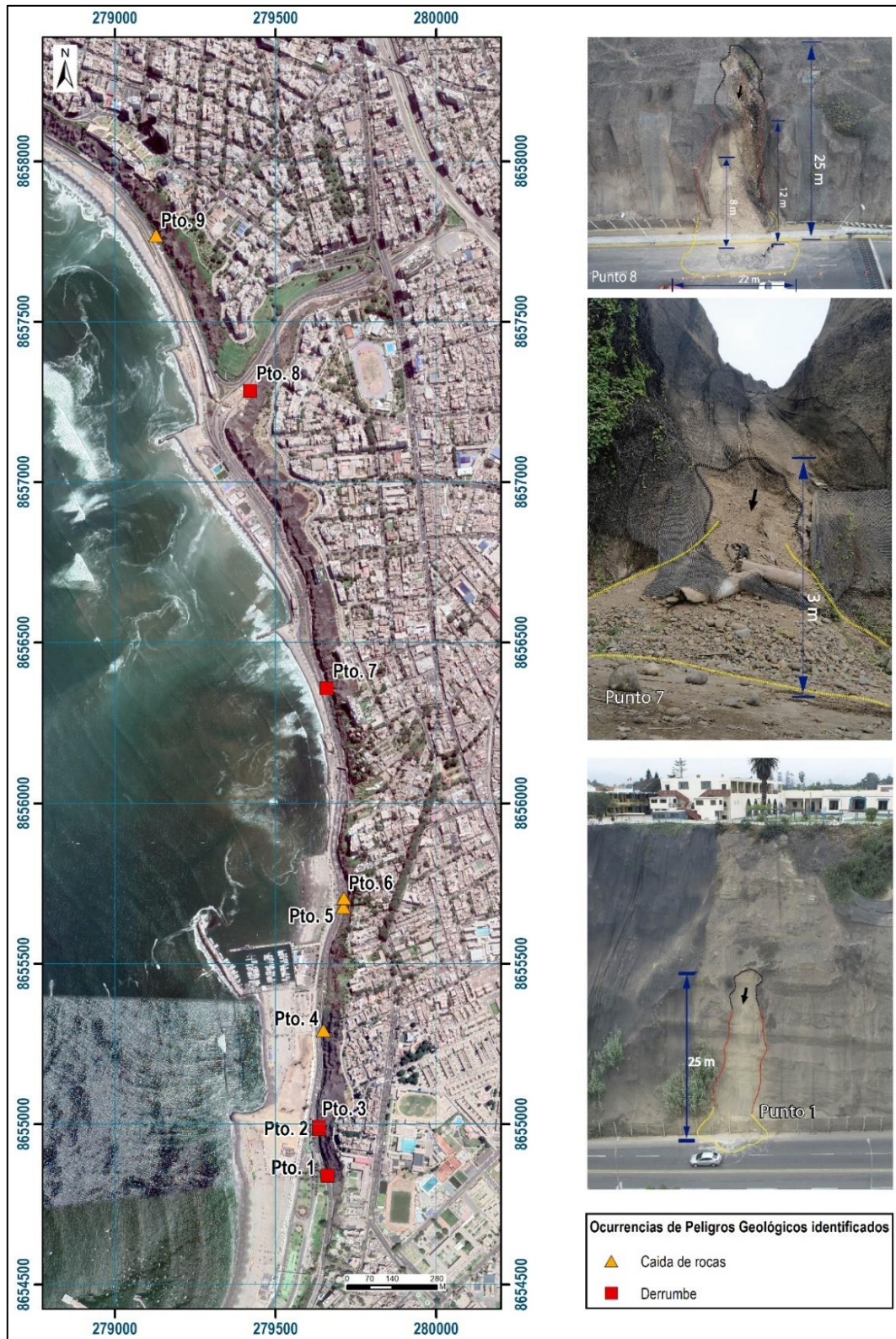
Figura 2: Ubicación de derrumbes y caída identificados en campo.
