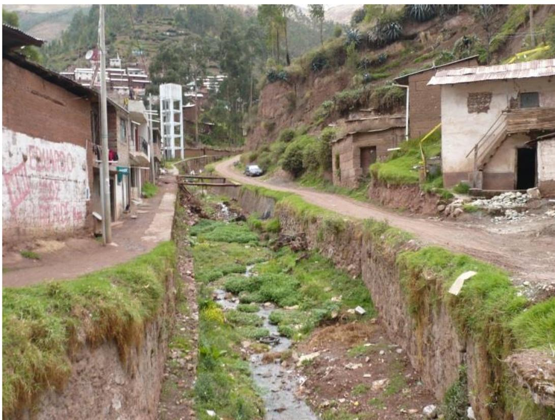
Foto 28. Encauzamiento de una quebrada; considerando la profundidad y ancho del cauce natural promedio existente, la granulometría y tamaño de bloques; pendiente de la quebrada.
