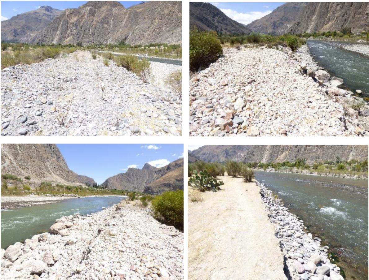
Foto 25. Muros de arrimado de material con enrocados, que están parcialmente erosionados por falta de cemento, que se presentan entre Coñec y el puente peatonal que cruza a Taurisma.
