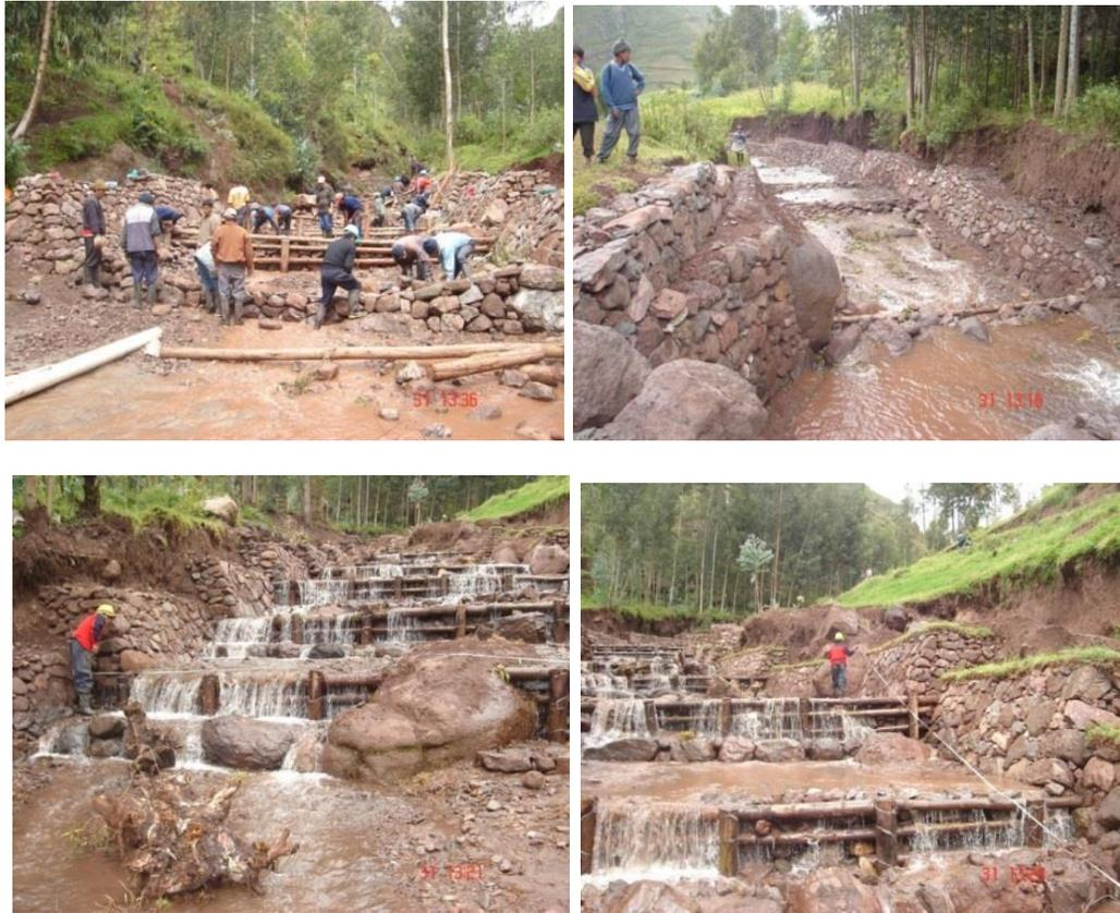
Foto 29. Construcción de disipadores de energía de las corrientes concentradas en el cauce de la quebrada, mediante diques transversales (enrocado y armazón de troncos) y canalización del cauce con muros laterales escalonados utilizando bloques de rocas para mitigar los efectos ante la ocurrencia de un flujo de detritos.
