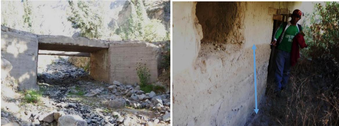
Foto 14. Huellas de impacto de lodo en las paredes del puente donde cruza la quebrada Sihuaña y en una vivienda afecta por un flujo de detritos. La casa se encuentra abandonada.
