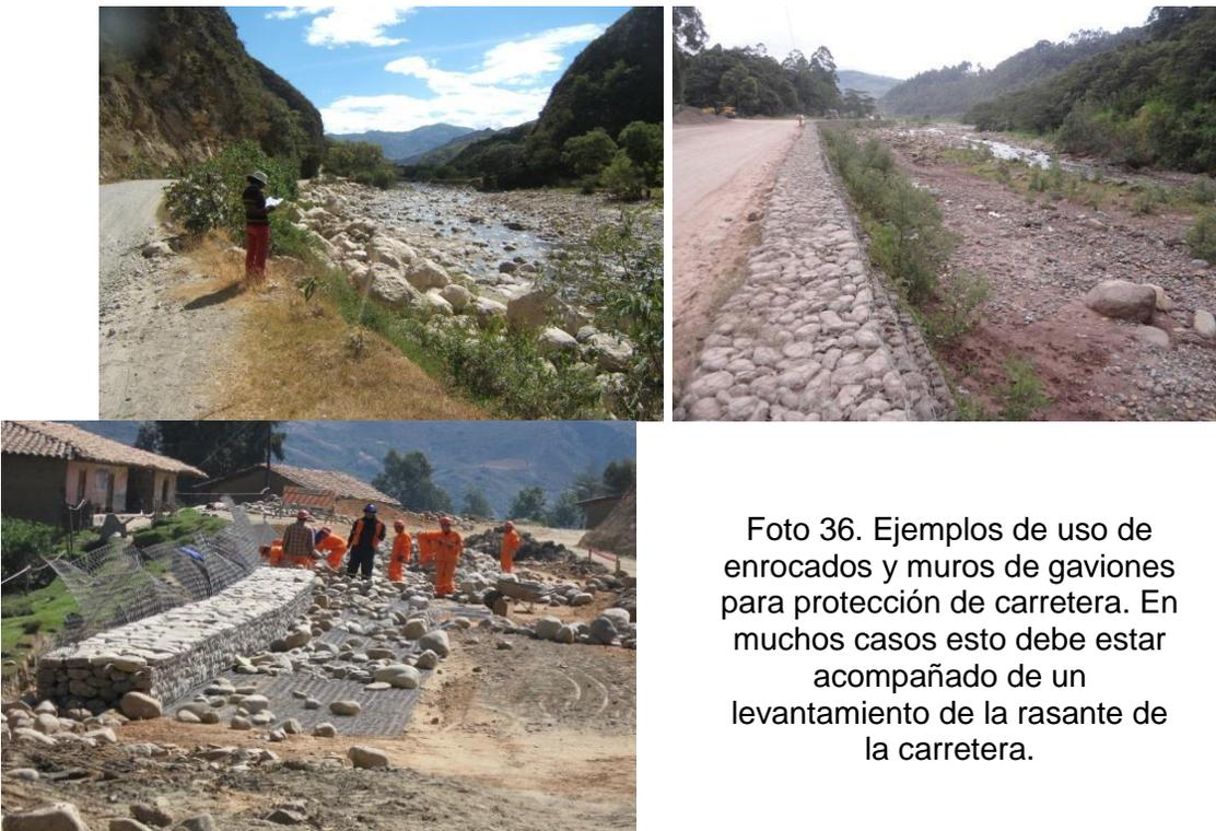
Foto 36. Ejemplos de uso de enrocados y muros de gaviones para protección de carretera. En muchos casos esto debe estar acompañado de un levantamiento de la rasante de la carretera.
