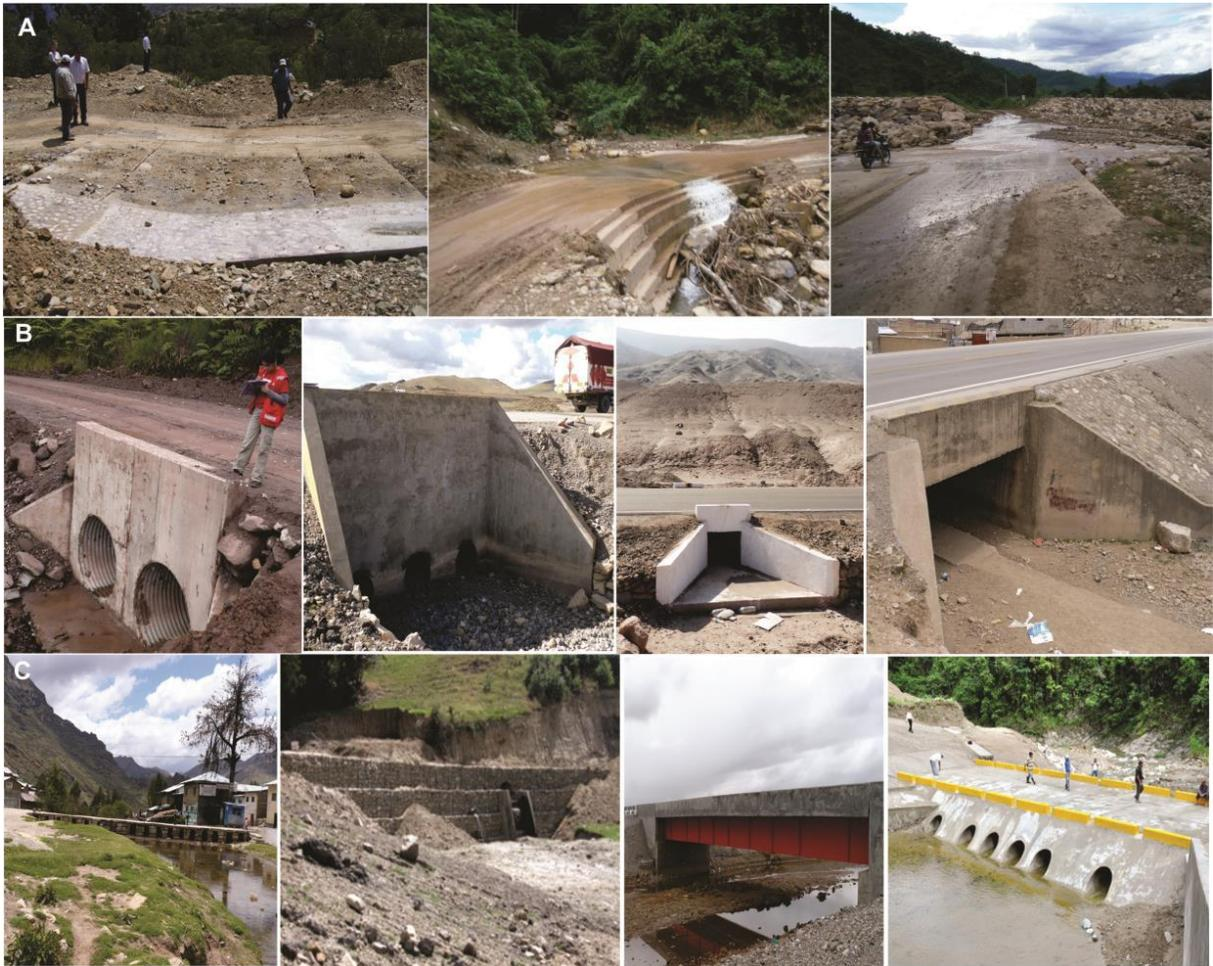
Foto 31. Ejemplos de obras de drenaje para redes viales, A) badenes, B) alcantarillas y pontones y C) puentes, puentes-badén.
