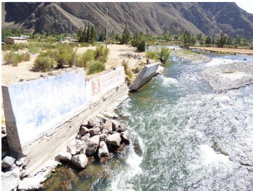
Foto 24. Erosión fluvial en tramo de 185 metros aguas arriba de puente peatonal que cruza hacia Taurisma; se ve el muro de concreto que ha sido parcialmente afectado susceptible a colapso por la próxima avenida.
