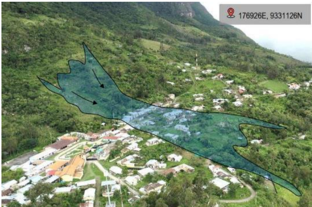
Figura 26. Vista aérea del área urbana afectada por inundación pluvial.
