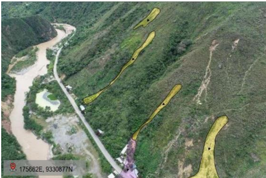
Figura 14. Vista de laderas con deslizamientos y flujos que afectan a varias viviendas del caserío Matiaza Rimachi.
