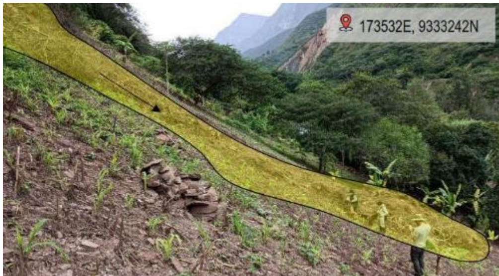
Figura 07. Vista lateral del deslizamiento y los materiales deslizados.
