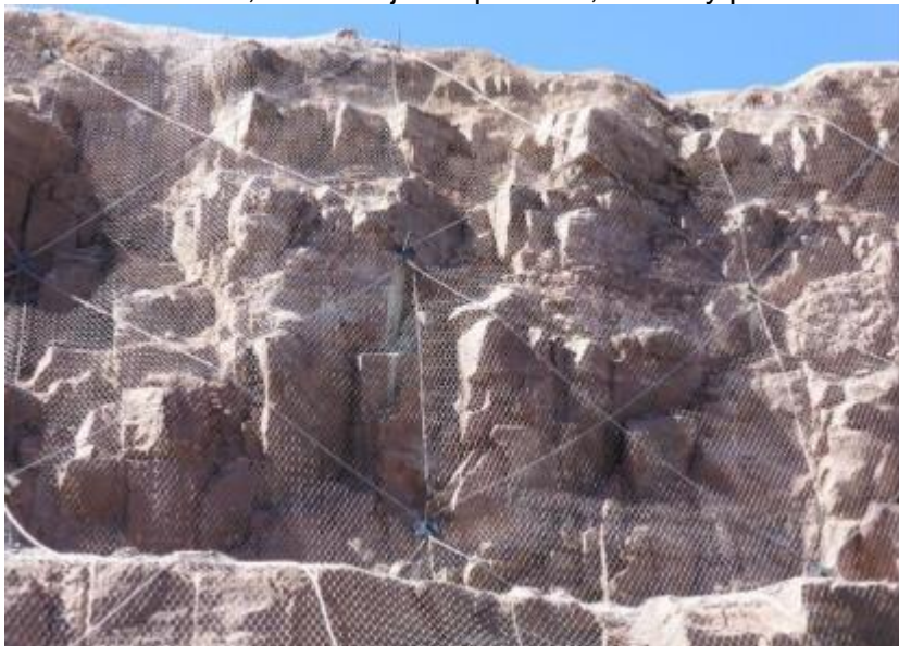
Figura 37. Control de caída de rocas utilizando mallas ancladas.
