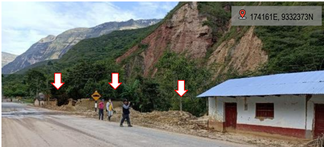
Figura 31. Viviendas destruidas por flujo de detritos en la quebrada Nuevo Horizonte.
