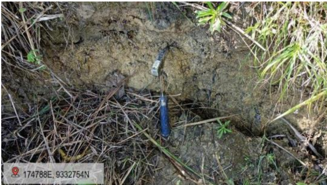
Figura 10. Grietas longitudinales en la corona del deslizamiento principal en la zona de evaluación.
