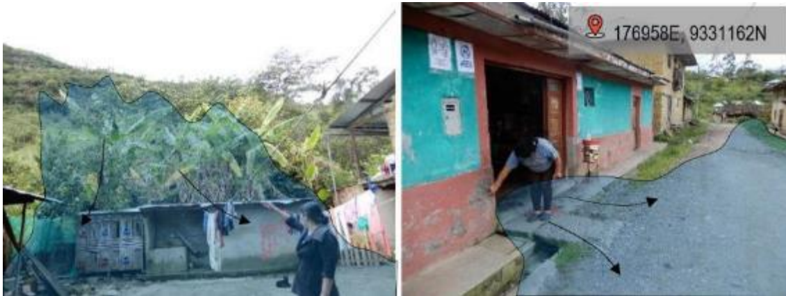
Figura 25. Viviendas afectadas por inundaciones pluviales.
