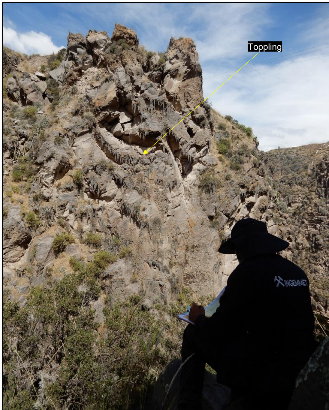
Figura 25. Zona de derrumbe (Toppling). (coordenadas UTM E: 220396, N: 8270019).
