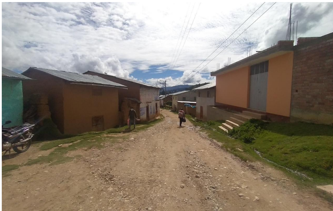
Fotografía N° 6- Estado actual de Jr. Dos de Mayo, a la altura del cruce con Jr. Huánuco. Manzana T (izq.) y Mz S (der.)
