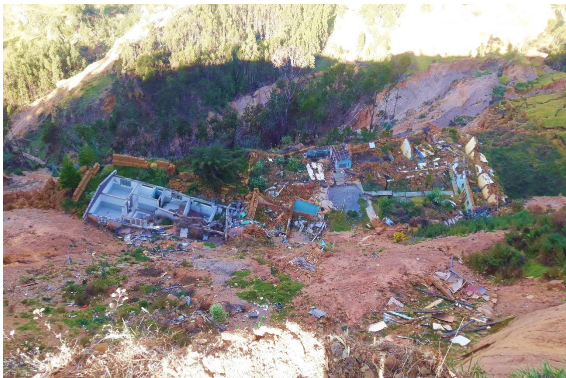
Fotografía N° 15- Estado actual de la zona norte de la Manzana J. Centro de Salud y porción de viviendas colapsadas por el deslizamiento.
