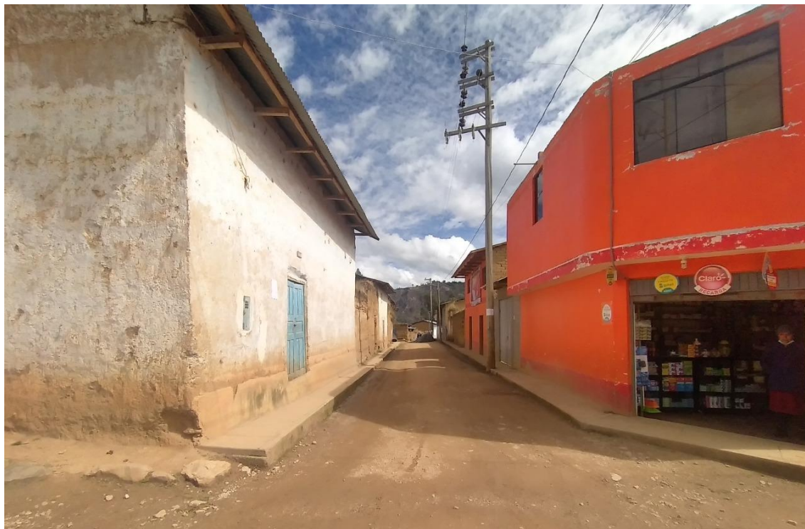
Fotografía N° 7- Estado actual del Jr. La Unión, altura del cruce con el Jr. Dos de Mayo. Manzana T (izq.) y Mz O (der.).
