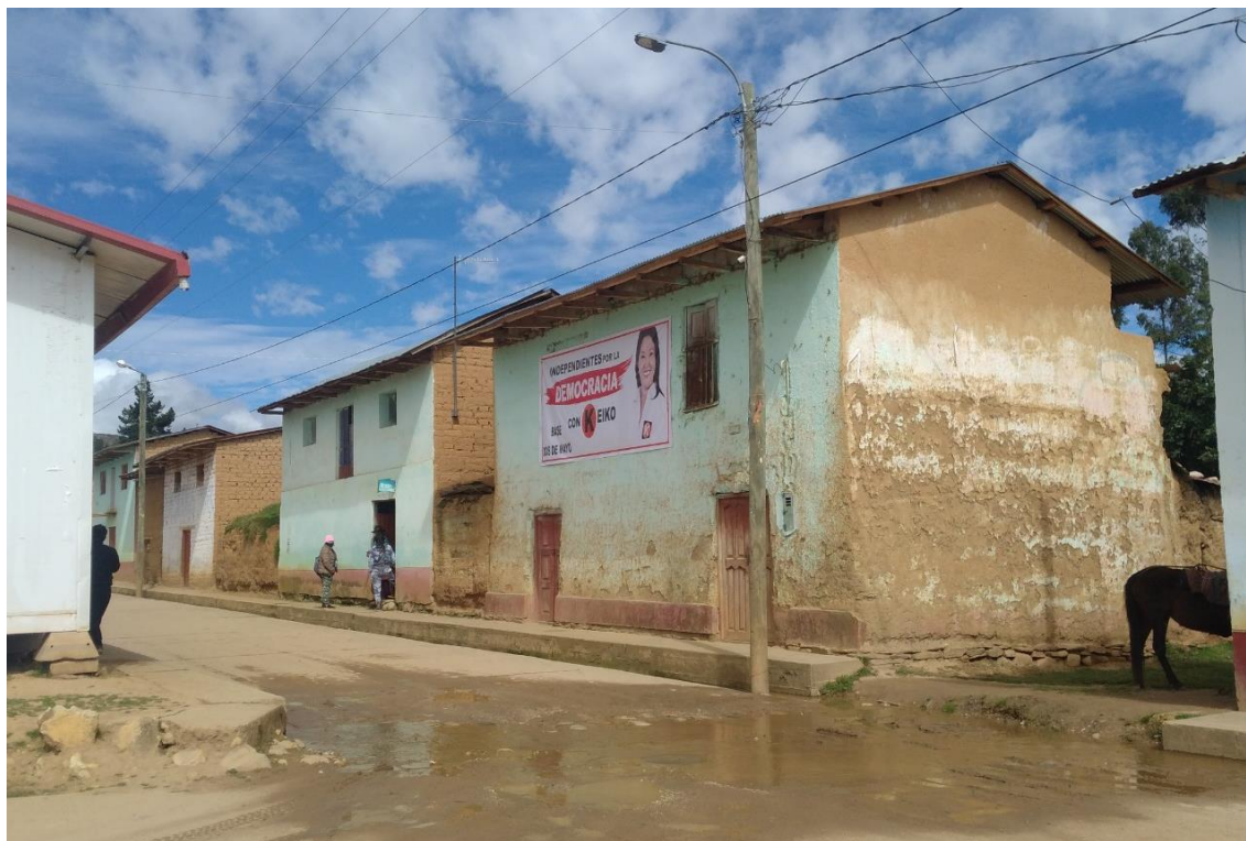
Fotografía N°8- Estado actual del cruce entre Jr. Dos de Mayo (izq.) y Jr. Progreso (der.). Manzana G (vista central).
