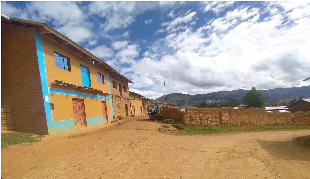
Fotografía N° 5- Inicio de jirones Huánuco (izq.) y Porvenir (der.).
