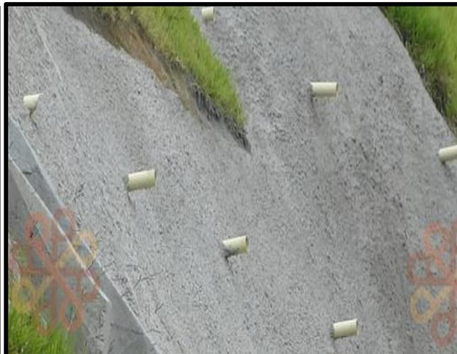
Imagen N° 12 Esquema de drenaje de un talud por medio de drenes californianos.
