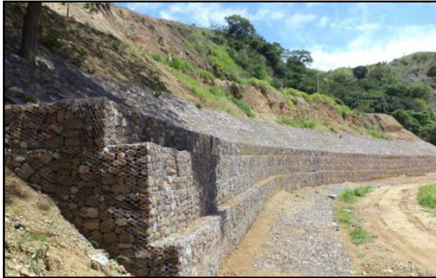
Imagen N° 13 Defensa ribereña con muro de gaviones en gradería.
