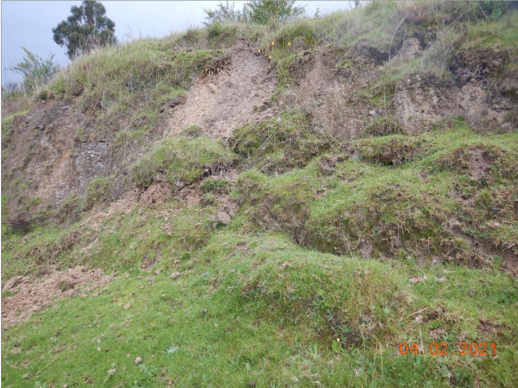
Fotografía 2. Depósito de antiguo deslizamiento, conformado por bloques de formas angulosas y gravas; inmersos en matriz areno arcillosa.
