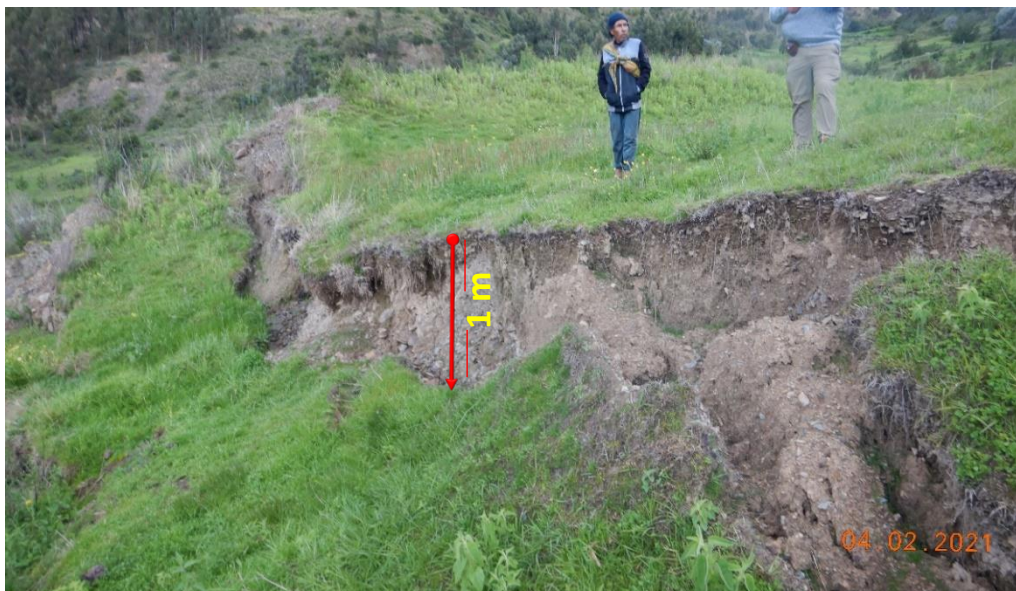
Figura 13. El deslizamiento rotacional reactivado presenta actividad retrogresiva, muestra de ello son los agrietamientos tensionales y desplazamientos de hasta 1 m de altura identificados en la zona posterior a la escarpa., con coordenadas (WGS 84): 229781 E, 8469433 N a 3611 m s.n.m.
