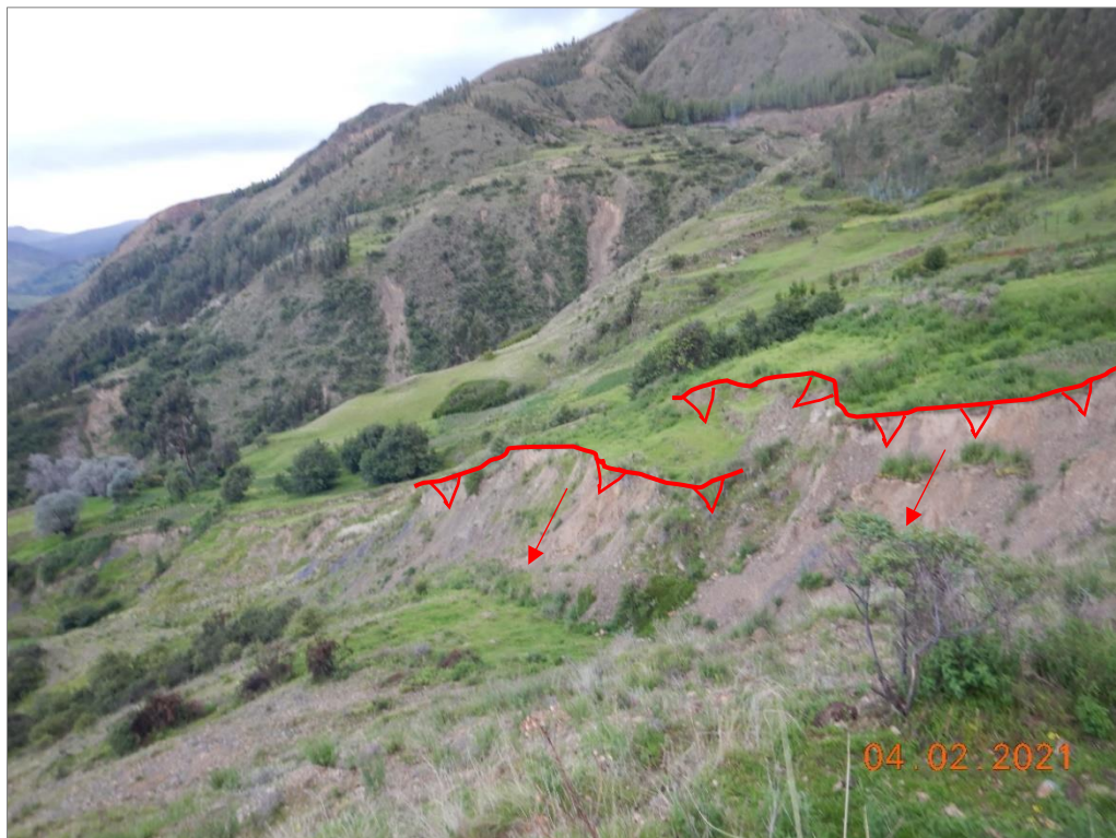
Figura 10. Vista del deslizamiento reactivado (delimitado con líneas rojas), con escarpe de forma semicircular y 2 m de salto. Con coordenadas UTM (WGS 84): 229748 E, 8469280 S a 3625 m s.n.m.
