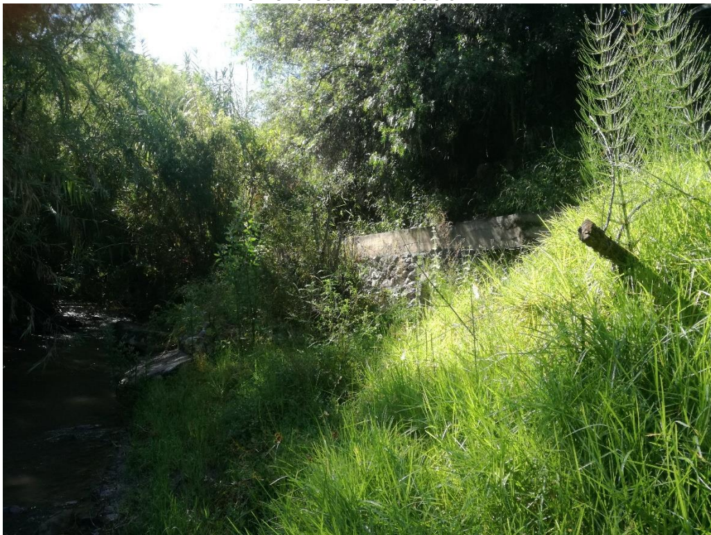
FOTO 02: Vista de la zona y evidencia de eventos sobre el canal de riego por Inundación en el área en Evaluación.
