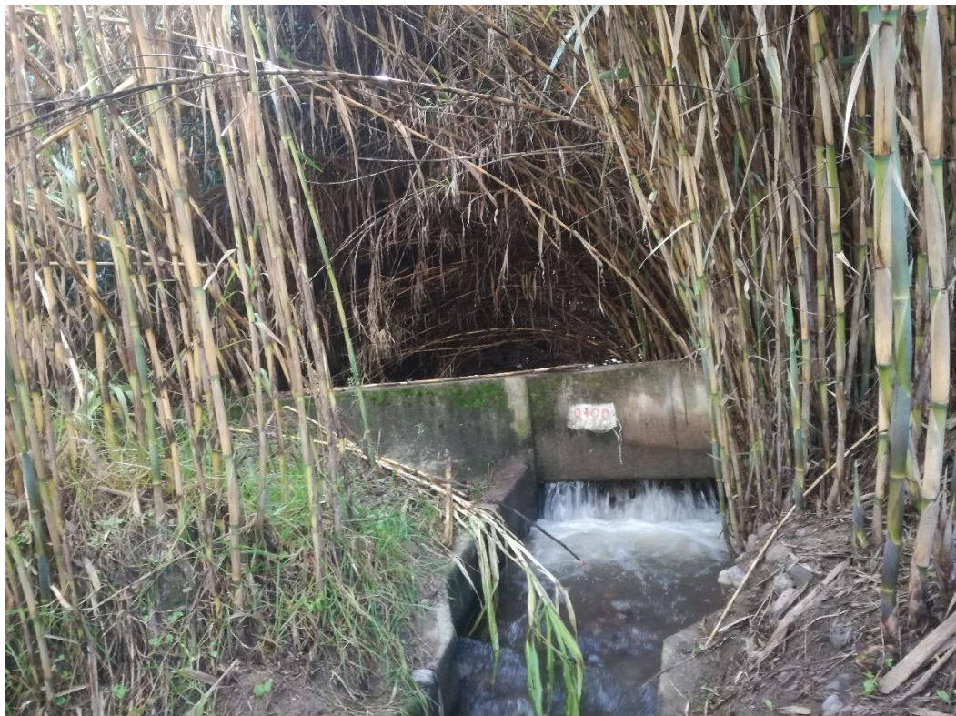
FOTO 04: Vista de infraestructura de riego existente en el área de Evaluación.
