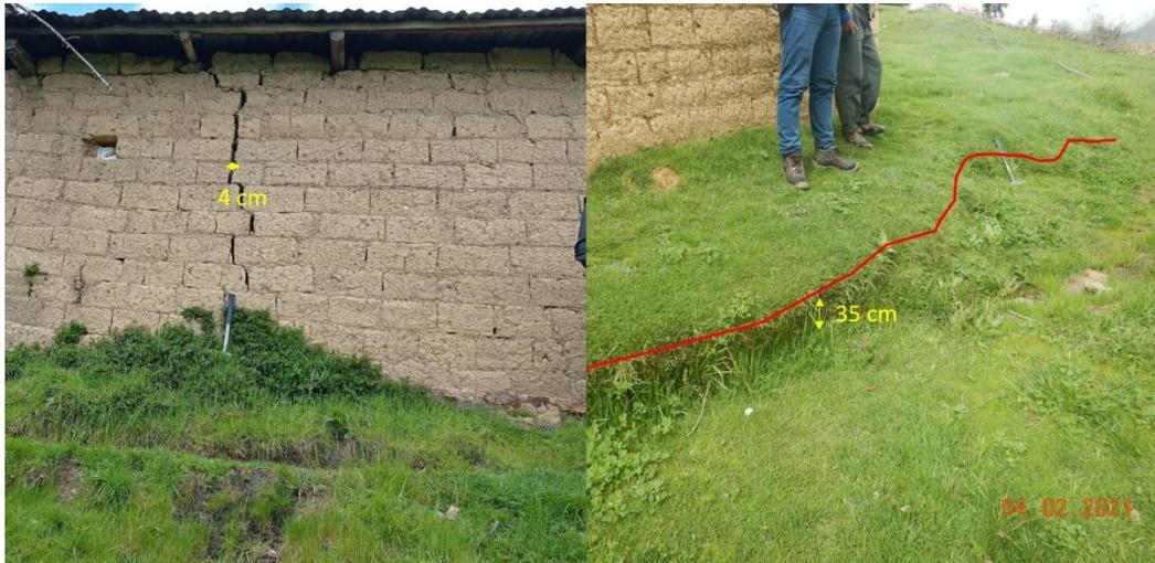
**Figura 11.** Vista tomada en coordenadas E 230325; N 8465342. Muestra vivienda con pared agrietada producto de la reactivación de deslizamiento con asentamiento del terreno de 35 cm de altura.
