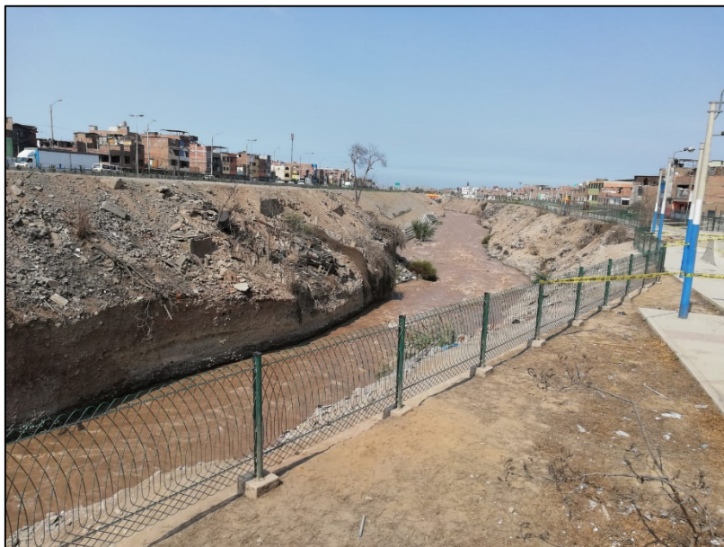
Se observa la presencia de unos enmallados al margen izquierdo del río Rímac
