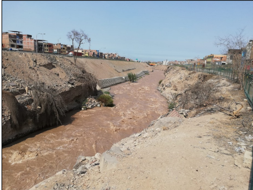
Vista general del caudal del río Rímac
