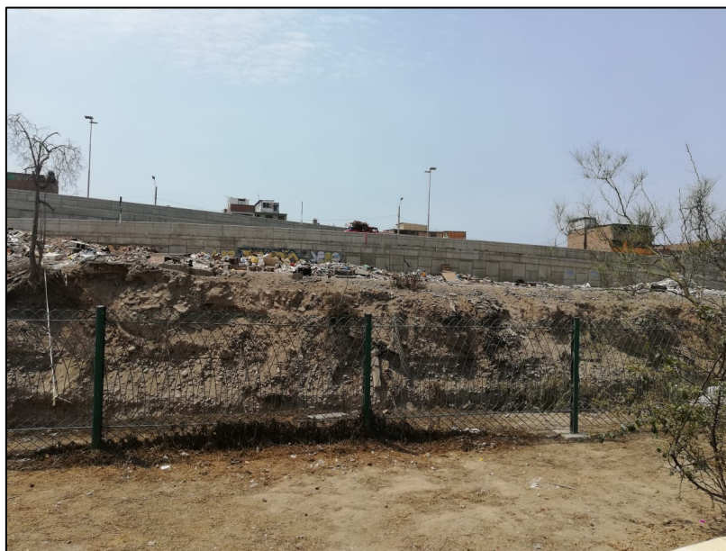
Vista lateral de la Vía Línea Amarilla colindante con el Río Rímac
