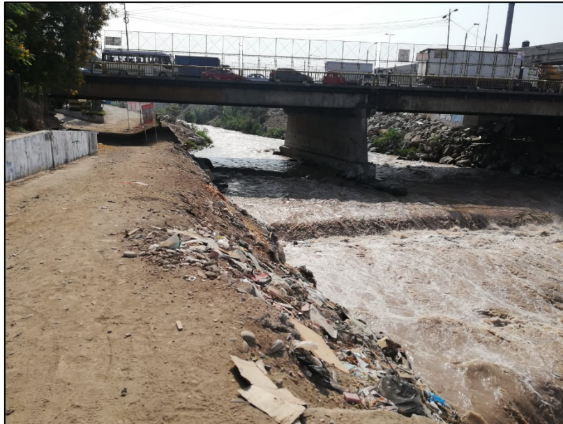
Vista de la parte baja del Puente Dueñas (Av. Canadá)
