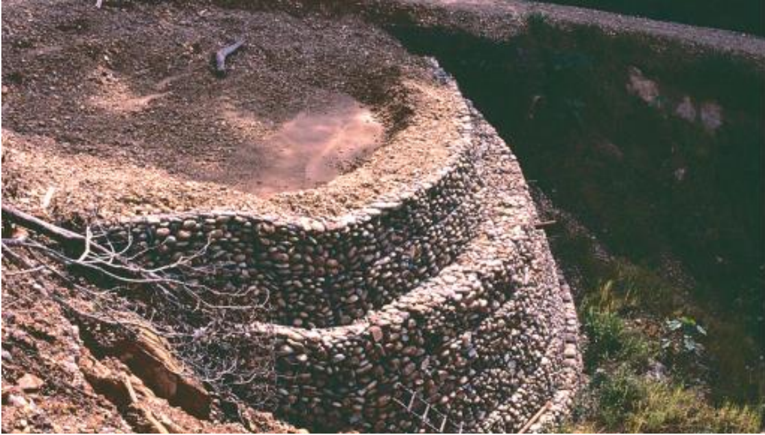
Figura 34. La flexibilidad de los gaviones permite deformaciones considerables (Suárez, 1998).
