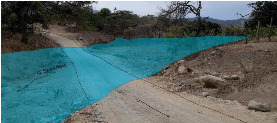
Figura 22. Trocha carrozable Santa Rosa - Suyo, tramo afectado por flujos de detritos, coordenadas 9497163N y 616823E.
