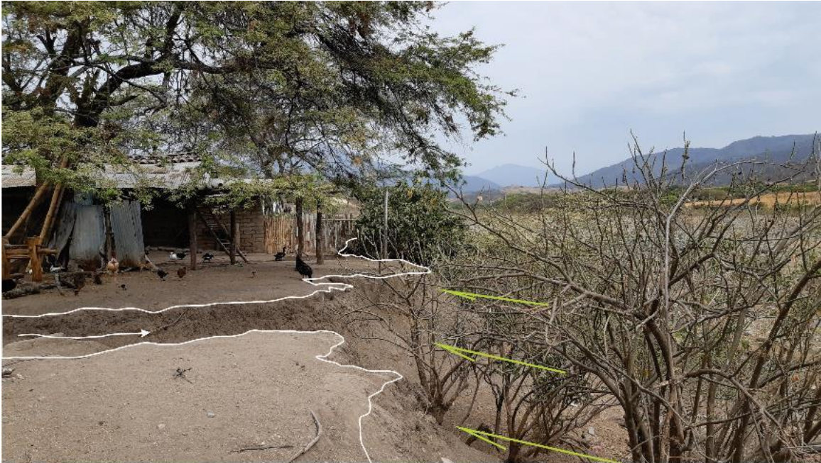
Figura 20. Vivienda de adobe al borde de la quebrada Suyo, el aumento del caudal durante la temporada de lluvias expone la vivienda a daños, coordenadas 9497731N y 615971E.
