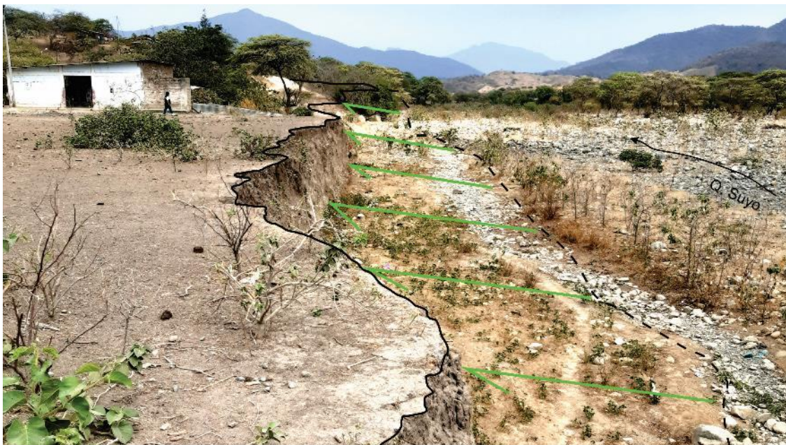
Figura 11. Terraza aluvial afectada por erosión fluvial en las coordenadas 9497839N y 615861E.
