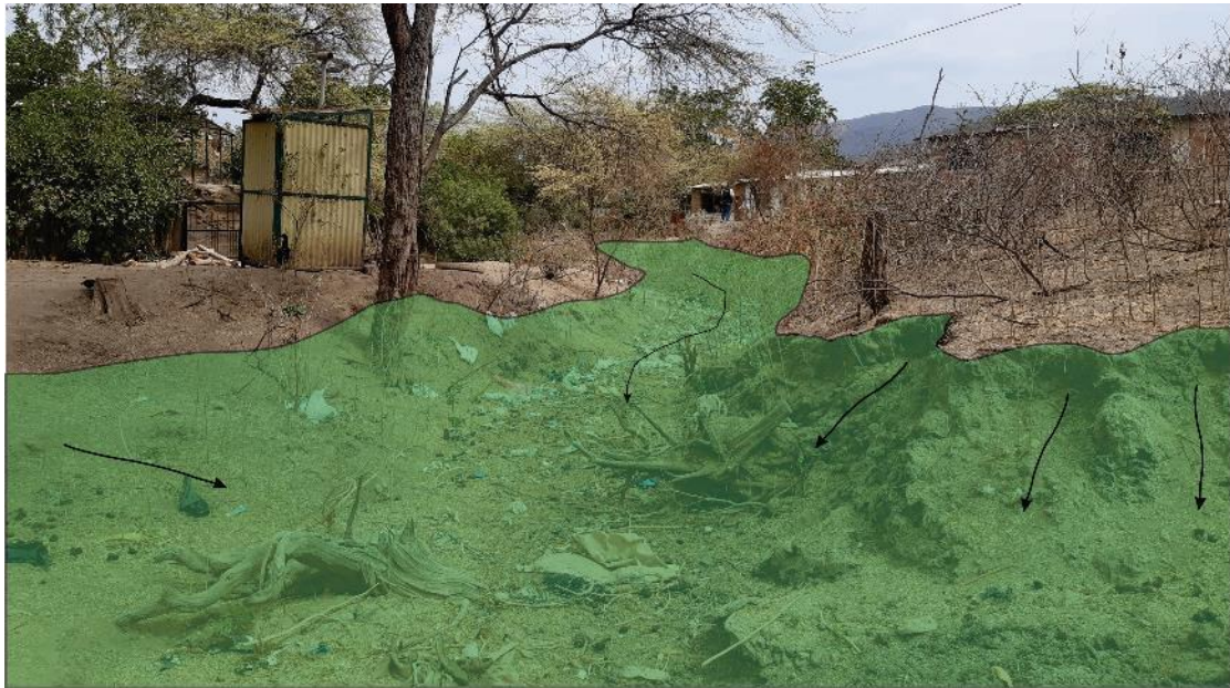
Figura 13. Cárcava que afecta viviendas del caserío Santa Rosa, perteneciente al centro poblado Santa Rosa. (Coordenadas: 9497509N y 616214E).
