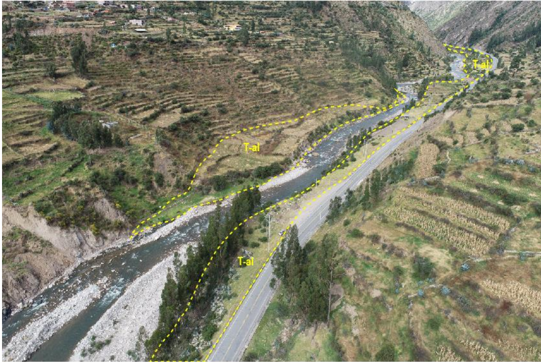
Figura 11. Vista al sureste de la Comunidad Campesina de Pampamarca, donde se observa terrazas aluviales en ambas márgenes del río Cotaruse.
