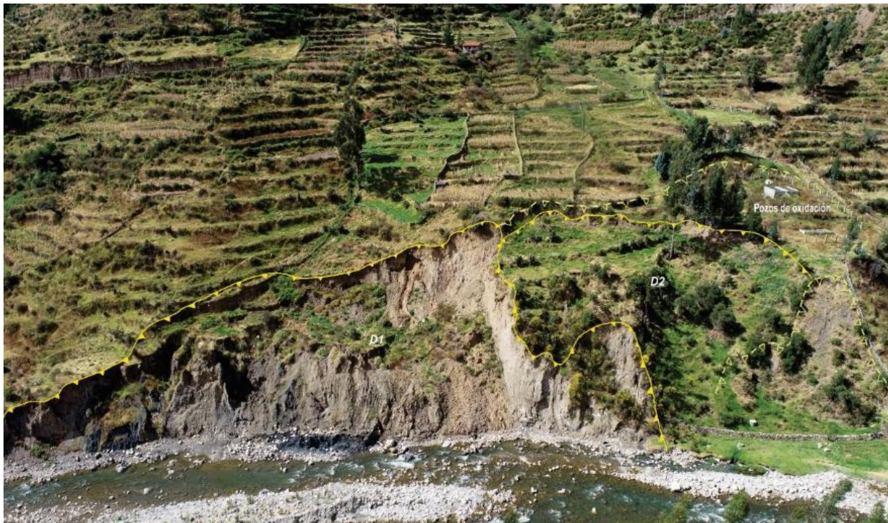
Figura 15. Vista donde se puede observar el deslizamiento reactivado(D1) generado hace 10 años atrás y el deslizamiento antiguo (D2) generado en enero del 2021, ubicados en la margen derecha del río Cotaruse.
