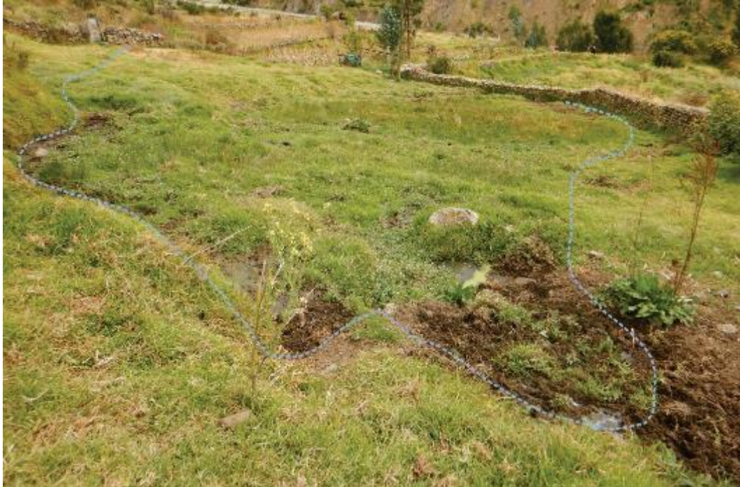
Figura 18. Bofedal ubicado a 100 m en dirección hacia el este, desde la escarpa principal. Según información de los pobladores esta siempre presenta agua, lo cual podría estar generando la saturación del suelo. Se encuentra en las coordenadas UTM8404413N, 693271E con una altitud de 3420 m s.n.m.
