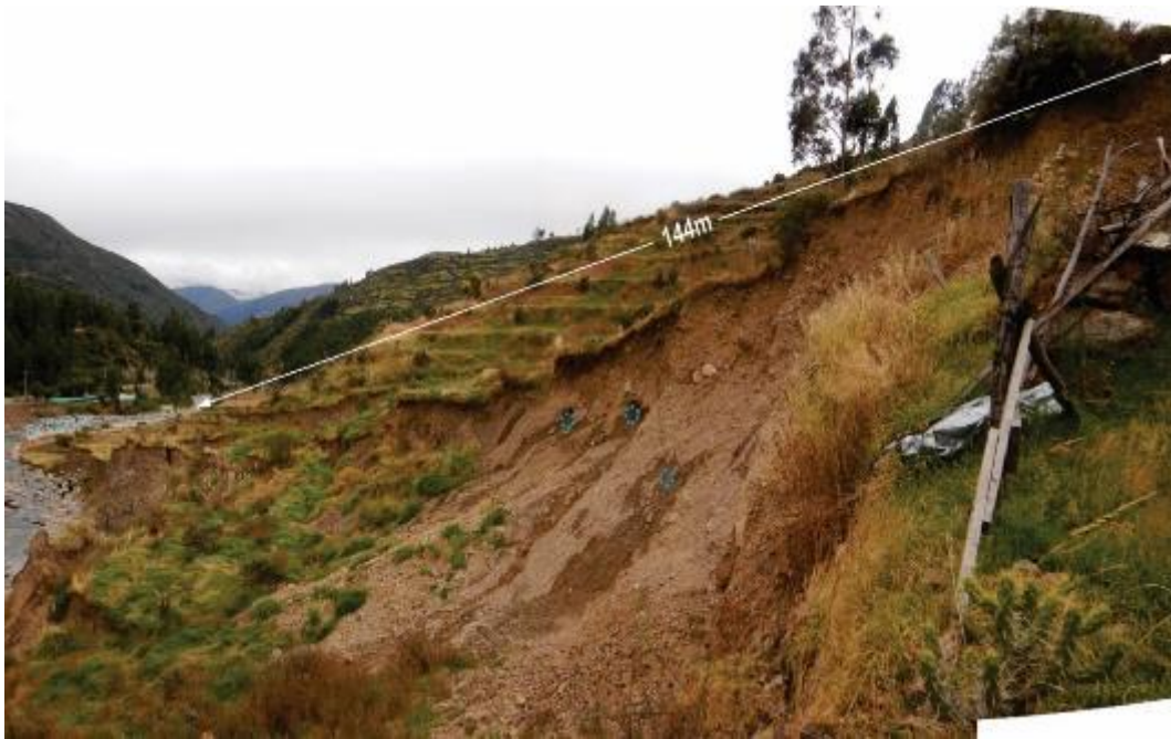
Figura 13. Vista del deslizamiento D1, donde se evidencia un escarpe principal de 144 m, así como filtraciones de agua en el cuerpo del deslizamiento. Este evento geodinámico se reactiva frecuentemente en temporadas de lluvias.
