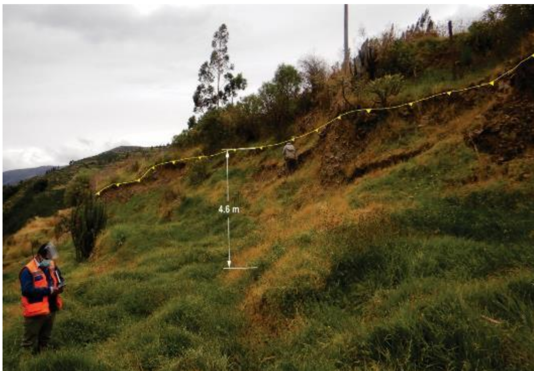
Figura 14. Vista del deslizamiento D2, donde se evidencia un escarpe principal de 48 m de longitud (actualmente cubierto de pastos) y un salto principal de aproximadamente 4.6 m. Este evento corresponde a una reactivación de un deslizamiento antiguo.
