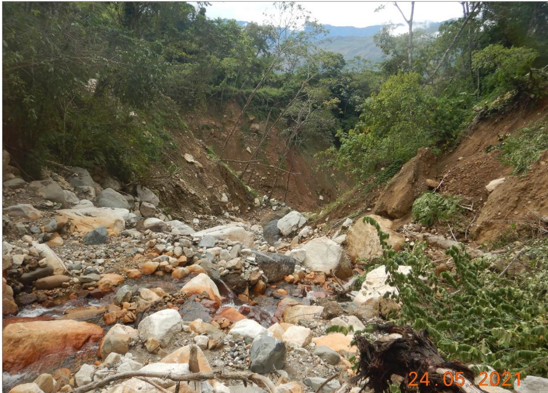
Fotografía 13. A, B) Derrumbes continuos en la zona media - baja de la quebrada San Lorenzo. Con coordenadas UTM (WGS 84): 763394, 8591273 a 1008 m s.n.m.
