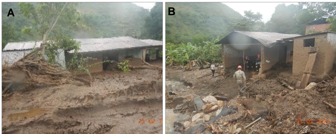
Figura 2. A, B) Viviendas del sector Miraflores afectadas por el huaico de la quebrada Miraflores. Localizadas en las coordenadas UTM (WGS 84): 763707 E, 8588937 S a 905 m s.n.m.
