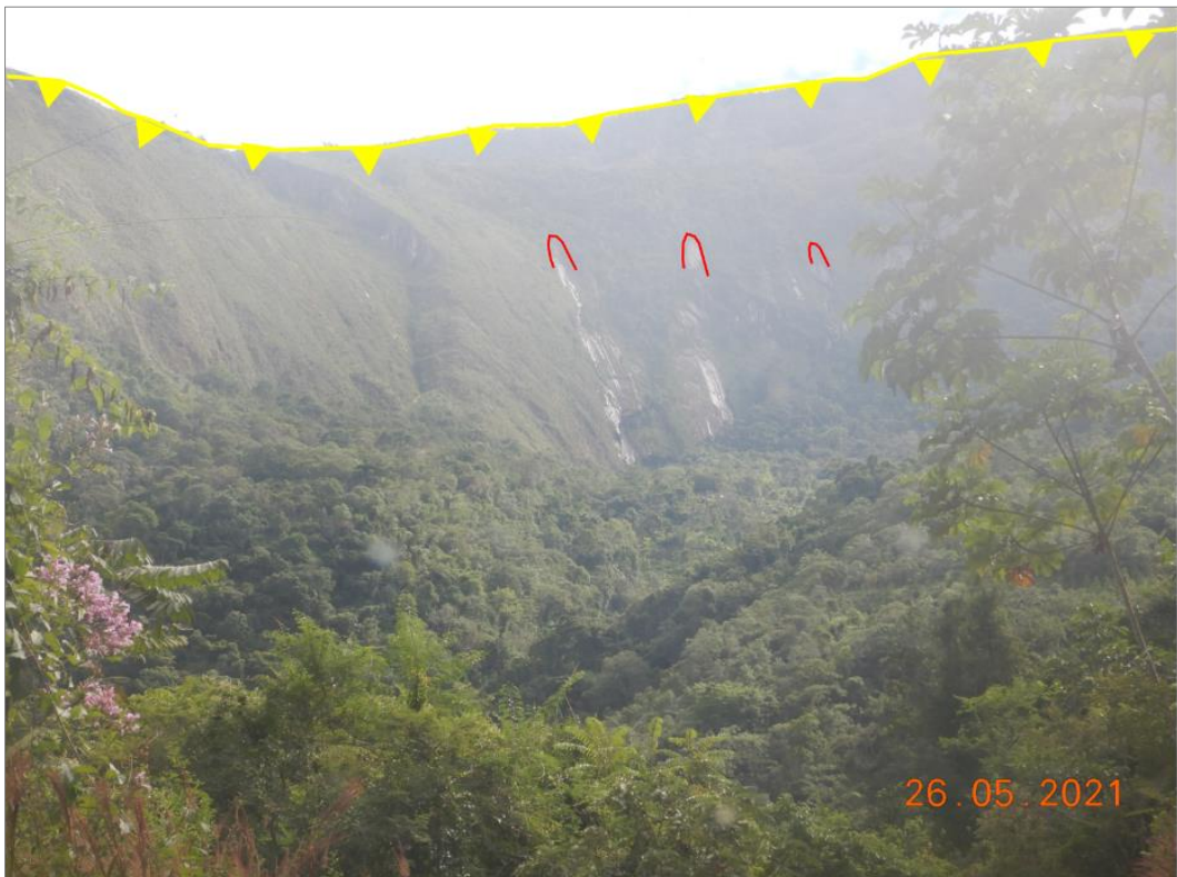
Figura 6. Vista del deslizamiento antiguo y los derrumbes reactivados en la escarpa.
