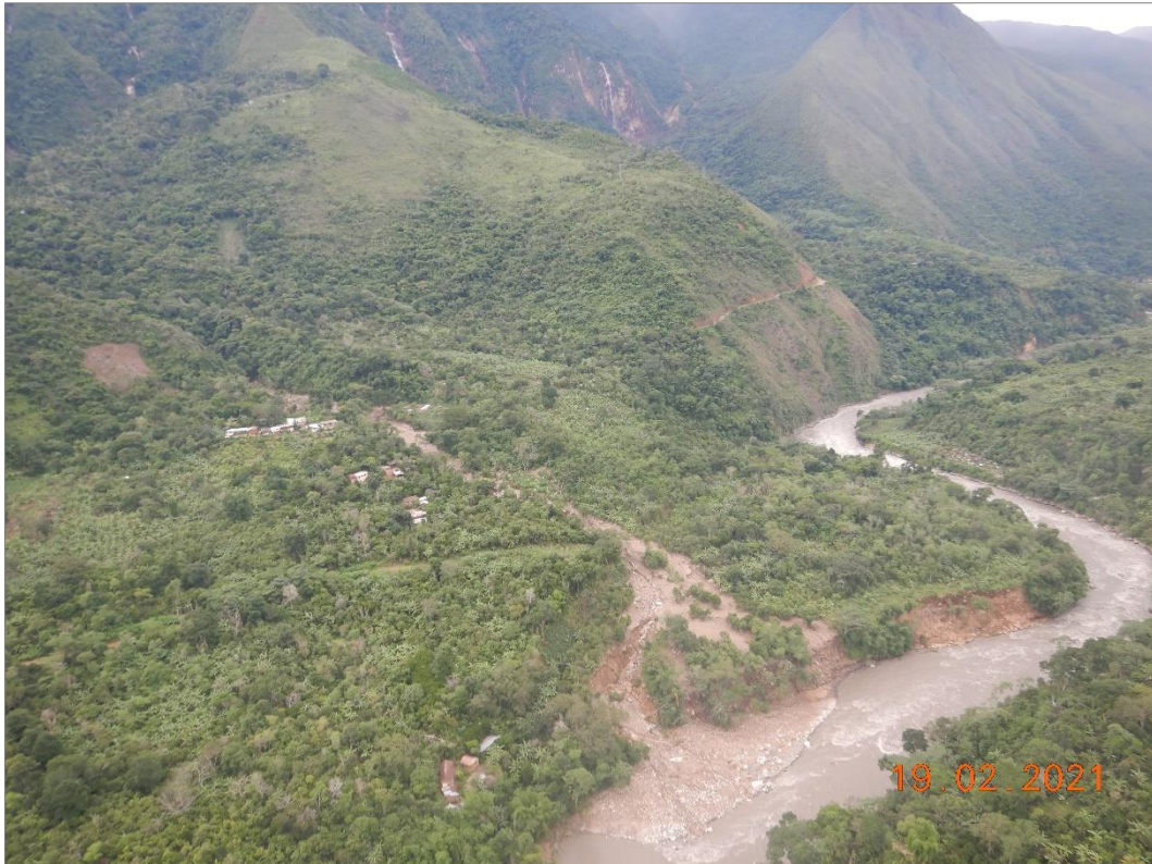
Fotografía 11. Depósito proluvial reciente, desencadenado en la quebrada San Lorenzo.
