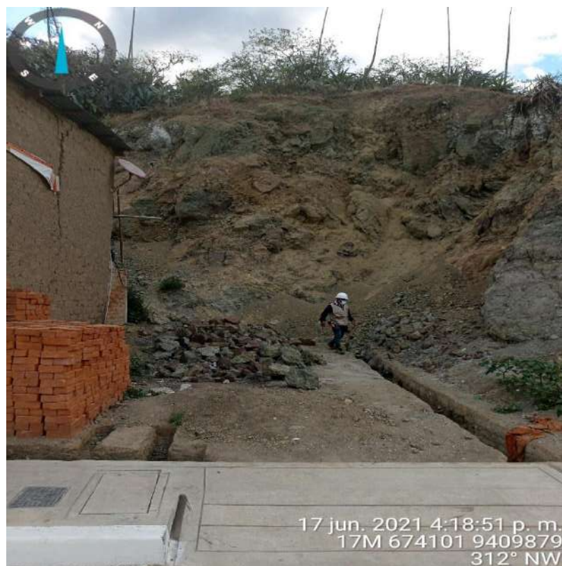
Figura 6: Derrumbe de clastos de rocas (piroclastos andesíticos y dacíticos) que conforman taludes inestables que podrían afectar viviendas
