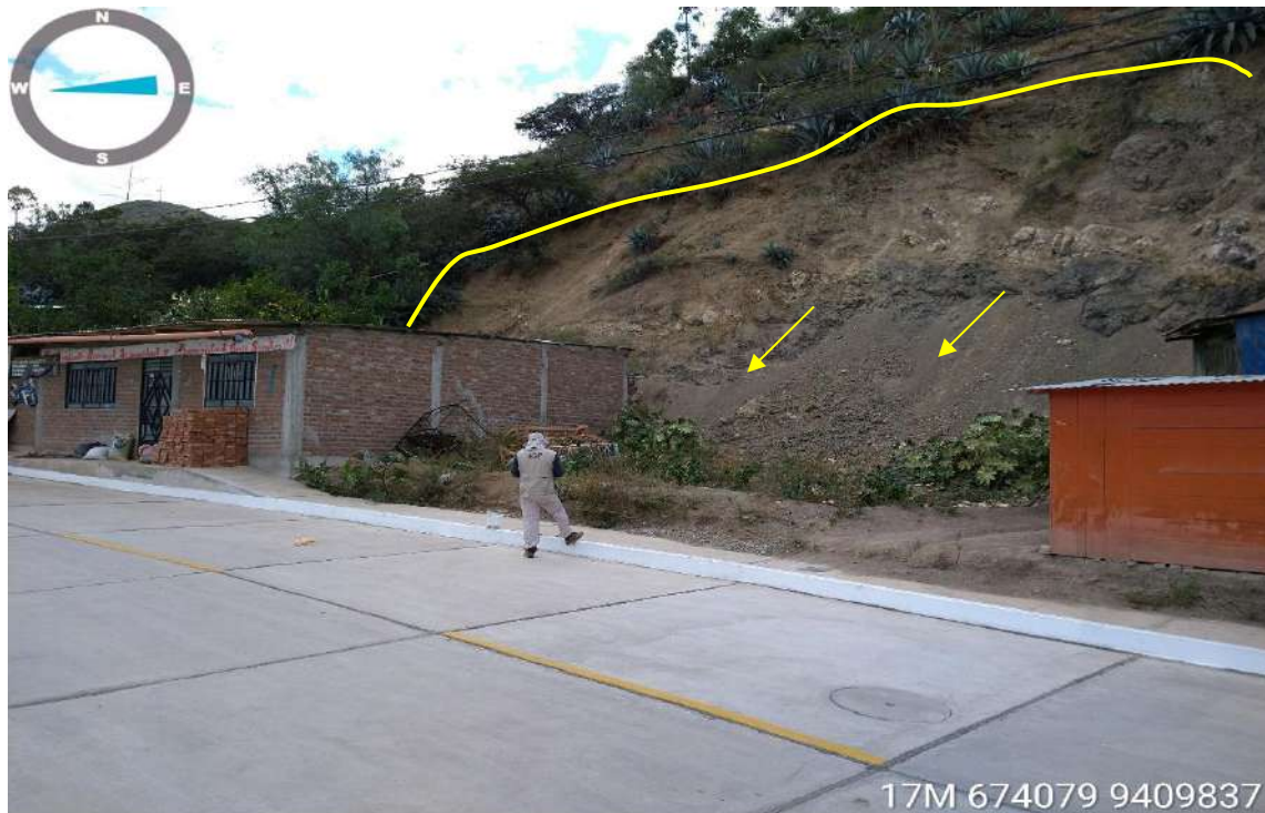
Figura 5: Derrumbes de materiales aluviales y afloramientos dacíticos ubicados sobre taludes modificados para el emplazamiento de viviendas. Los materiales desprendidos se ubican detrás de viviendas existentes.
