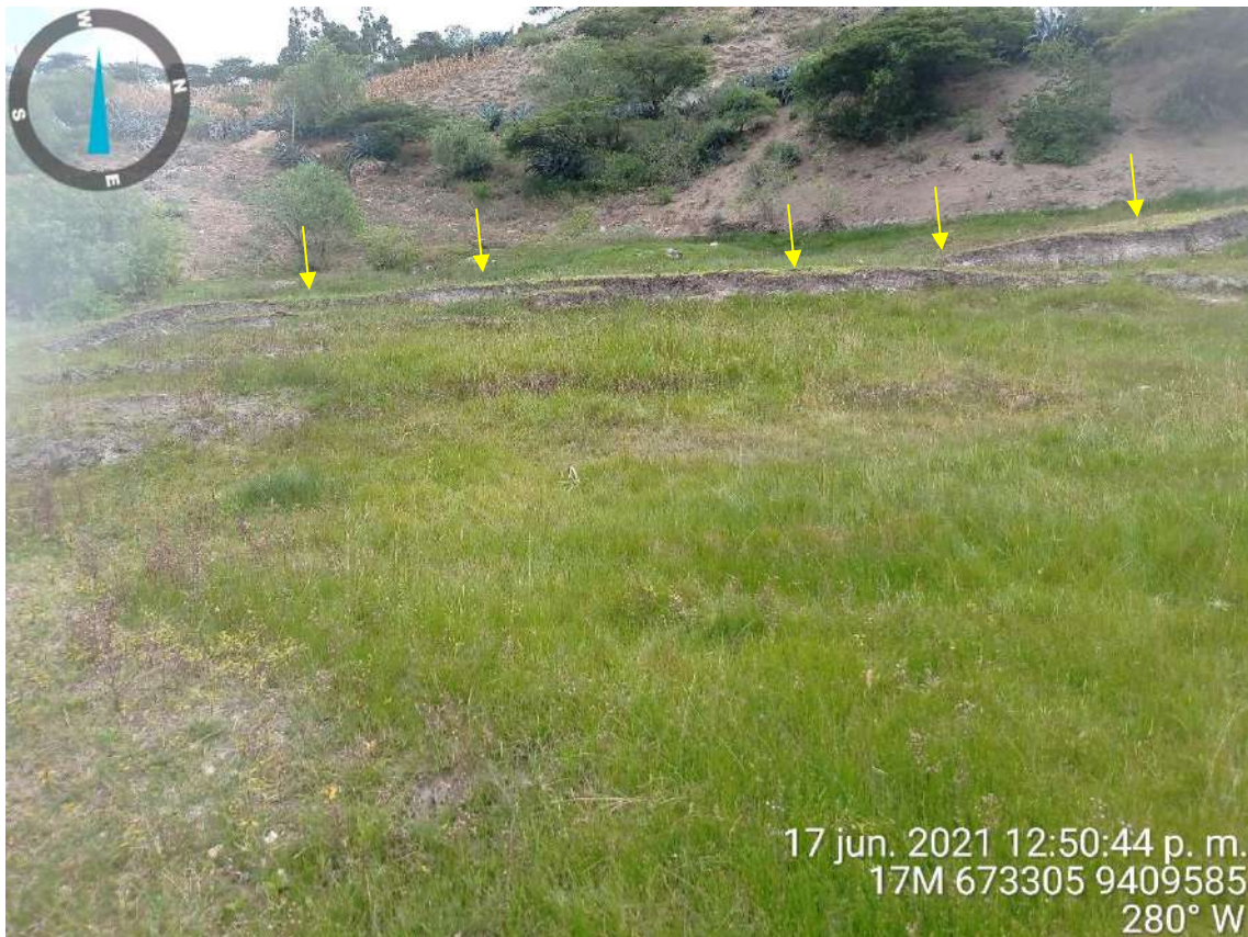
Figura 7: Ladera afectada por reptación de suelos en la cual se ha identificado grieta (debajo de flecha amarilla) en el suelo de 10 cm de salto en zonas saturadas por flujos de agua.
