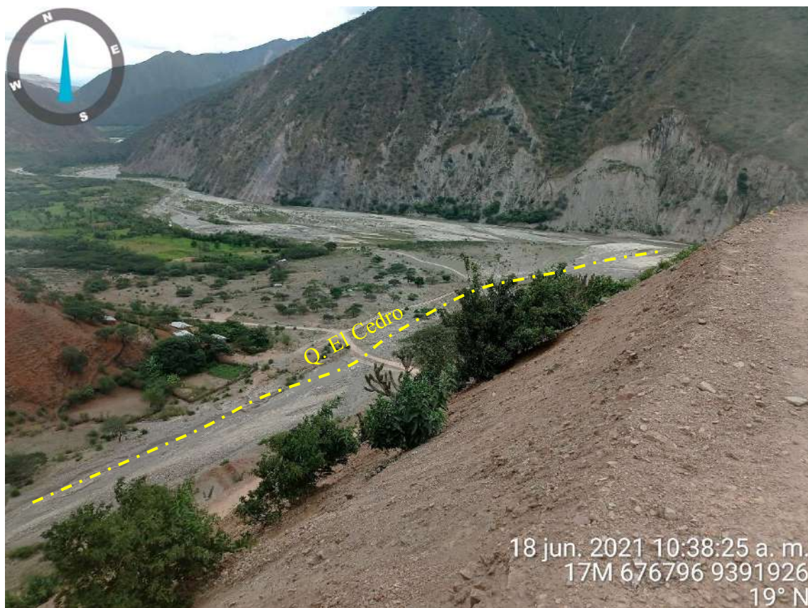
Figura 14: Quebrada el Cedro donde se evidencian materiales aluvionales antiguos sobre el cauce de la quebrada y desembocadura hacia e río Huancabamba
