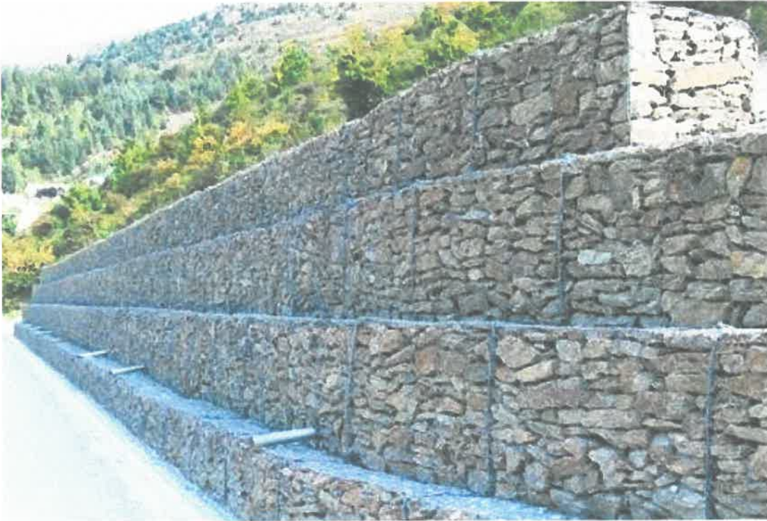
Imagen N° 14: gaviones para encausar el río y evitar daños a la población.
