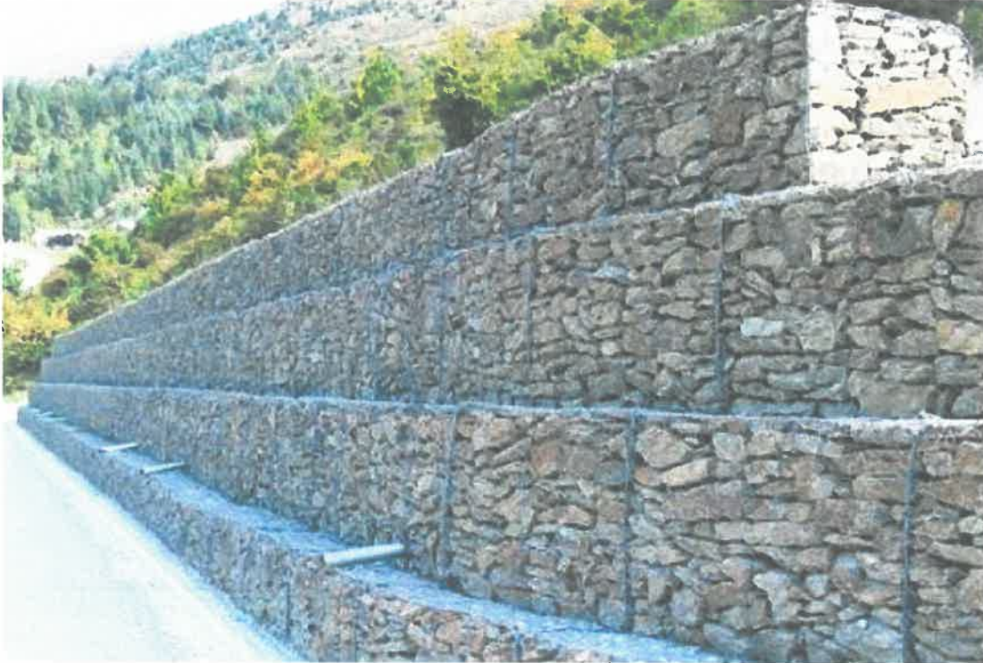
Imagen N° 14: gaviones para encausar la quebrada y evitar daños a la población.
