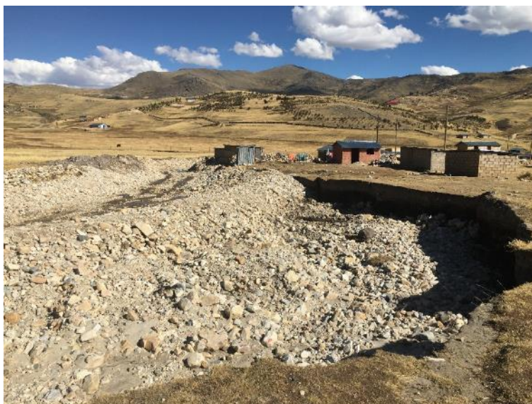
Vista hacia el sur, nótese la erosión que va socavando las márgenes. Se requiere gaviones.
