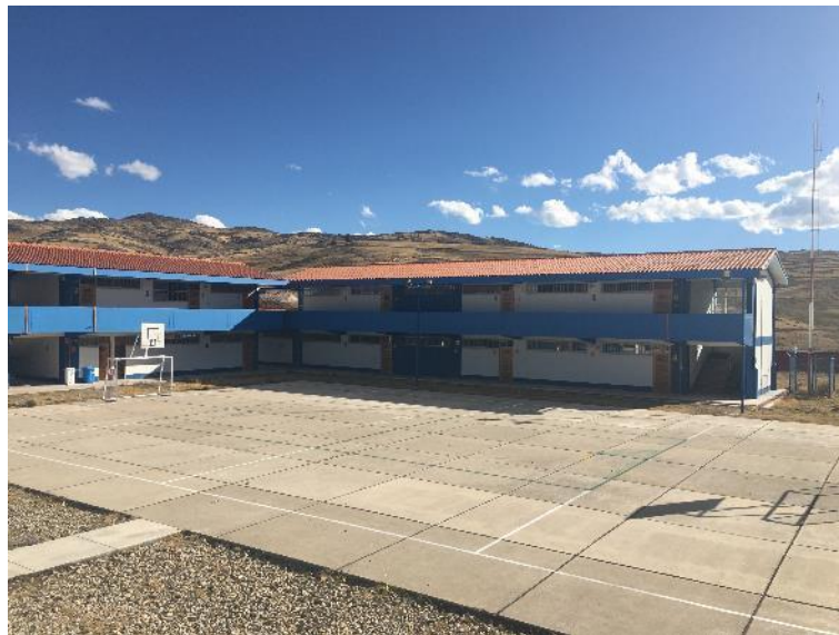
Vista de los pabellones y campo deportivo de la I.E. primaria, en buenas condiciones estructurales.
