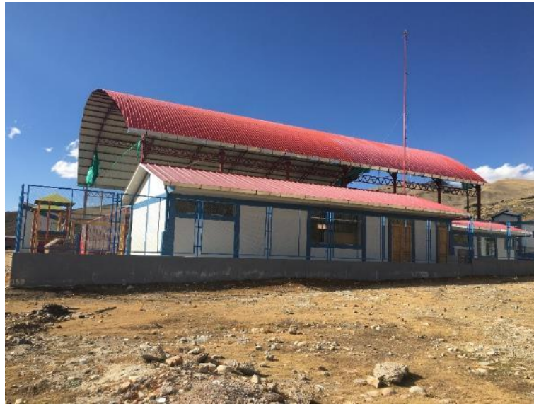
Vista del centro cultural del C.P. Santa Rosa, de concreto armado en buenas condiciones.
