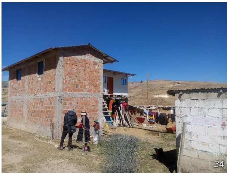
Realización de las encuestas en campo para saber la vulnerabilidad.
