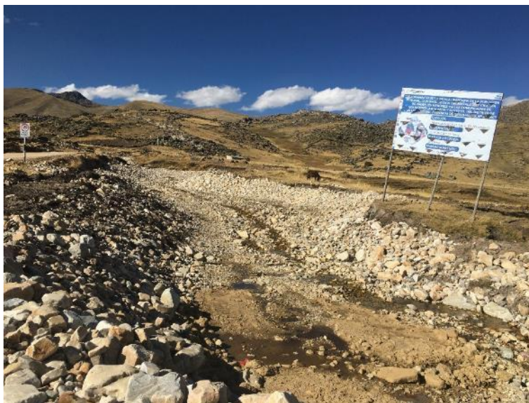
Vista hacia el norte del rio Santa rosa, nótese el material que es arrastrado y sedimentado en la parte baja.
