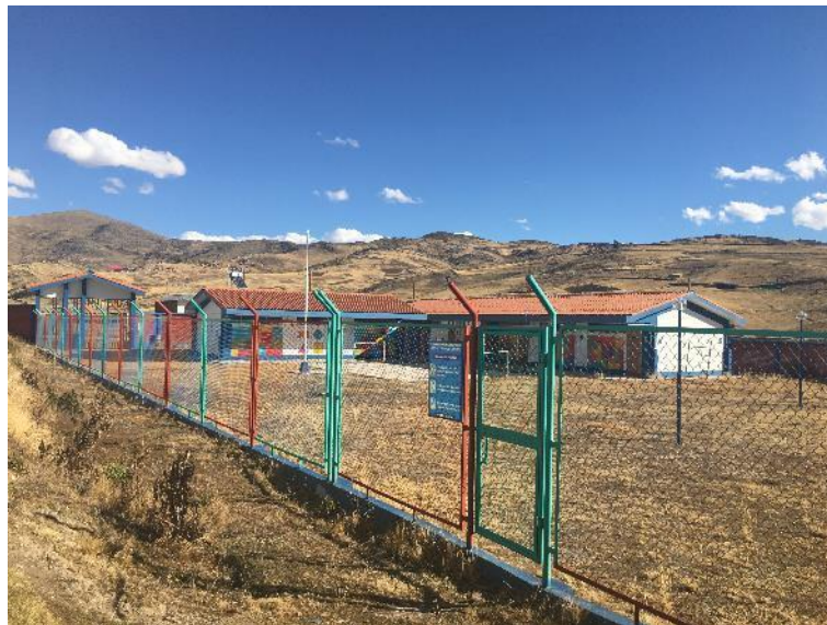
Vista de los pabellones y área de juegos de la I.E. inicial, en buenas condiciones estructurales.
