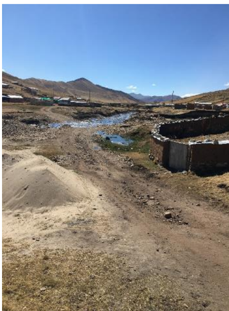
Zona de inundación, no existe puente y en tiempos de inundación cerraría el paso de carretera.
