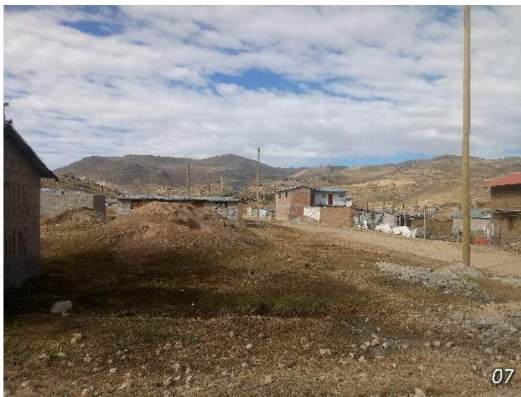
Vista de los postes de electricidad, pero que solo están los postes de madera sin cableado eléctrico.
