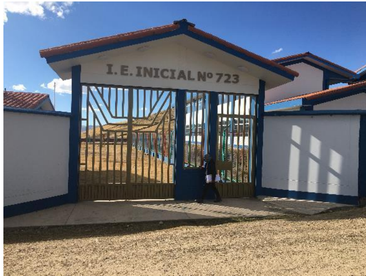
Vista la I.E. inicial, en buenas condiciones estructurales.
