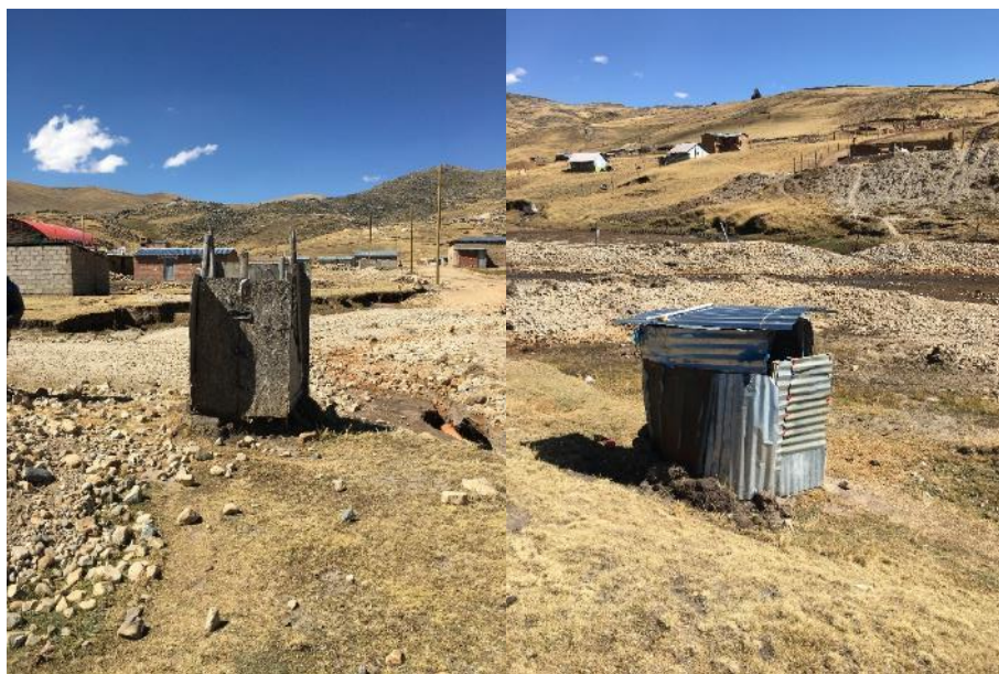
Vista de las letrinas y pozos sépticos ubicado al costado el río.
