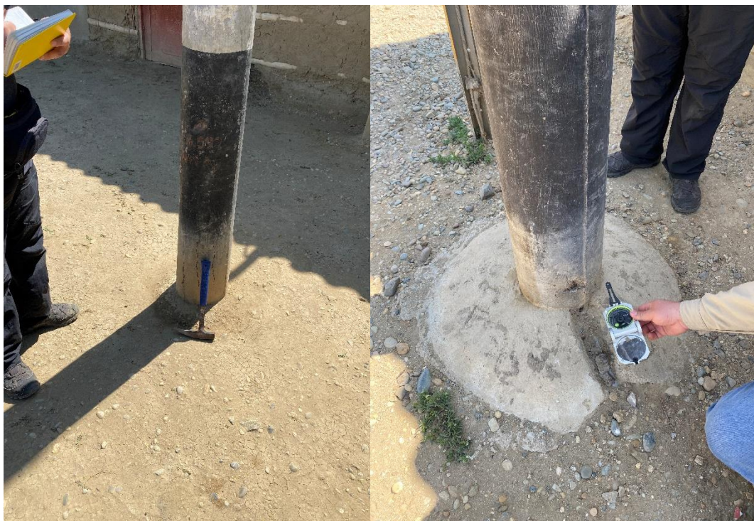
Fotos 3 y 4. Rupturas y agrietamientos en las bases de los postes en el anexo de Isla San Lorenzo en el distrito de Vichayal, producto del sacudimiento del sismo.
