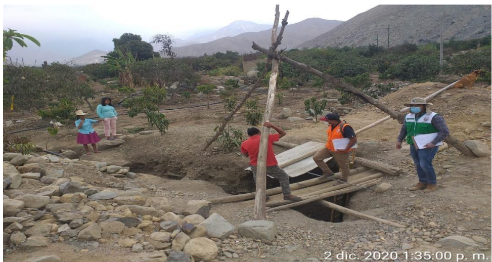
Fotografía N° 29: Agricultores realizar pozos tubulares de concreto h=14m. dentro de sus parcelar para el bombeo de aguas subterráneas.
