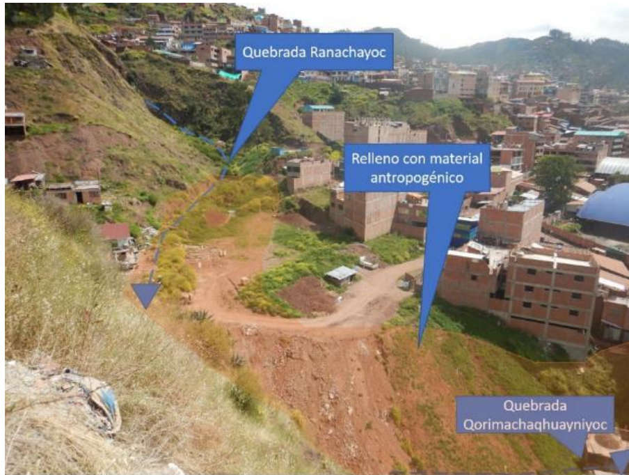
Figura 13. Relleno antropogénico depositado en el cauce obstruyendo las dos quebradas.
