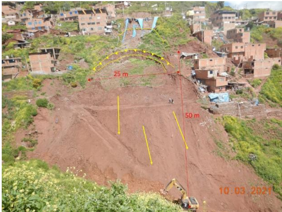
Figura 7. Deslizamiento en la margen izquierda de la quebrada Sacramayo, se aprecia el escarpe principal de 1.5 m de caída y las dimensiones del deslizamiento.
