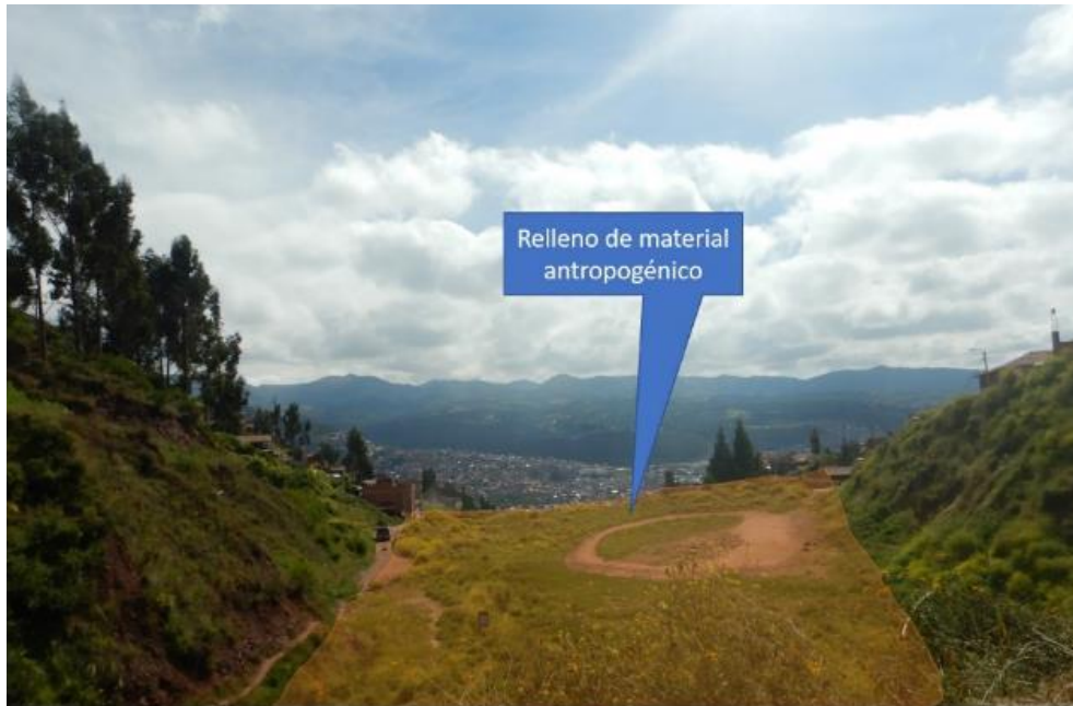
Figura 17. Se aprecia la parte llana, quebrada rellena con material antropogénico, la cual en épocas de lluvias puede generar un flujo con todo el material dispuesto.
