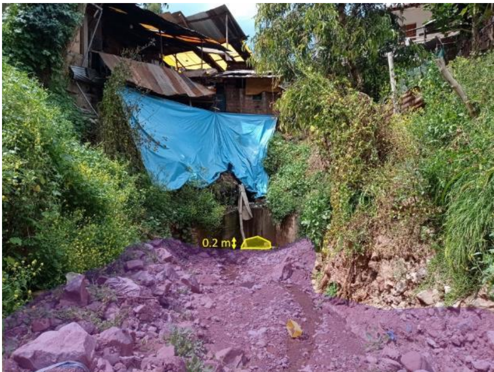
Figura 25. Alcantarilla de 1.5 m de diámetro por donde pasa las aguas de la quebrada hasta desembocar en el río Huancaro (UTM 177044 E, 8501032 N), aquí el flujo de detritos dejó una abertura de 20 cm. Por encima de la alcantarilla existen viviendas y la vía del sector.
