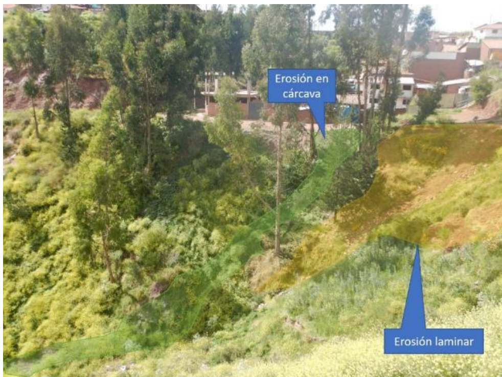
Figura 18. En coordenadas UTM 176127 E, 8501723 N, ladera del depósito, presenta erosión en forma de cárcavas, por ser material de poca compactación.
