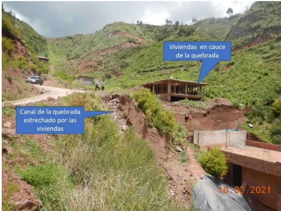
Figura 10. Viviendas construidas en medio del cauce de la quebrada Ranachayoc con el canal reducido, que en época de lluvias constantemente genera flujos de detritos.
