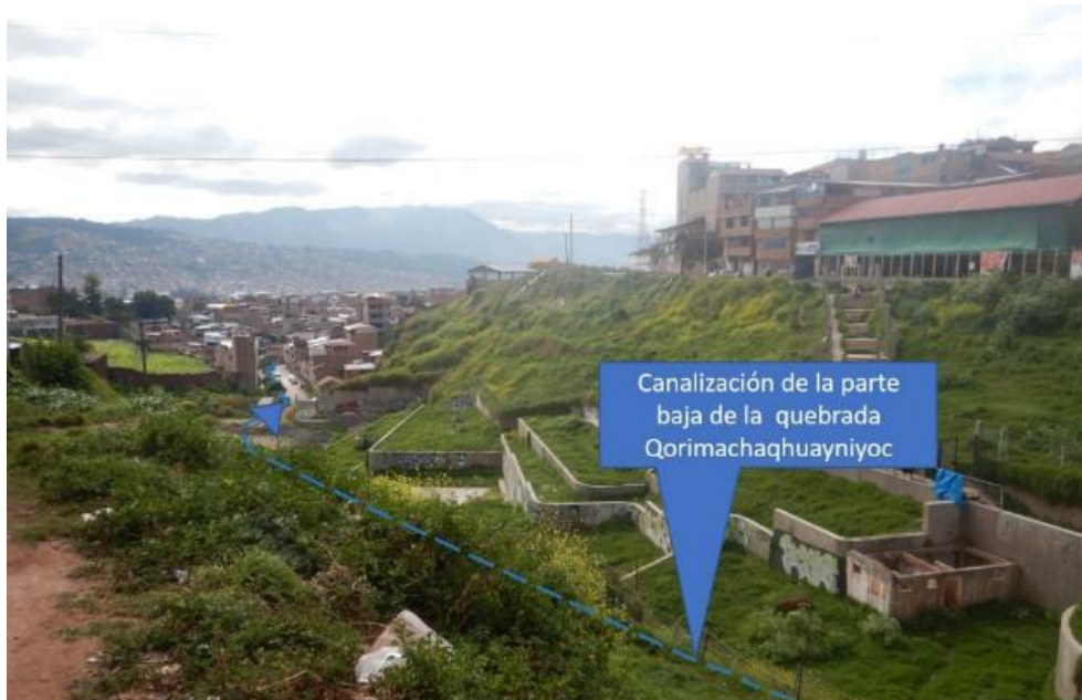
Figura 15. Viviendas en medio del cauce de la quebrada Qorimachaquayniyoc, en la parte baja se encuentra canalizado y pasa debajo de la vía.
