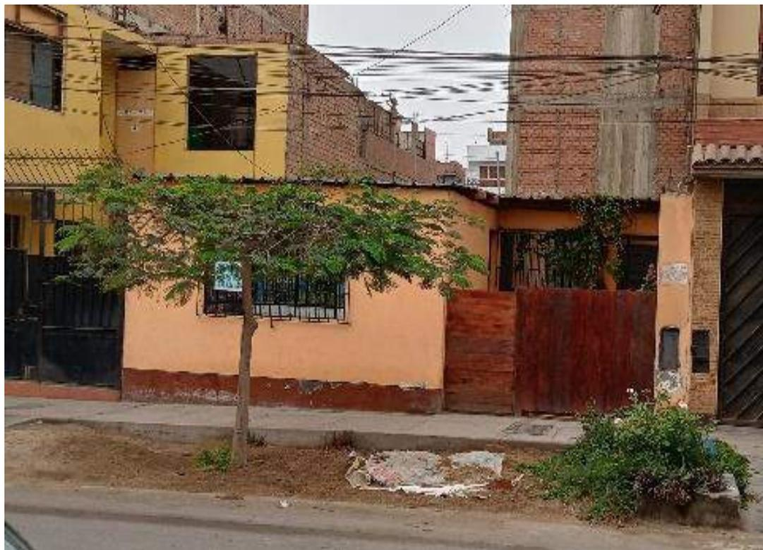
Foto N°7 MZ T-5 Lote 6, casa de ladrillo con techo de calamina y de un piso.
