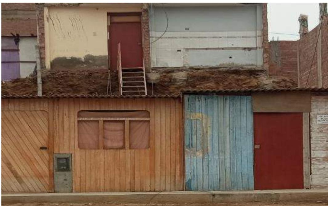
Foto N°66 MZ. Q2 Lote 3 Casa de 1 piso de paredes de madera y techo de calamina.
