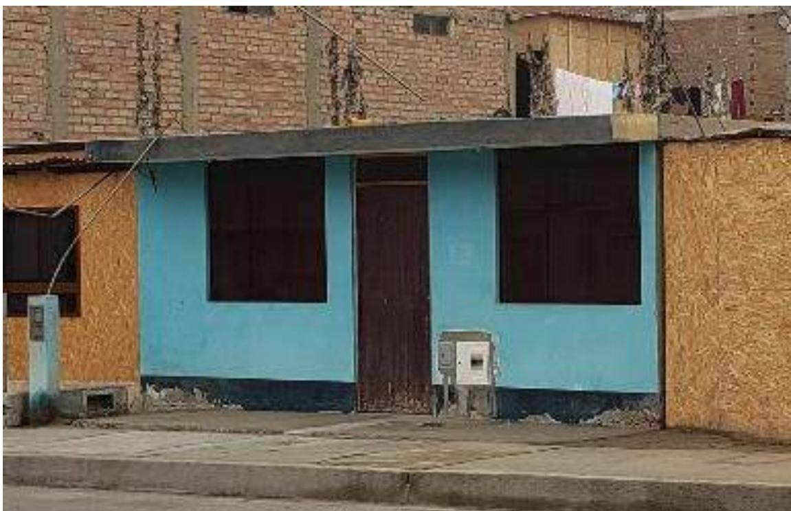
Foto N°67 MZ. T3 Lote 13, casa de ladrillo con techo de losa aligerada.
