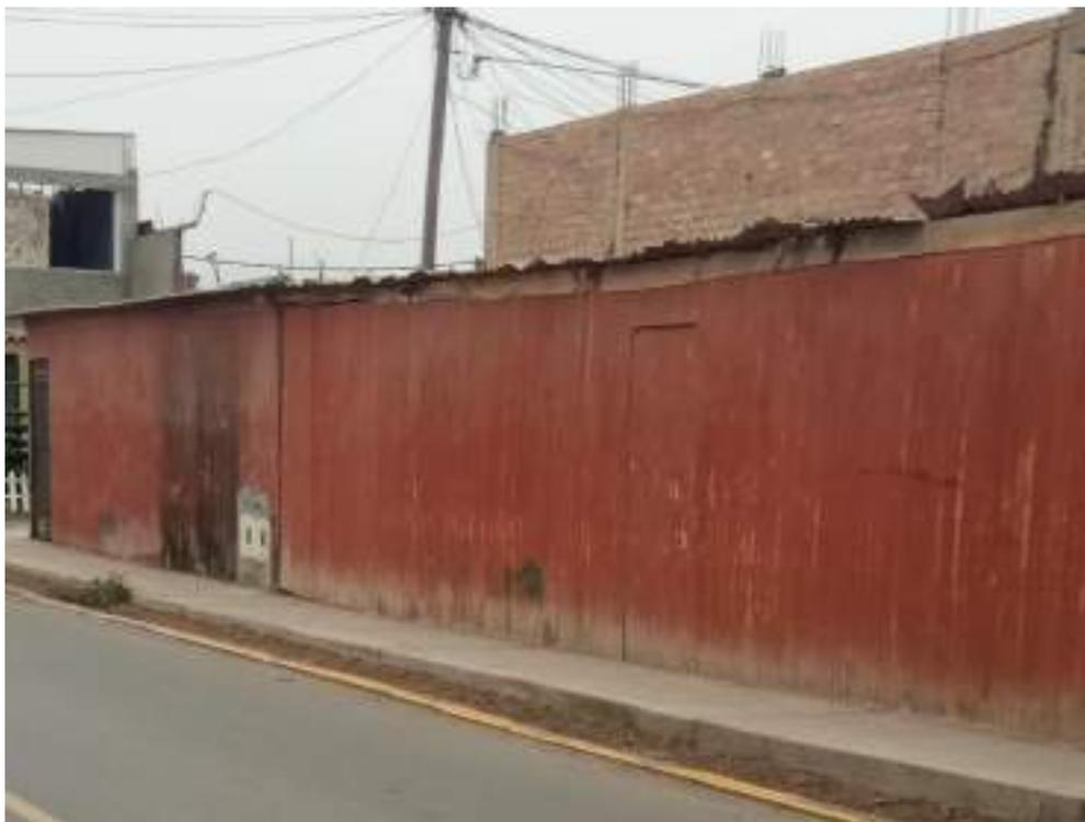
Foto N°39 MZ. I Lote 22 Casa de 1 piso de paredes de tripley de techo de calamina.
