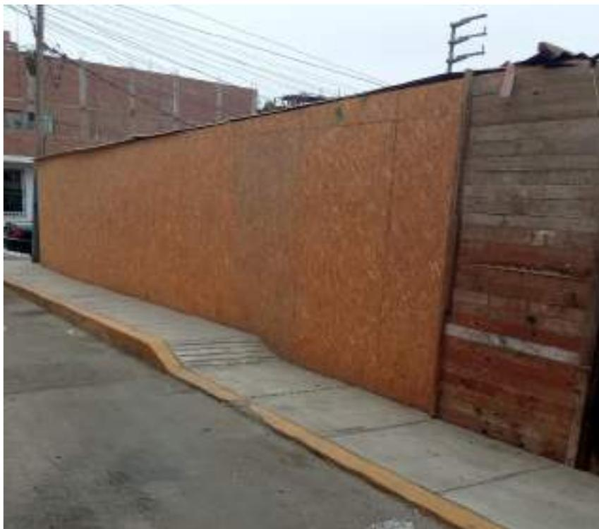
Foto N°41 MZ. H Lote 1. Casa de 1 piso de tripleply con techo de calamina.
