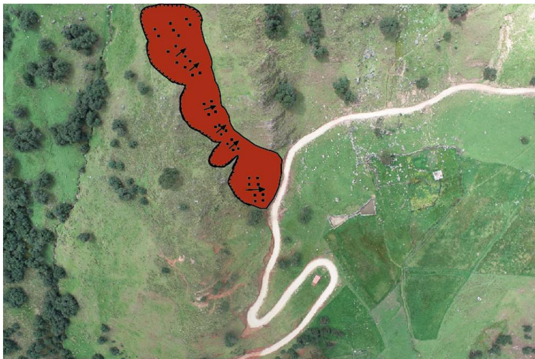
Figura 10. Resaltado de color “rojo vino”, se observa derrumbes antiguos ubicado lado derecho del deslizamiento rotacional antiguo. Coordenadas UTM, zona 18s; Datum WGS 84: 370861.36 E, 8829445.19 S.
