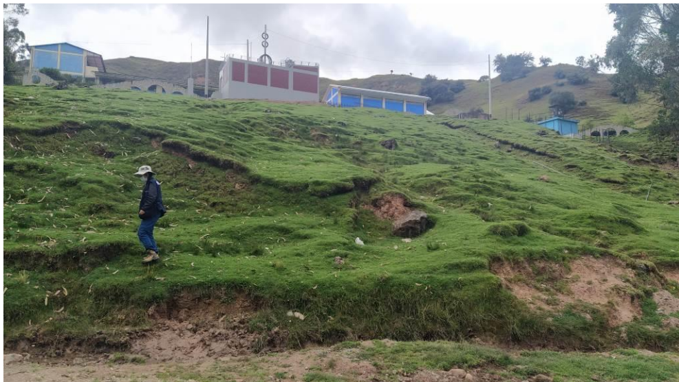
Fotografía 8. Se observa reptación con vista notable de una superficie ondulada. En la parte alta se encuentra situada una institución educativa el cual no presenta algún daño o afectación. Coordenadas UTM, zona 18s; Datum WGS 84: 370539.99 E, 8829138.89 S.
