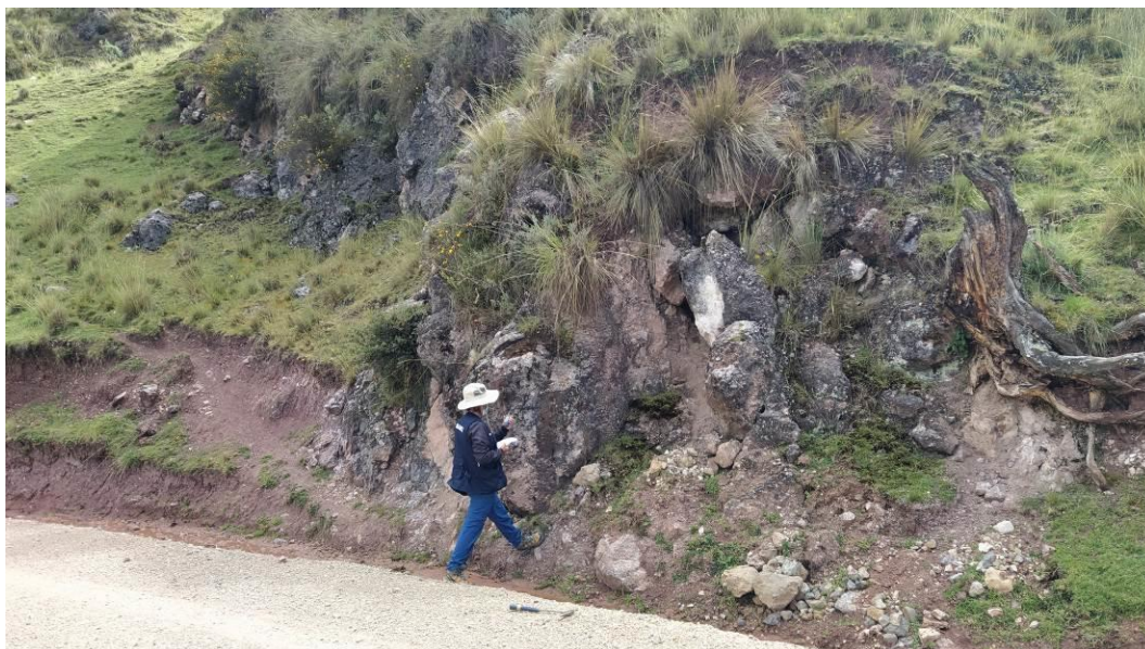
Fotografía 03. Se observa afloramiento de conglomerados con clastos de diferente composición como areniscas y calizas, presentan bloques desprendidos susceptibles a caídas. Coordenadas UTM, zona 18s; Datum WGS 84: 370878 E, 8829403 S.
