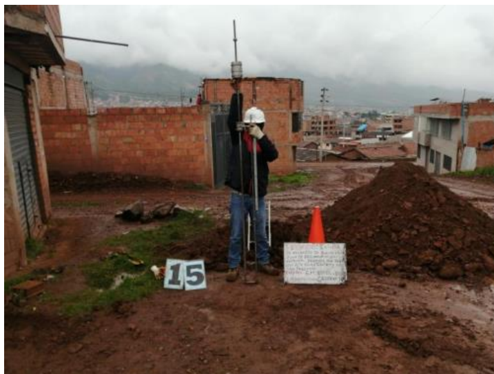
Fotografía: Ensayo DPL para la calicata 15 de la ZRESJ01.
