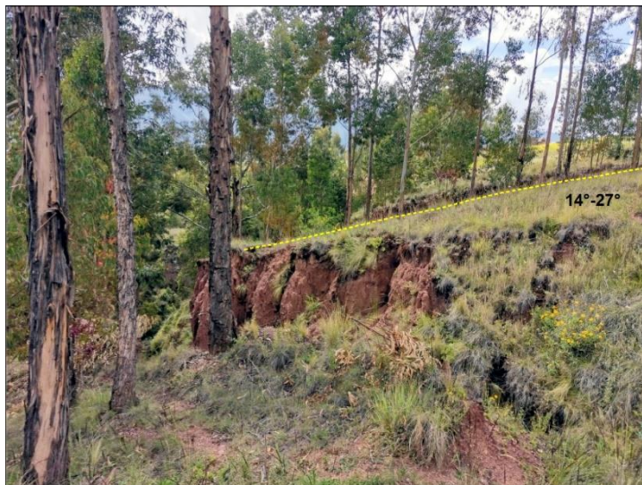
Fotografía: Vista dependiente empinada, zona baja de la APV San Benito Fuente: Equipo Técnico PM41ZRE
