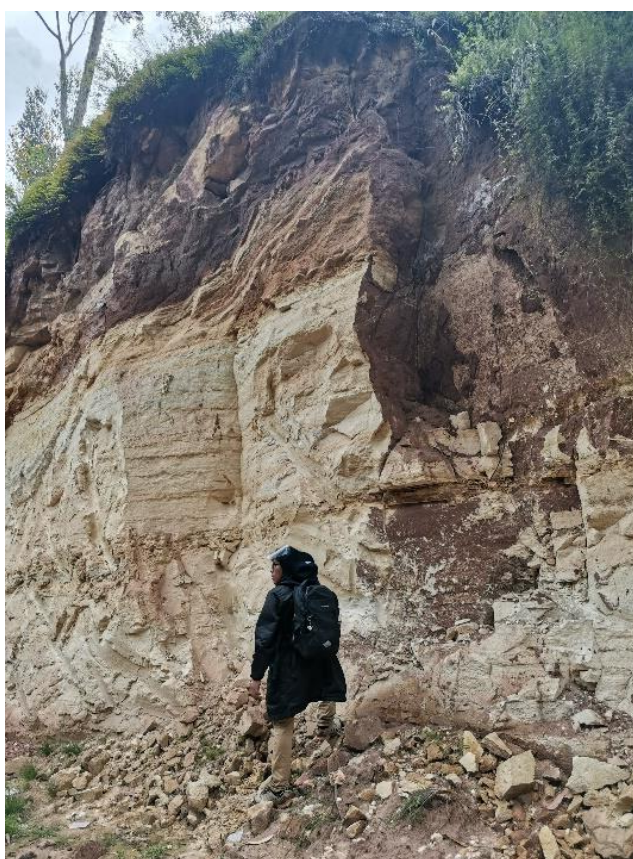
Fotografía: Vista de Altura de Talud de 2.5 a 5 metros Fuente: Equipo Técnico PM41ZRE.
