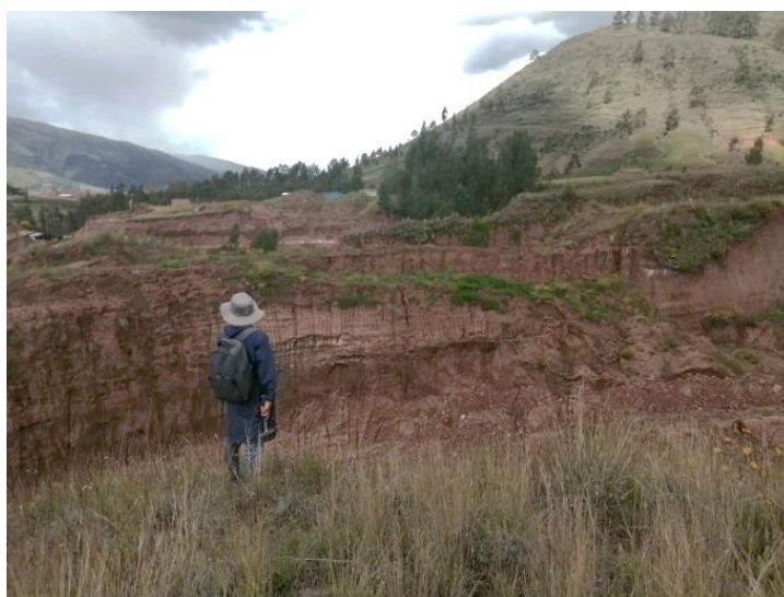
Fotografía: Vista de Altura de Talud de 10 a 20 metros
