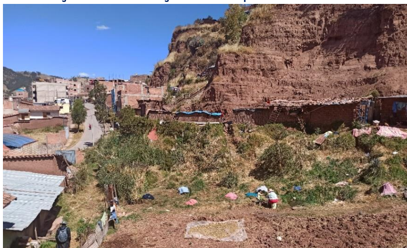
Fotografía 2: Visita de la margen derecha de la quebrada seca Manahuañoncca
