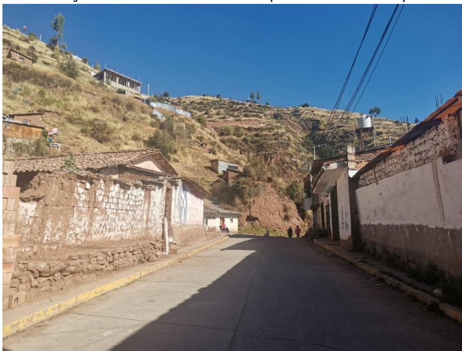
Fotografía 9: Viviendas en laderas de roca arenisca perteneciente a la formación Kayra
