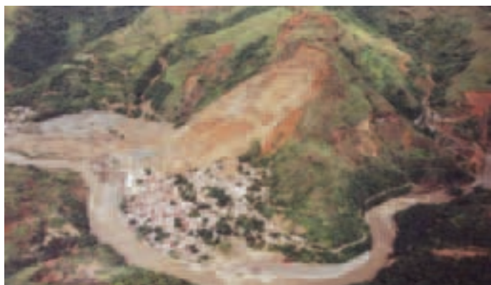
Riesgo de inundación.
