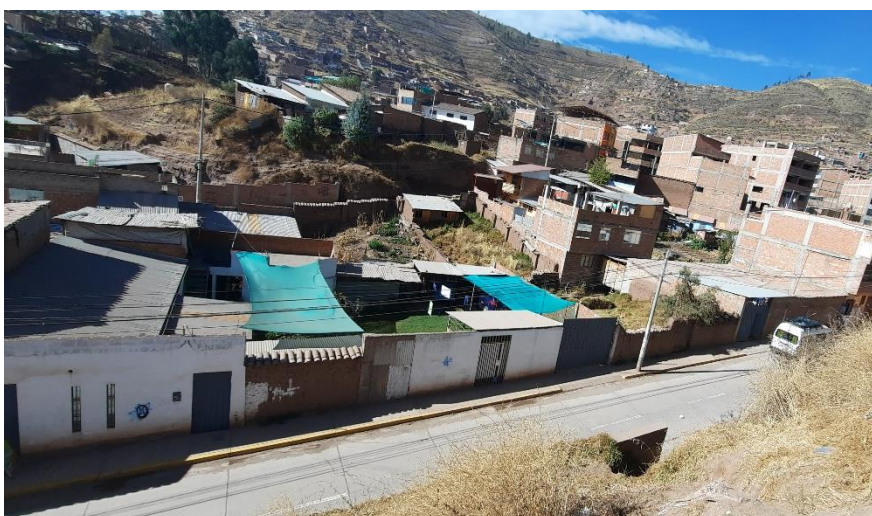
Fotografía 2: Área de servidumbre de la red de mediana tensión en la ZRESS12 Fuente: Equipo Técnico PM41ZRE
