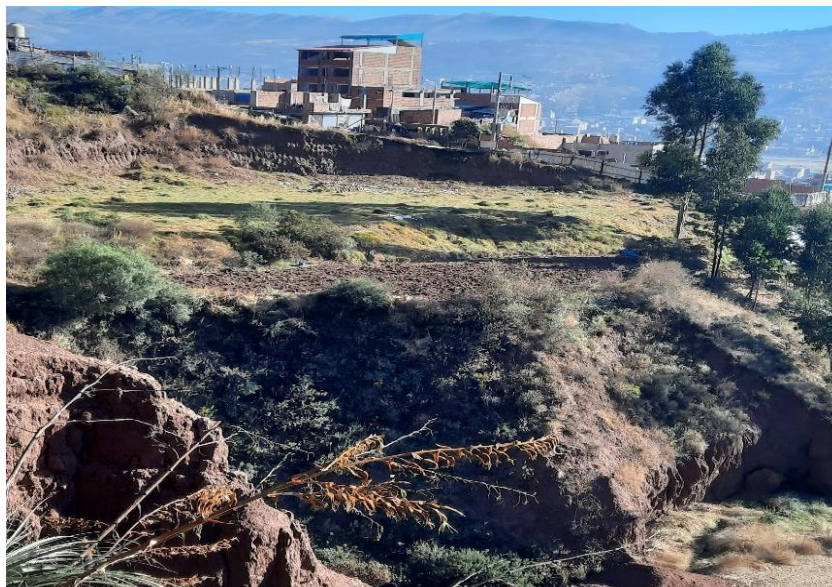
Fotografía 13: Pendiente escarpado en talud de diatomeas.
