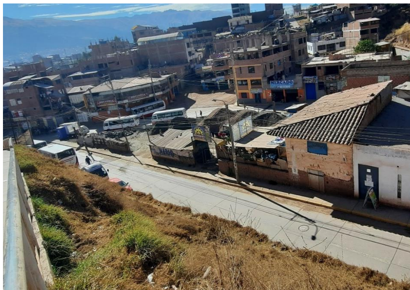
Fotografía 12: Pendientes fuertemente empinado en ladera de quebrada margen izquierda.
