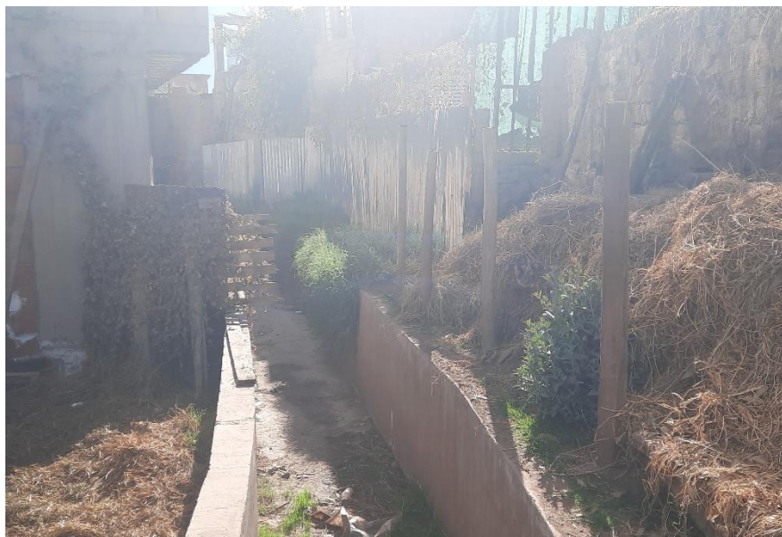
Fotografía 4: Vista del cauce con medidas de mitigación Fuente: Equipo Técnico PM41ZRE
