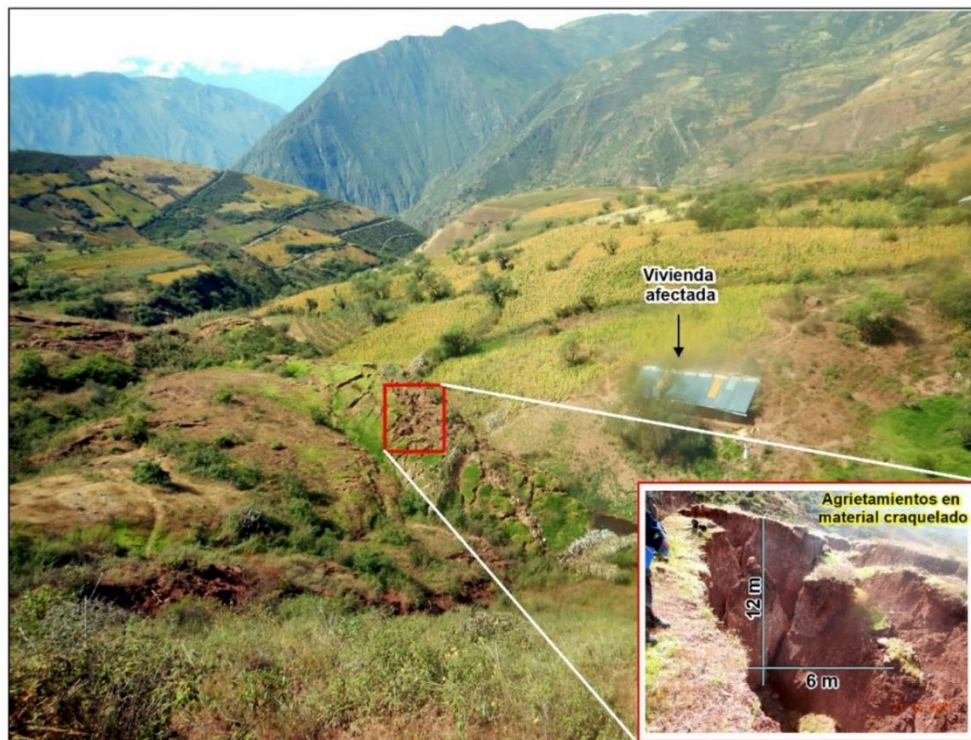
Figura 13. Vista del represamiento, con 10 m de ancho y 15 m de longitud; se estima 3 m de altura. De continuar el incremento del nivel de espejo de agua de la presa, podría afectar a la vivienda asentada en la margen derecha de la quebrada referida.
