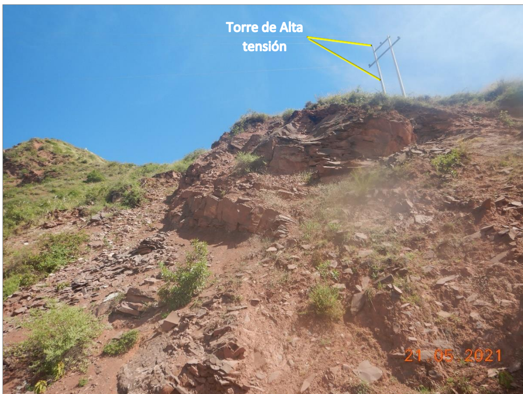
Figura 11. Vista de la torre de alta tensión próxima a la zona de deslizamiento. Con coordenadas UTM (WGS 84): 676832 E, 8508951 N a 3042 m s.n.m.
