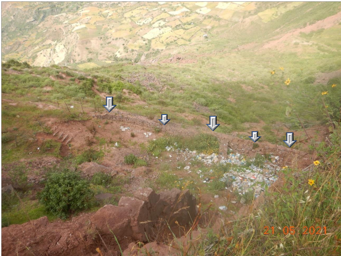
Figura 6. Vista de muro de gaviones, localizado en el cuerpo del deslizamiento activo D-1 de La Merced. Coordenadas UTM (WGS 84): 677044 E, 8509438 N a 3079 m s.n.m.
