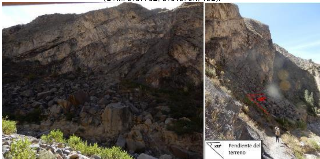
Figura 11. Zona de derrumbe y caída de rocas. Ubicación (UTM: 313404E, 8191642N, 19S).
