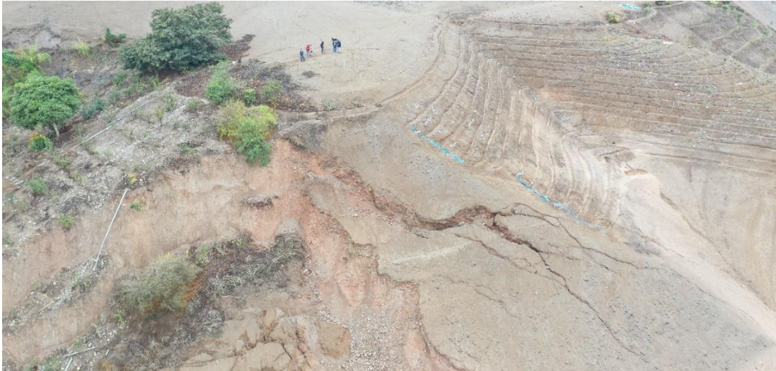
Fotografía 10. Grietas en el lado izquierdo del Deslizamiento El Arenal.
