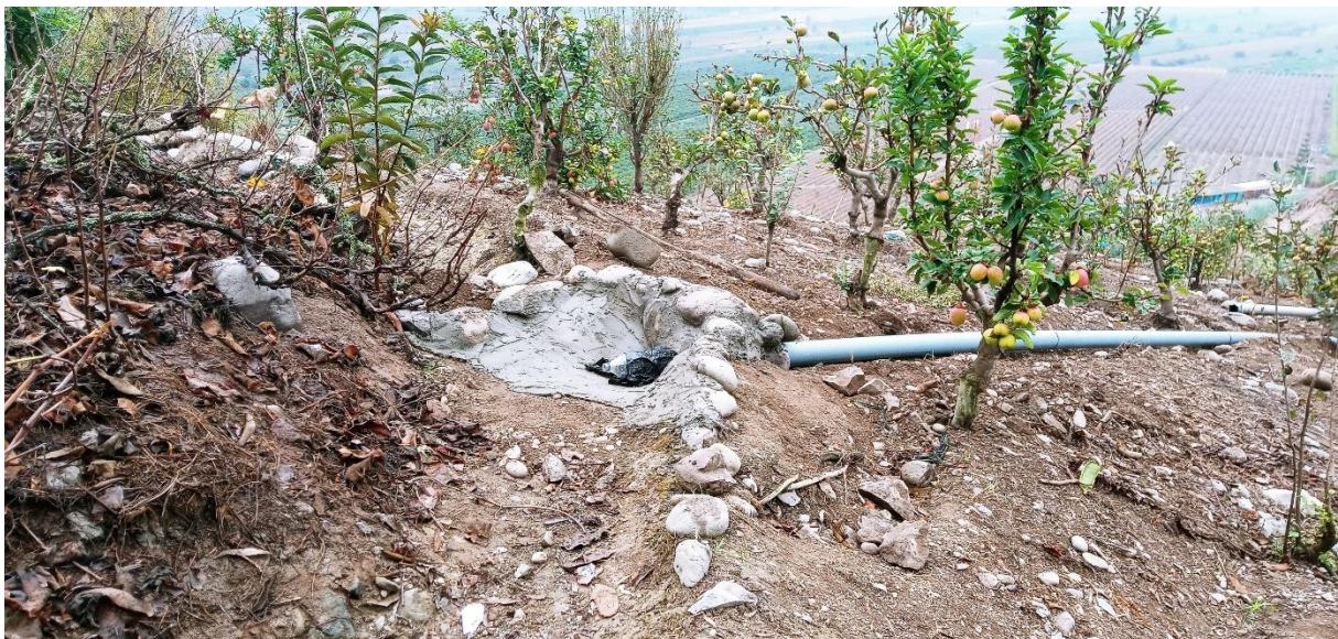
Fotografía 7. Sobre relieve modelado en rocas sedimentarias se observa canal sin revestimiento y tuberías de pvc usados para riego de cultivos de manzanas. Se ubica en la cabecera del deslizamiento El Arenal.
