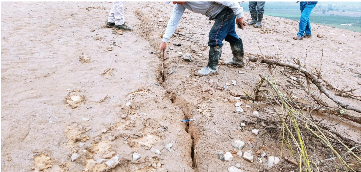
Fotografía 9. Grietas en la cima de la colina.
