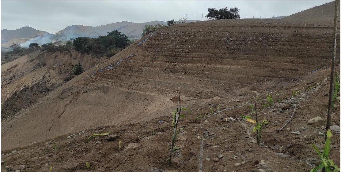
Fotografía 13. Zanjas de infiltración para riego por inundación en tierras de cultivos ubicado en el lado izquierdo superior del deslizamiento
