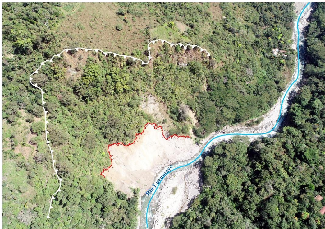
Figura 6. Sector Pedregal, zona afectada por erosión fluvial del río Lucumayo y por flujos provenientes del río Rodeo.
