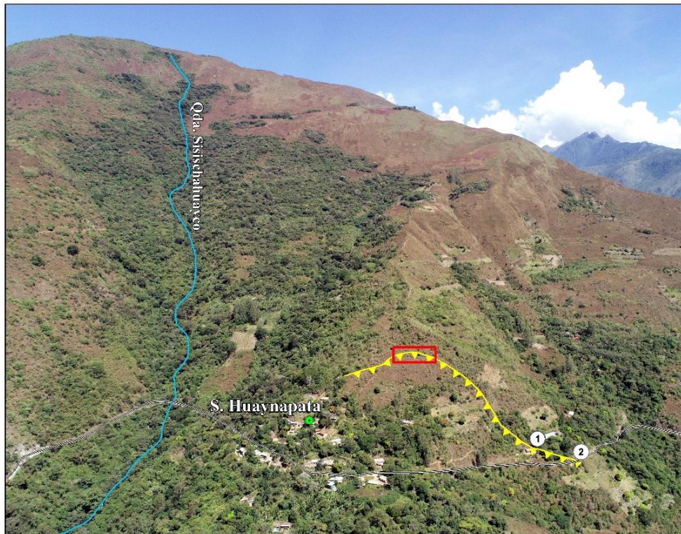
Figura 1. Sector Huaynapata, se observa el escarpe de un deslizamiento.
