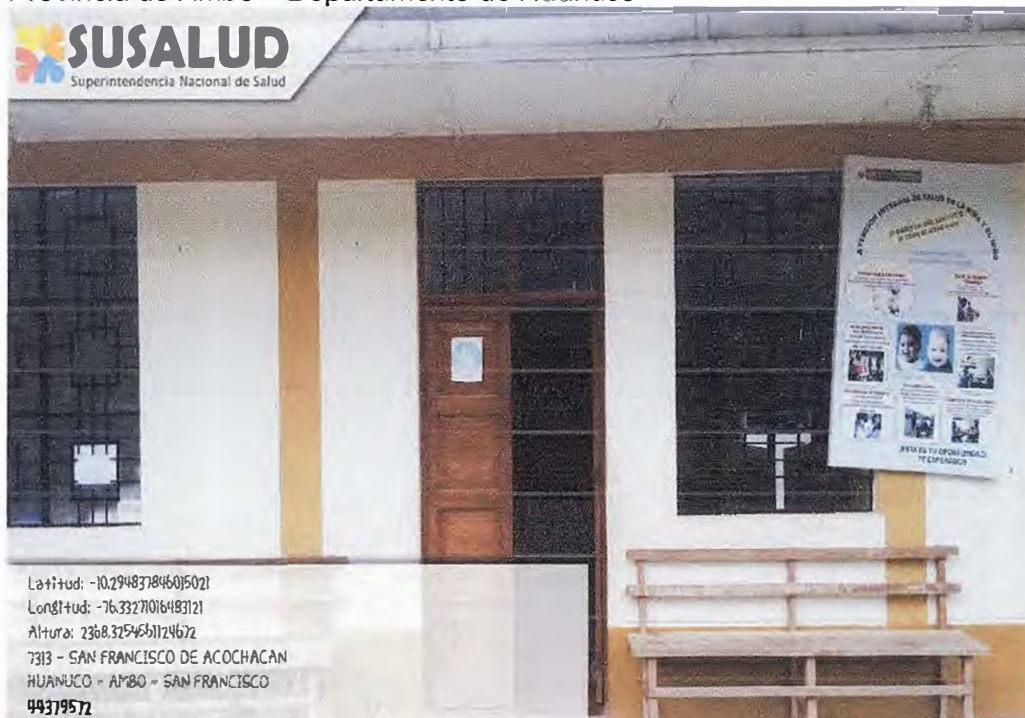
Figura 5: Puesto de Salud categoría I- 1, del Distrito de San Francisco, Provincia de Ambo – Departamento de Huánuco
