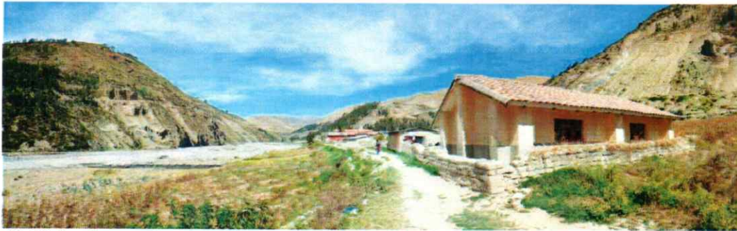
Foto 18: Viviendas y colegio de Ccapana asentadas sobre la terraza, construidos muy cerca del borde.
