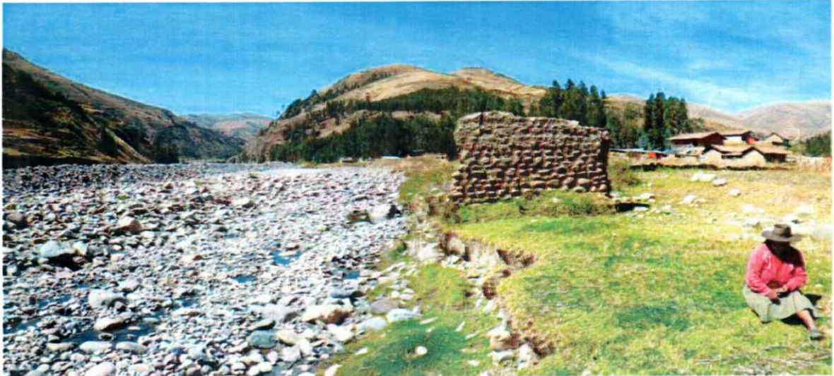
Foto 9: Zona de erosión que afecto terreno de cultivos en la margen izquierda del río Mapocho, sector de Markjopata.
