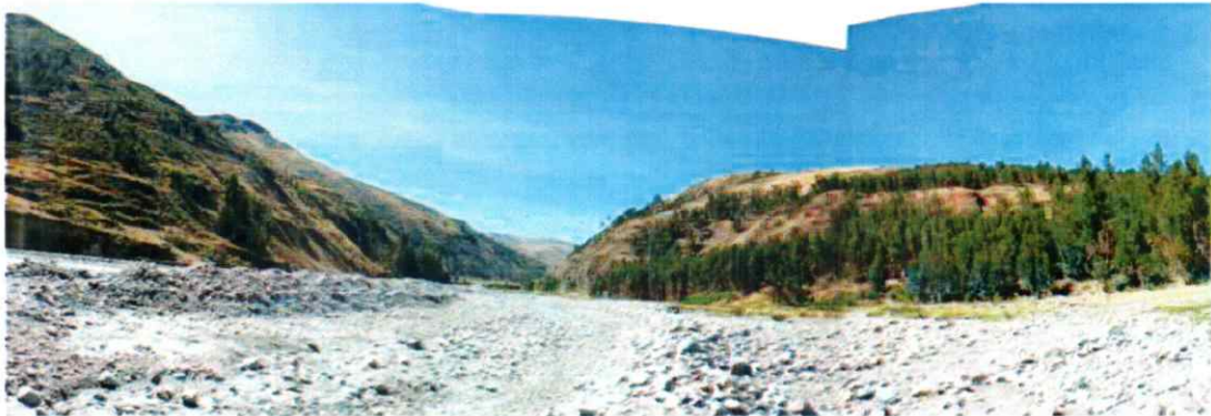
Foto 5: Vista aguas arriba del río Mapocho 9 es posible ver las defensas rivereñas colocadas en una longitud de aproximadamente 750 m.
