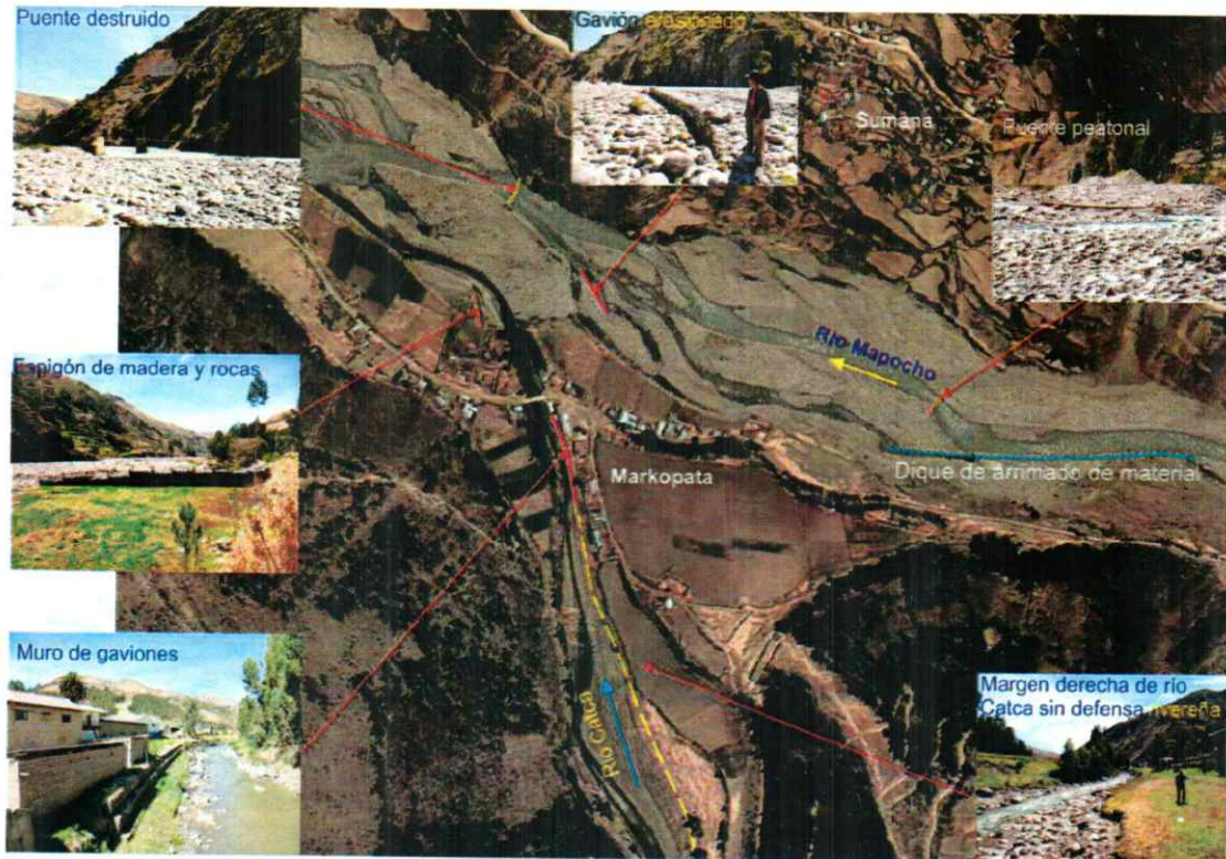
Figura: Imagen Google Earth, donde se señalan las zonas erosionadas, las obras realizadas para controlar el proceso de erosión, así como las zonas donde deberían de implementarse o ampliarse los trabajos de defensa riveriña.
