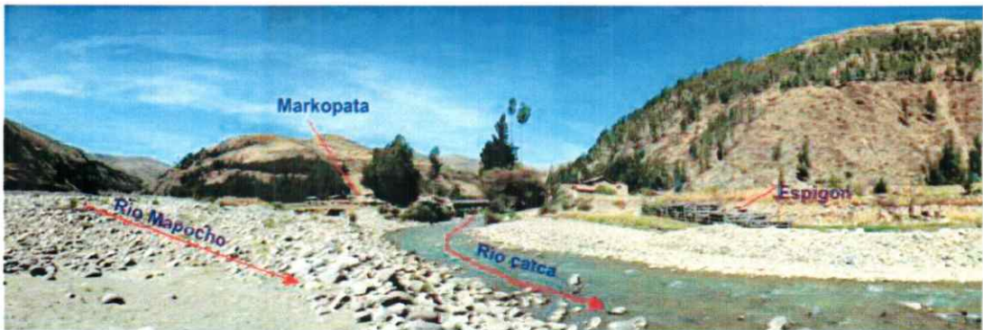
Foto 7: Confluencia del río Ccatcca en el río Mapocho, se señala también la ubicación del poblado de Markjopata y de los espigones hechos con troncos, colocados para controlar la erosión.
