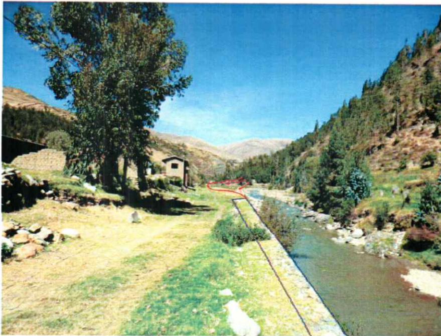
Foto 12: Otra vista aguas arriba donde se puede observar el final del muro de gaviones (línea azul) y el ensanchamiento de la zona erosiva por detrás de esta (línea roja).
