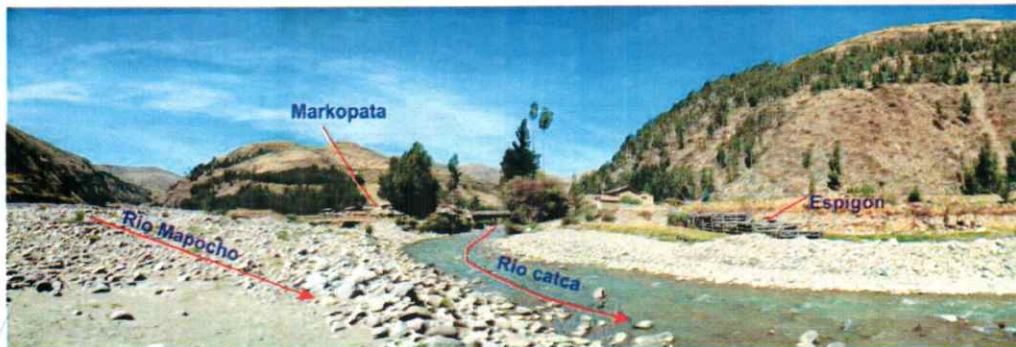
Foto 10: Confluencia del río Ccatcca en el río Mapocho, se señala también la ubicación del poblado de Markjopata y de los espigones hechos con troncos, colocados para controlar la erosión.
