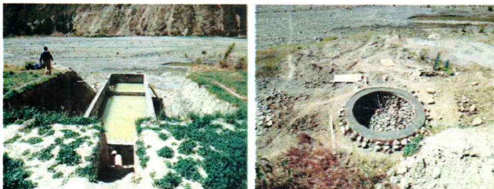
Foto 21: Pozos sépticos construidos en el borde de terraza alta y dentro del cauce del río Mapocho.
