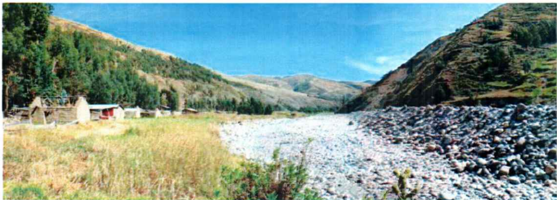
Foto 6: Imagen del sector de Markjopata donde es posible observar la zona erosionada por el río Mapocho; se realizaron trabajos de arrimado de material para proteger las viviendas y los cultivos localizados en la terraza fluvial.
