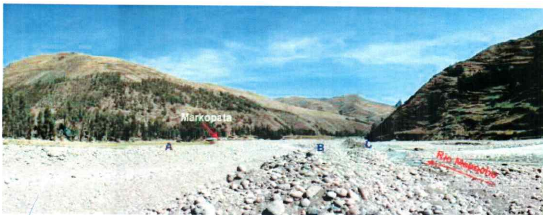
Foto 4: Vista aguas abajo del río Mapocho, donde se han señalado las defensas riverñas existentes, conformadas con el arrimado de material fluvial (A, B y C) y el poblado de Markjopata.
