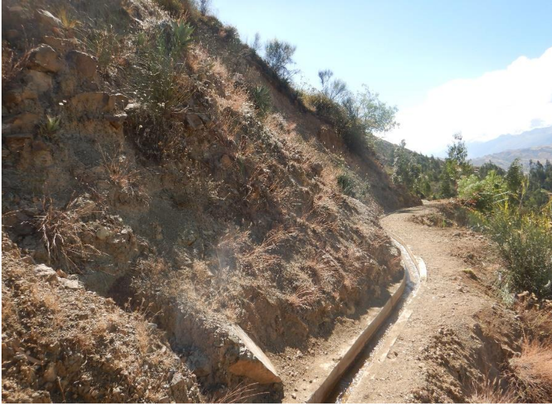
Fotografía 1. Vista del cuerpo del deslizamiento antiguo, en donde se aprecia un canal de concreto de regadío, por donde discurre agua todo el año.
