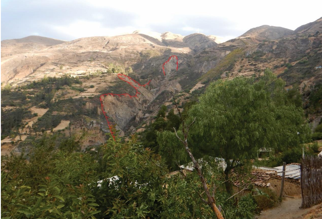
Figura 19. Vista con dirección al noroeste donde se observa derrumbes.
