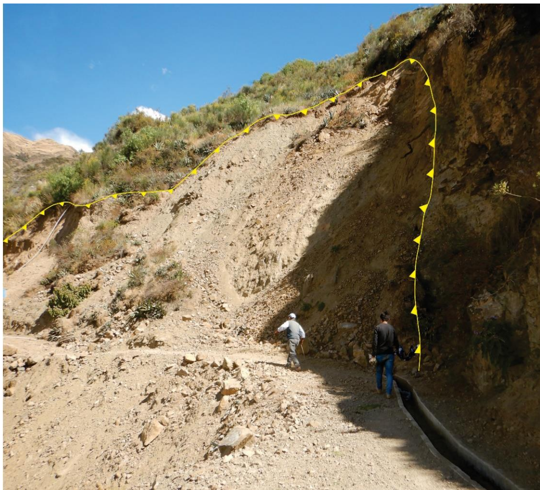
Figura 11. Vista con dirección al suroeste desde el río Santa, donde se puede observar el deslizamiento de tipo rotacional (A) reactivado el 20 de abril del presente año.
