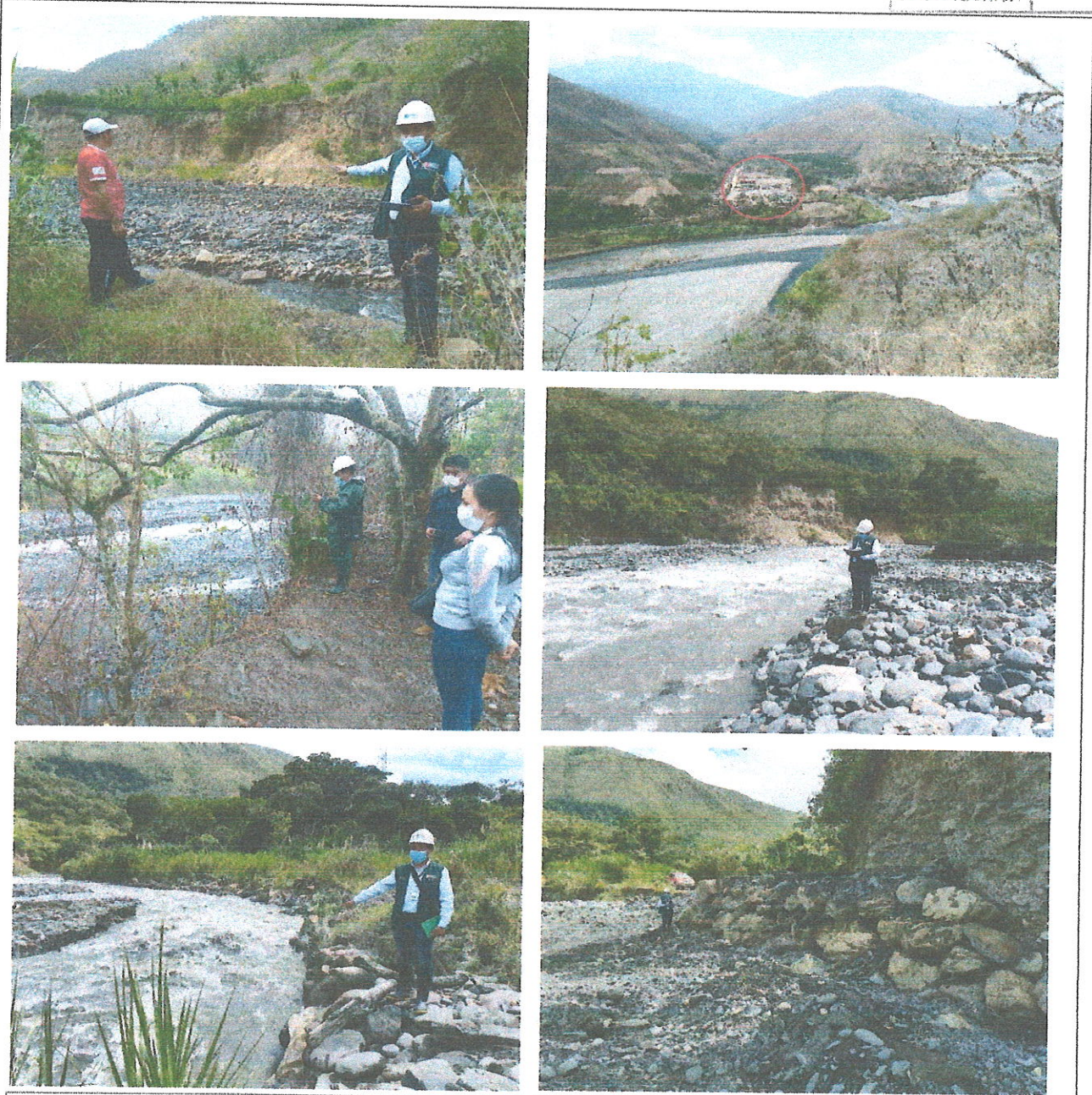
En la columna de fotografías se observa primero : afectación de áreas agrícolas en la margen izquierda del río; segundo : Material a descolmatar en cauce de río; Tercero : Curso del río y la defensa ribereña existente en la margen derecha
