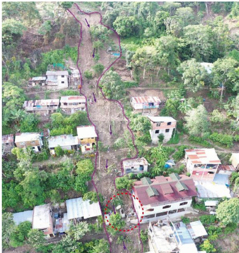
Figura 38. Muestra el recorrido del flujo de detritos en el sector Alto Capelo, y en líneas rojas entrecortadas muestra la ubicación de la vivienda destruida.
