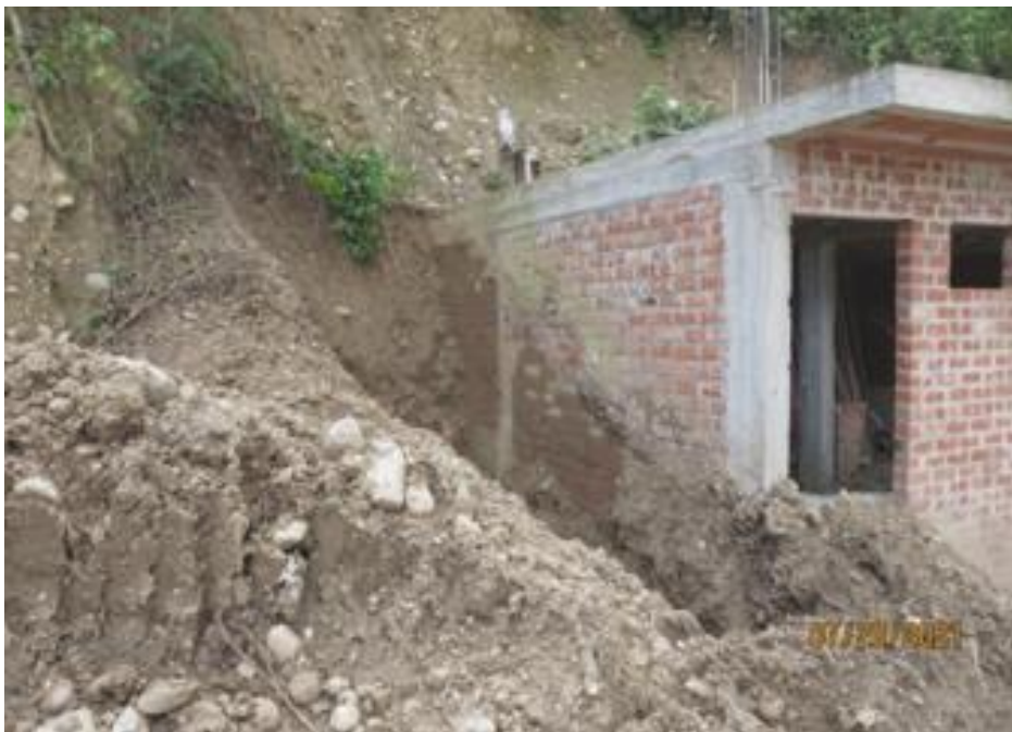
Figura 36. Muestra la excavación de la ladera para la construcción de viviendas, y como posteriormente, los depósitos coluvio-deluviales vuelven a cubrir las edificaciones, debido a la inestabilidad de la ladera en el sector Cerro La Cruz.
