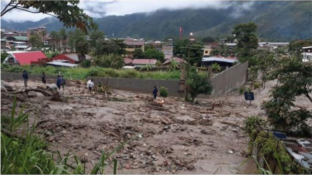
Figura 40. Escombros detríticos en la desembocadura de la quebrada María Pía. Fuente: Área de defensa civil de la municipalidad provincial de Chanchamayo (22-02-2021).
