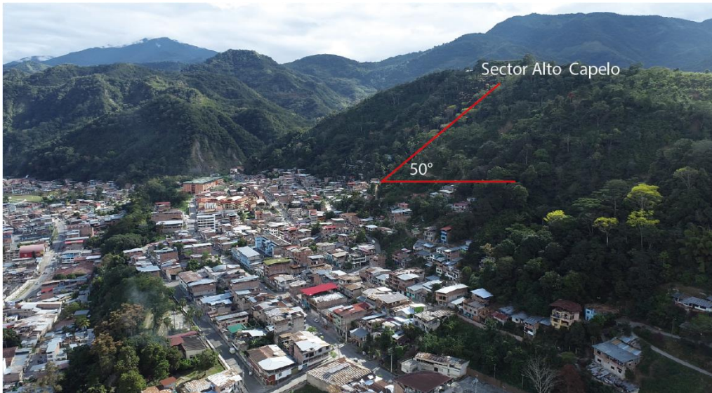
Figura 11. Se observa la pendiente promedio de la ladera sureste del sector Cerro Alto Capelo,
