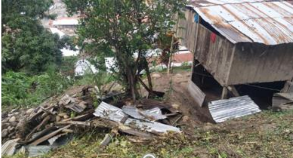
Figura 37. Viviendas precarias afectadas por el flujo de detritos en el sector Alto Capelo.
