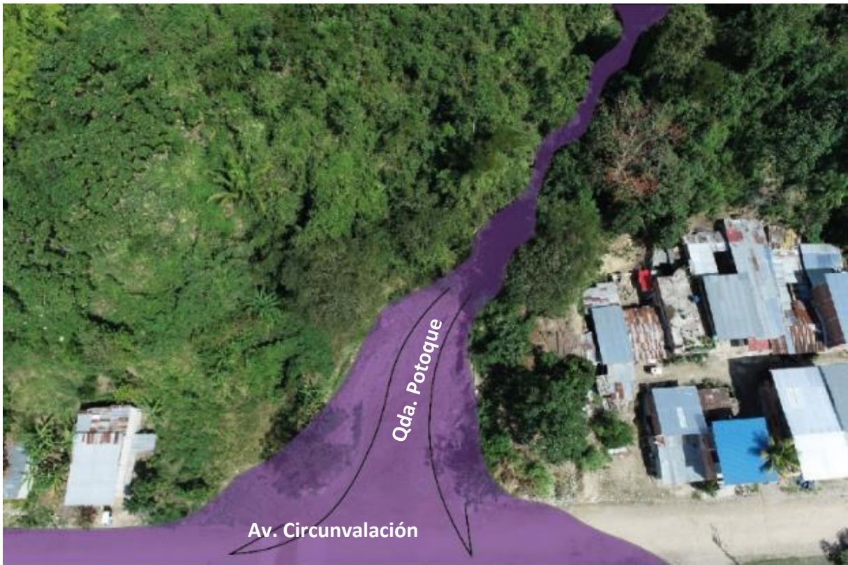
Figura 34. Zona de inundación en la desembocadura de la Quebrada Potoque, por flujo de detritos
