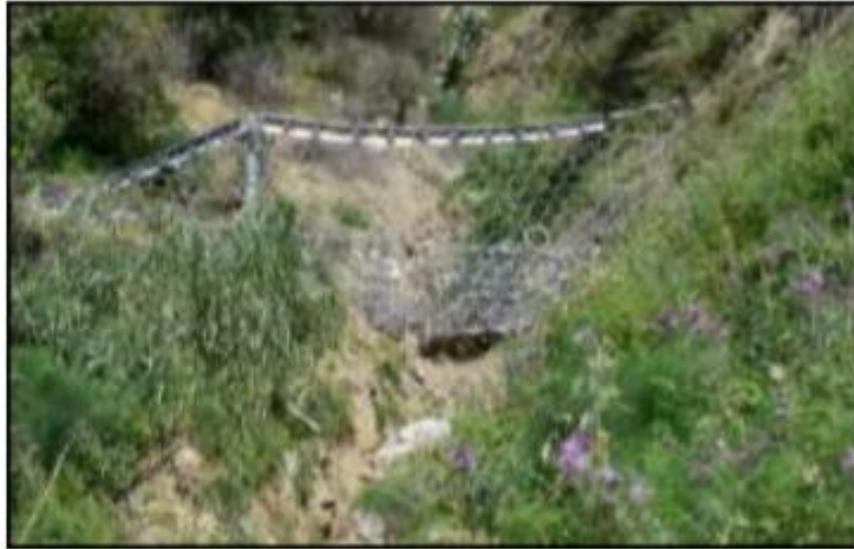
**Figura 10.** Diseño de barras flexibles de cables para retener corrientes de flujos de detritos.
