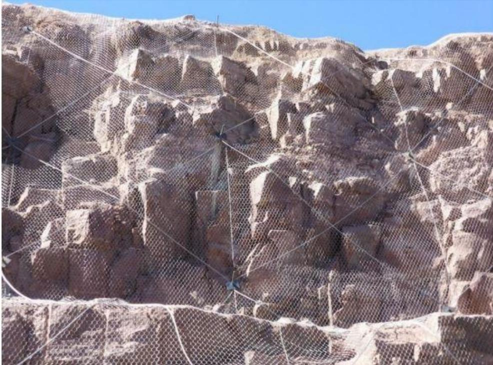
**Figura 10.** Control de caída de rocas utilizando mallas ancladas.
