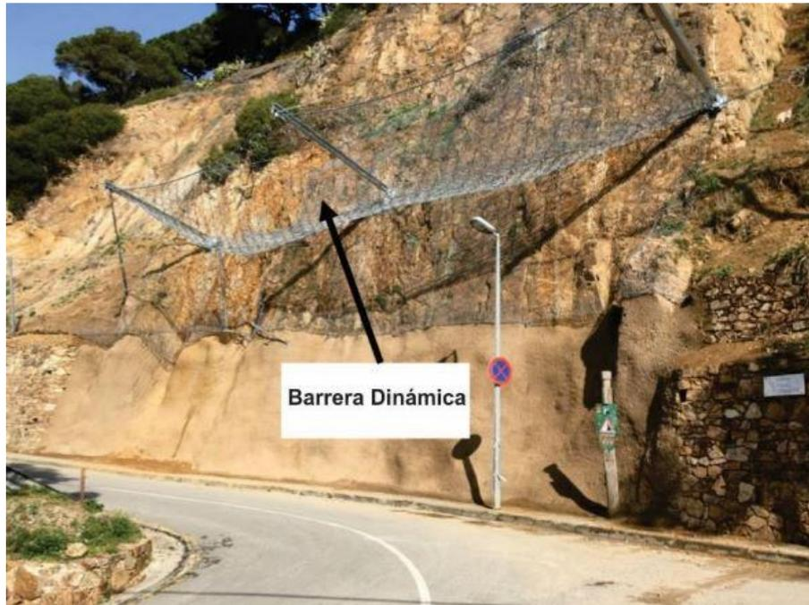
**Figura 11.** Ejemplo de barrera dinámica.
