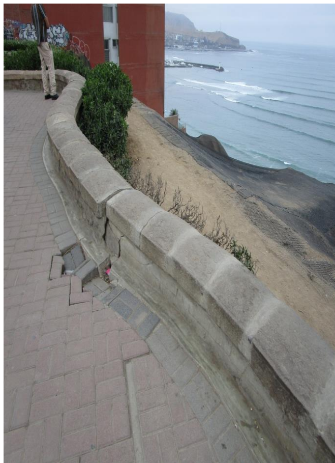
Figura 41. ... Continuación.../. Imagen del desplazamiento del muro del Malecón Souza
