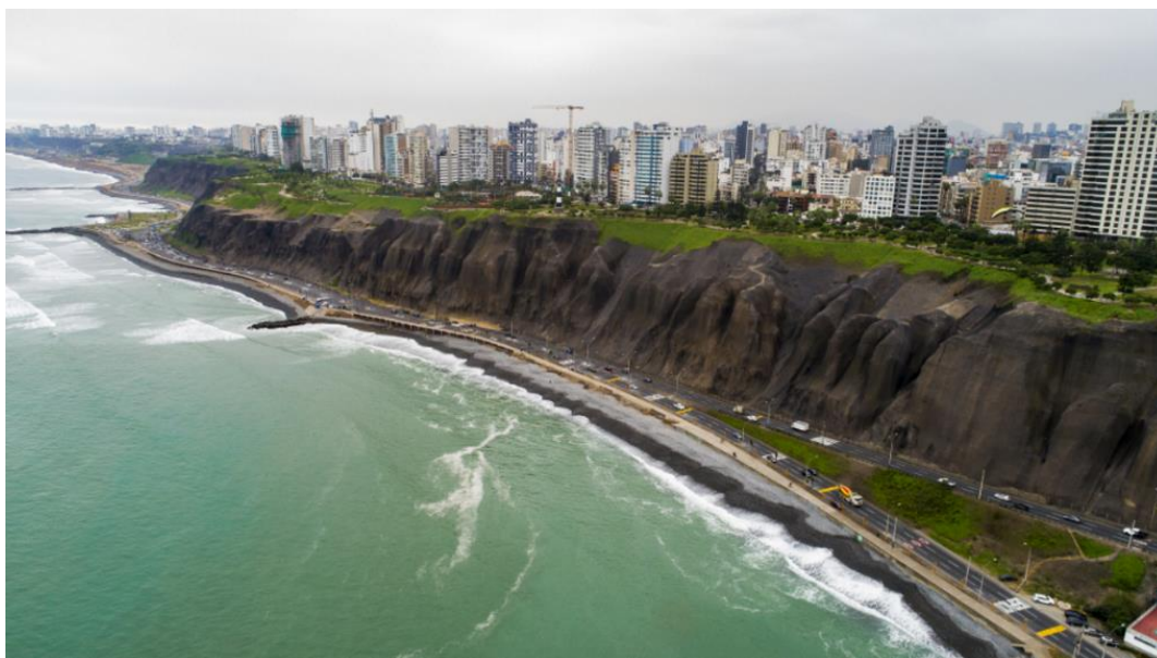
Figura 1: Imagen panorámica de los ACV (Fuente: Revista Perú Construye).
