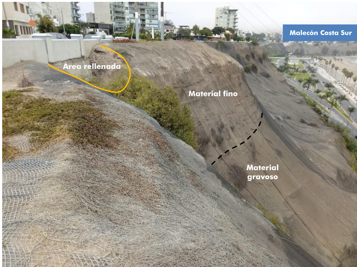
Figura 4. a) Vista de la estratigrafía de los ACV en el distrito de Chorrillos (Malecón Costa Sur). Observándose en la parte baja del acantilado, depósitos de aluviales conformados por gravas con intercalaciones de lentes de finos y en la parte superior el predominio de material fino.
