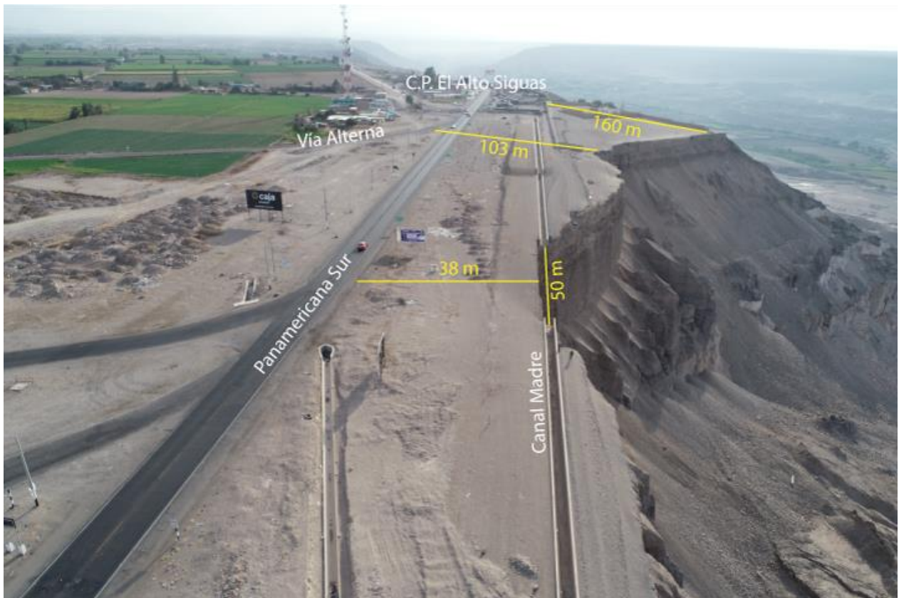
Figura 4. Fotografía aérea capturada con dron donde se muestra el sector de la escarpa principal que se encuentra más próxima a la carretera Panamericana Sur.
