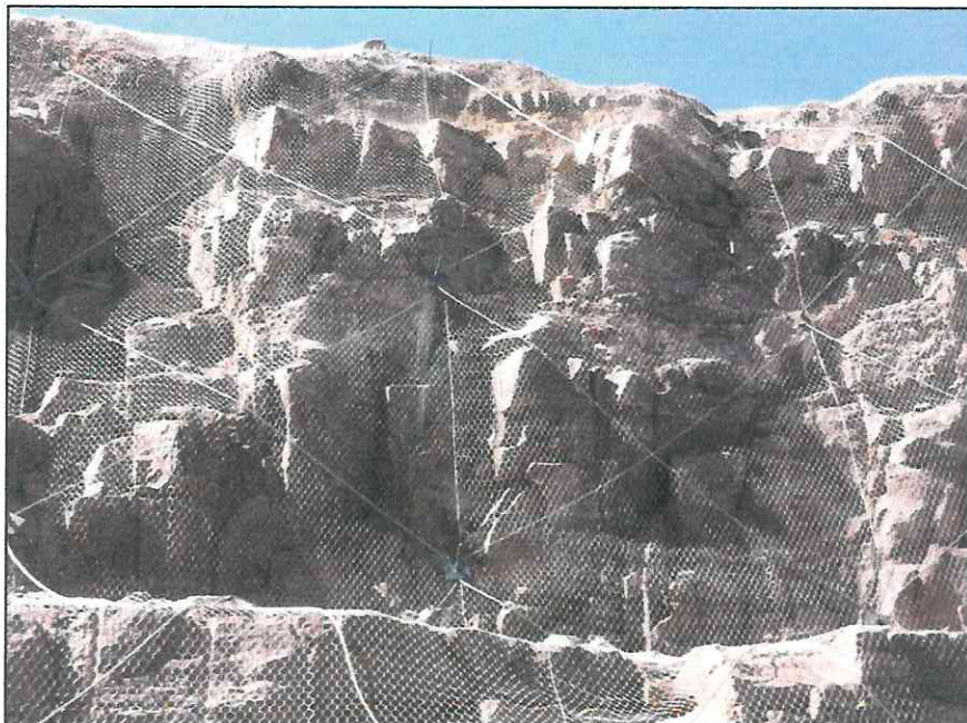
Ilustración N° 13 Malla anclada para talud fracturado
