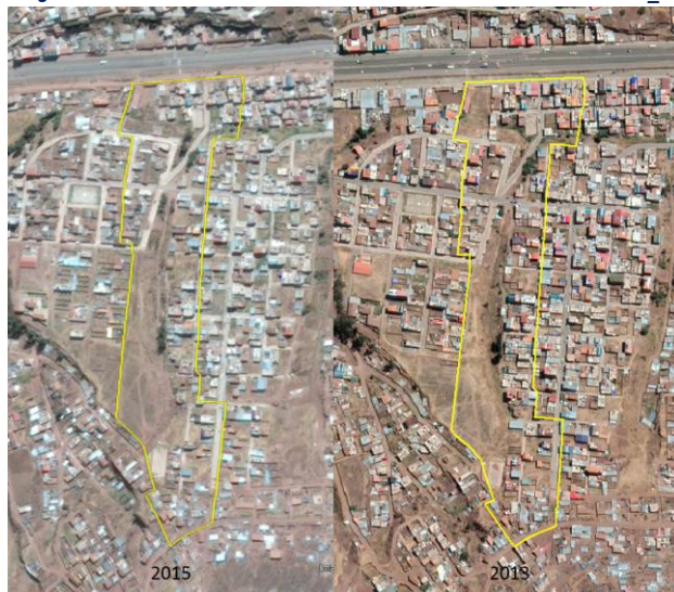
Imagen N° 15: Viviendas consolidadas en zonas de cárcavas ZRESS11_17.
