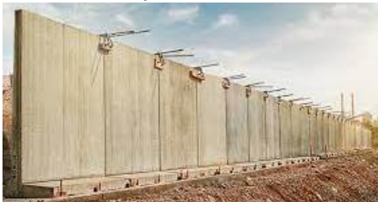
Imagen N° 36: Muro de contención
