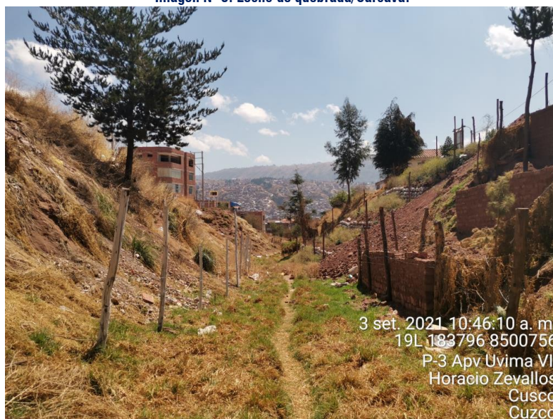
Imagen N° 8: Lecho de quebrada/Cárcava.
