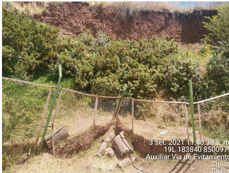
Imagen N° 7: Taludes escarpados donde existe caída de suelos a causa de la erosión pluvial, sector de Uvima II.
