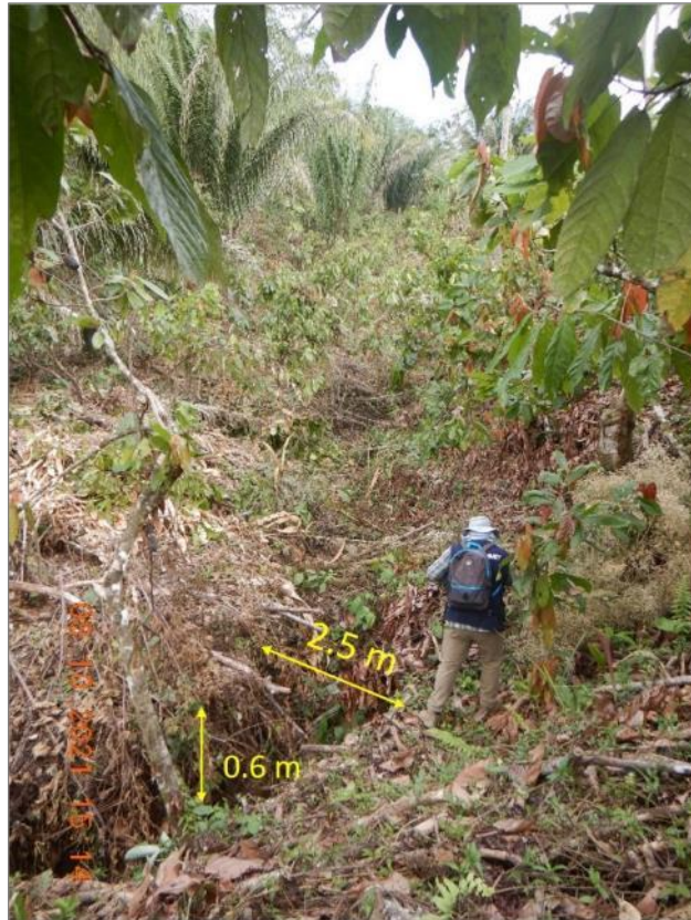
Figura 3. Vista del canal seco con medidas y presencia de troncos dentro del mismo (coordenadas UTM: 631035 E; 8607794 N).
