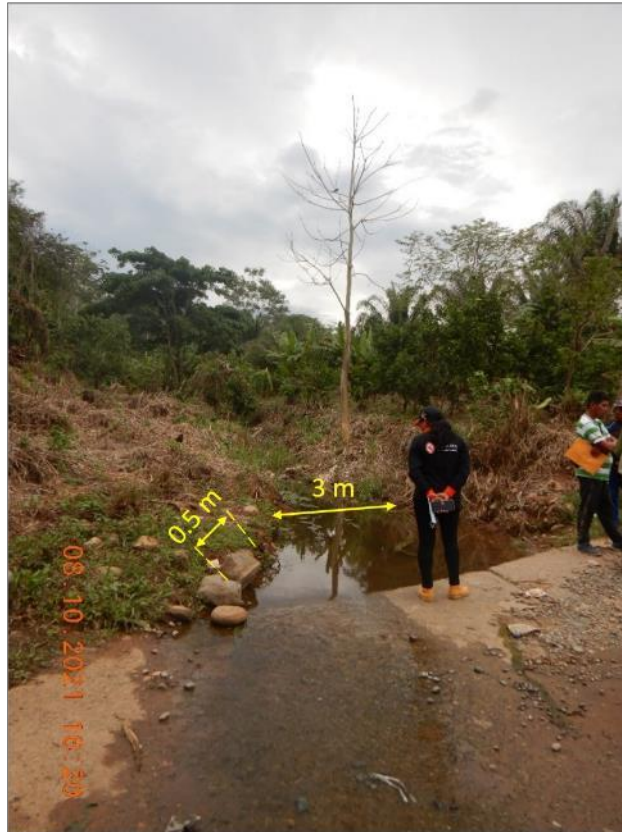
Figura 4. Vista del canal de 3 m de ancho y 40 cm de altura, que corta badén de vía principal.
