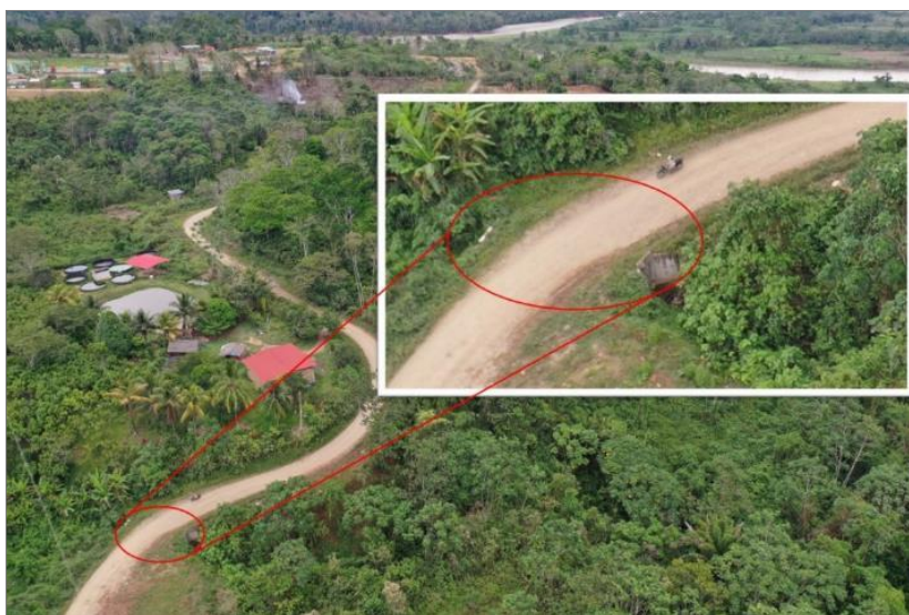
Figura 7. Vista de la alcantarilla en la vía, por donde podría pasar inundaciones. En coordenadas UTM: 630959E; 8608089N.
