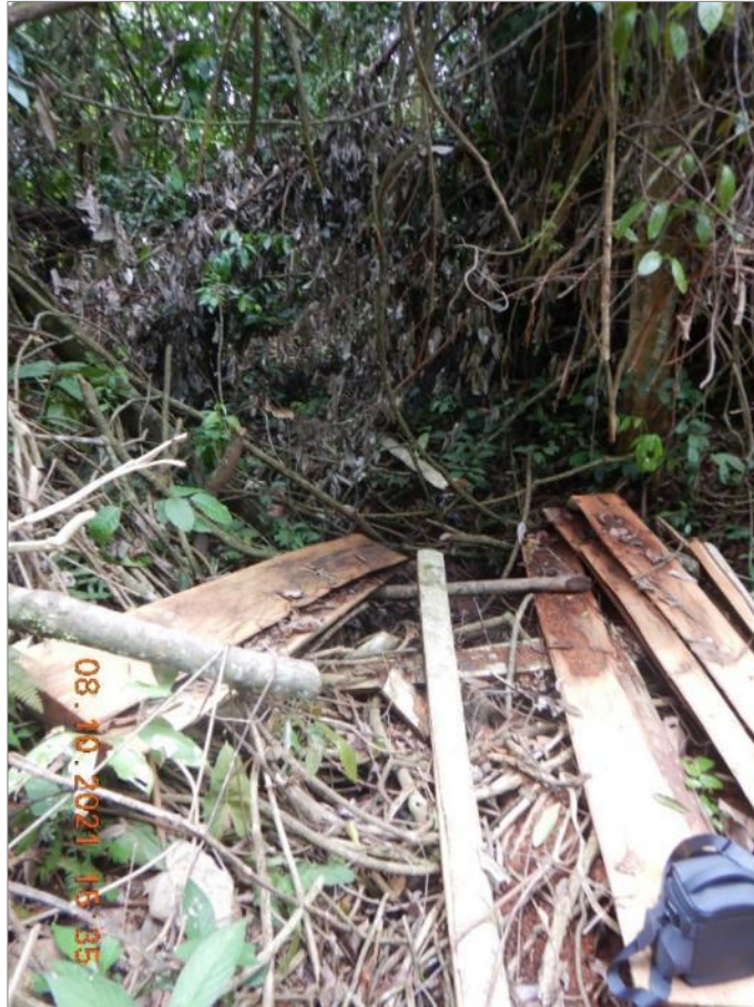
Figura 9. Vista del canal seco obstruido por la presencia de troncos dentro del mismo.
