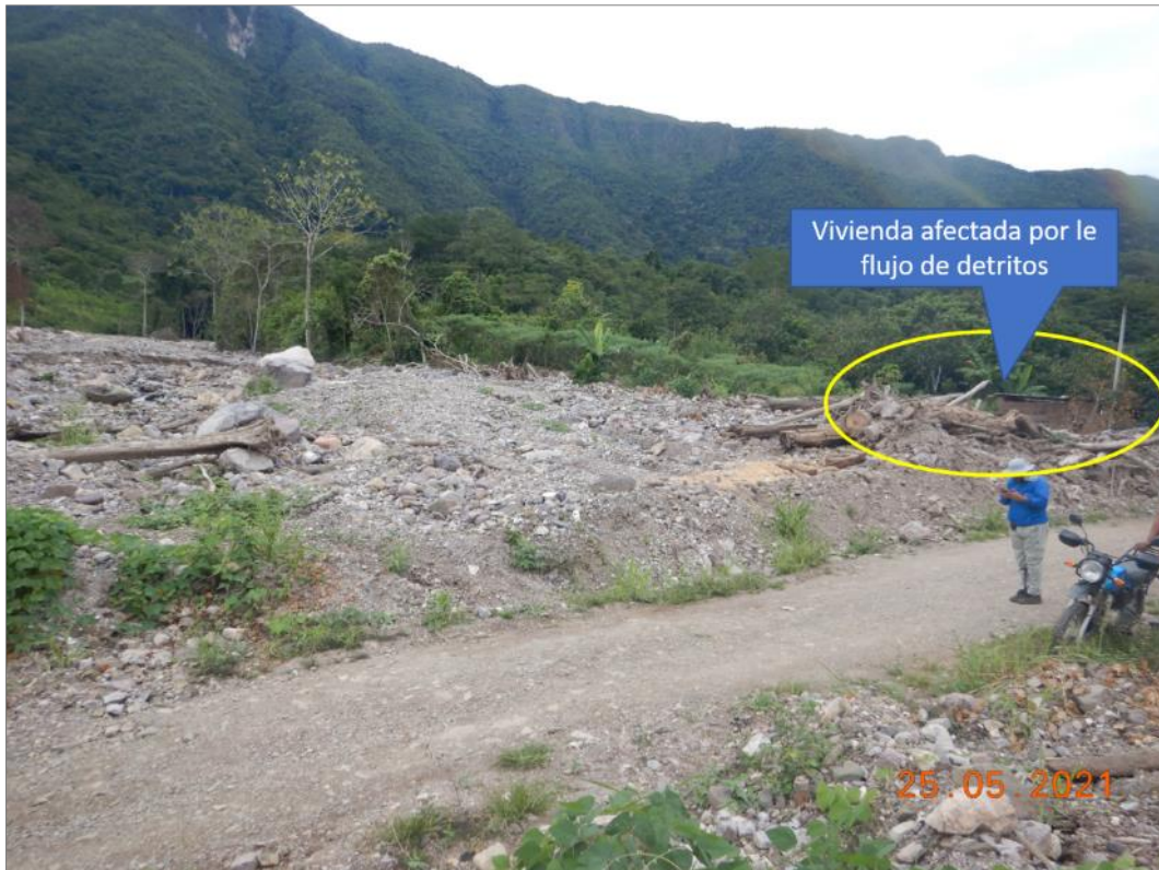
Figura 5. Viviendas afectadas por el flujo de detritos en la quebrada Macoshoato.
