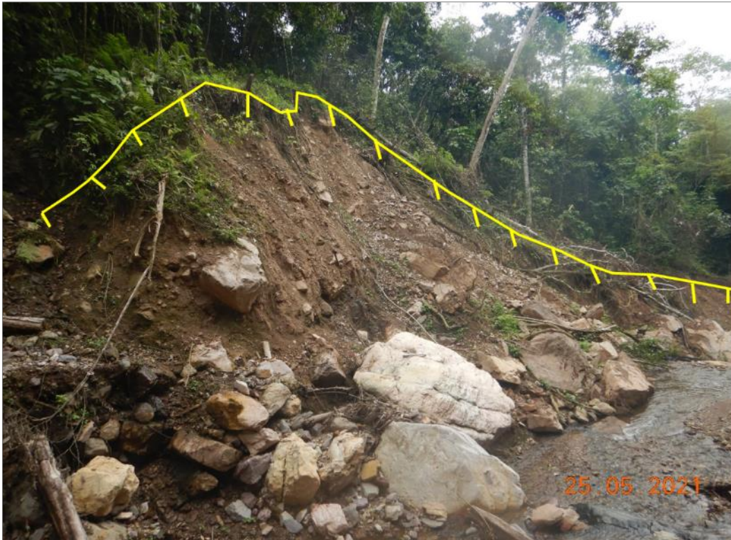
Figura 7. Derrumbes continuos en la zona media de la quebrada Macoshoato. Con coordenadas UTM: 766117, 8586600 S a 1457 m s.n.m.
