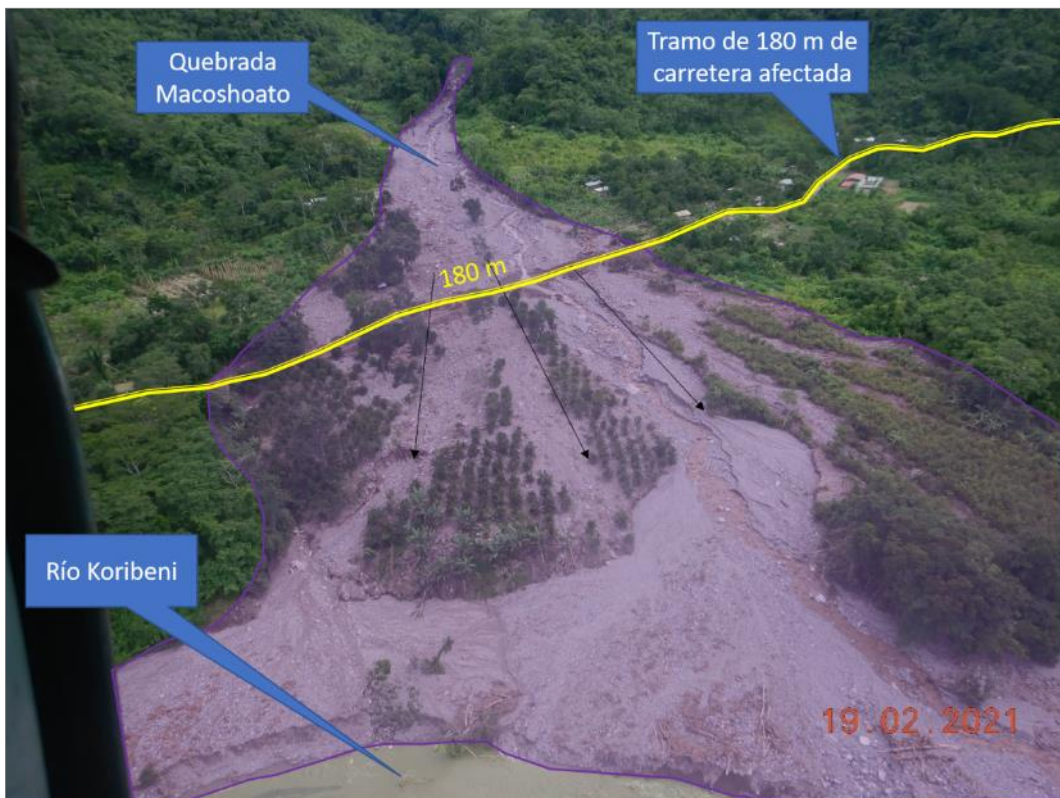
Figura 6. Vista aérea de la zona afectada por el flujo de detritos en la quebrada Macoshoato.
