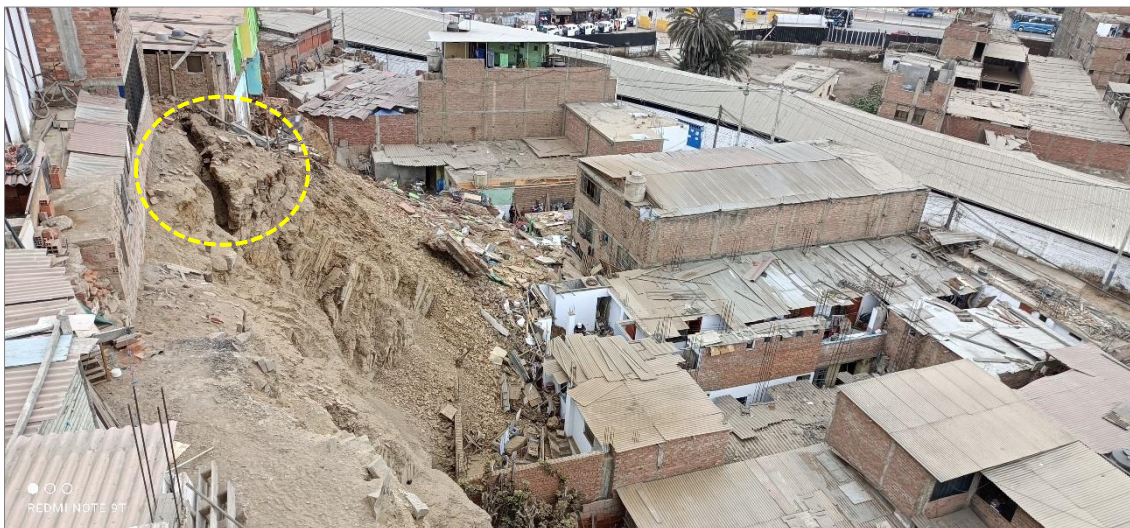
Figura 5. Vista hacia el área afectada, en la parte superior se observan rocas muy fracturadas.
