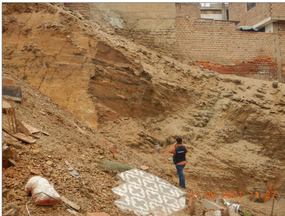
Fotografía 1. Vista de areniscas grises intercaladas con limolitas arenosas altamente meteorizadas y muy fracturadas Coordenadas UTM (WGS 84): 677031 E, 8509451 N a 3087 m s.n.m
