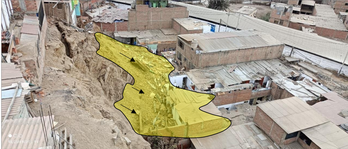
Figura 10. Vista desde la parte superior del deslizamiento donde fueron afectadas 7 viviendas.
