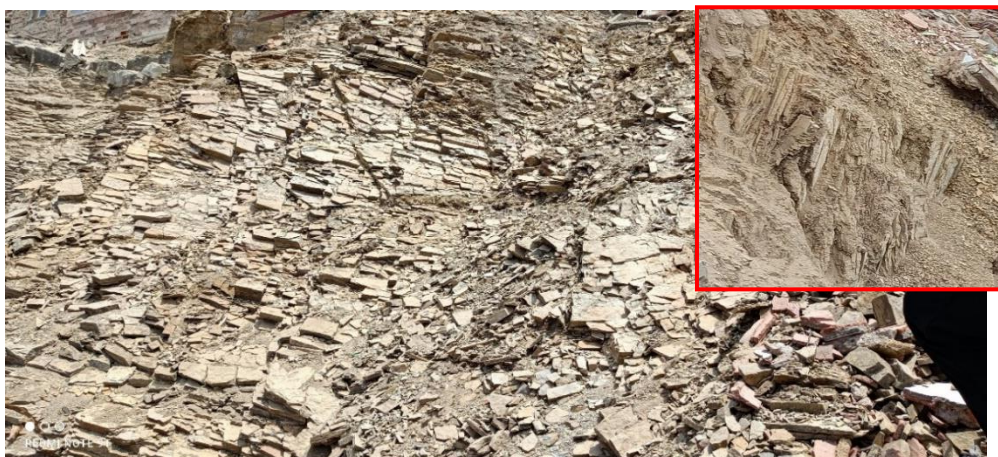
Figura 20. Vista del talud donde se ubica la estación geomecánica 04.
