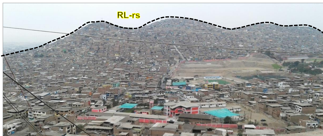
Figura 3. Vista de lomada modelada en rocas sedimentarias (RL-rs), donde ocurrió el vuelco y deslizamiento. Coordenadas UTM (WGS 84): 281688 E, 8652045 N a 27 m s.n.m.
