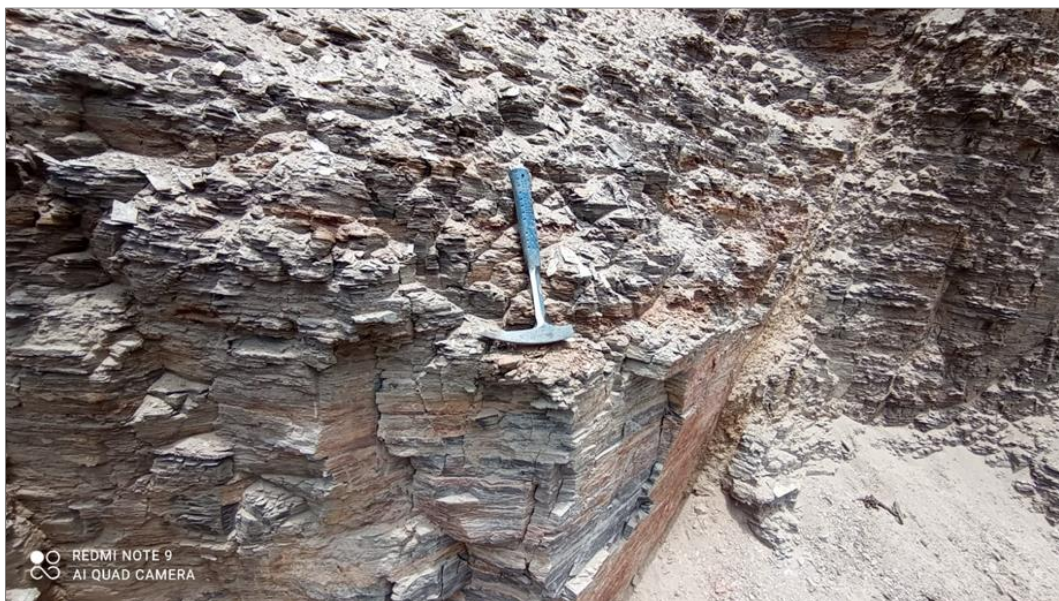
Fotografía 6. Vista del talud donde se ubica la estación geomecánica 01.
