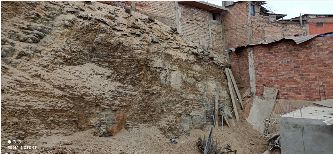
Fotografía 3. Afloramiento de areniscas y lutitas en el flanco derecho del deslizamiento.
