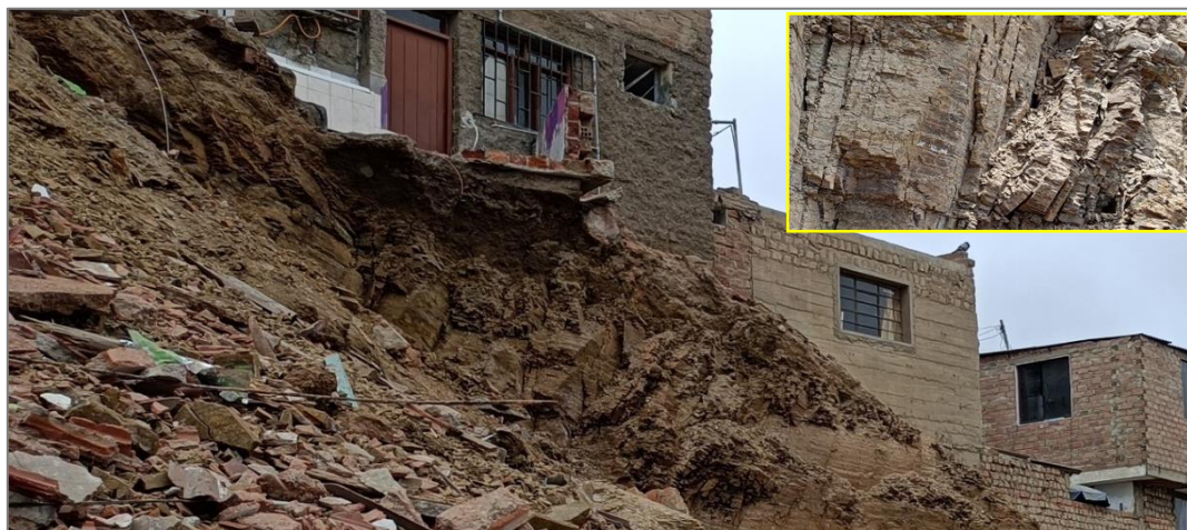
Figura 18. Vista del talud donde se ubica la estación geomecánica 03.
