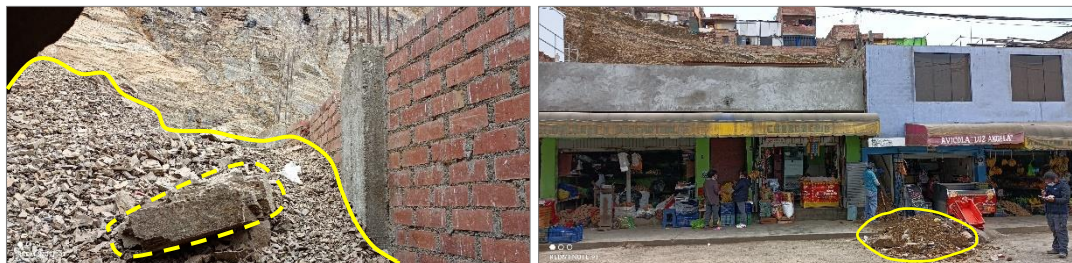
Figura 12. Los materiales desplazados entraron hacia las viviendas desde los patios traseros hacia la parte frontal con dirección a la Av. Los Próceres.
