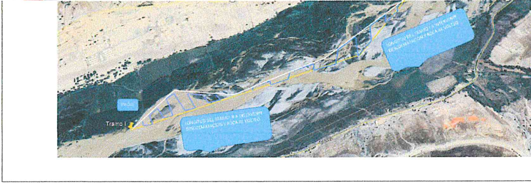
VIII.- PANEL FOTOGRAFICO DE ZONA VULNERABLE
